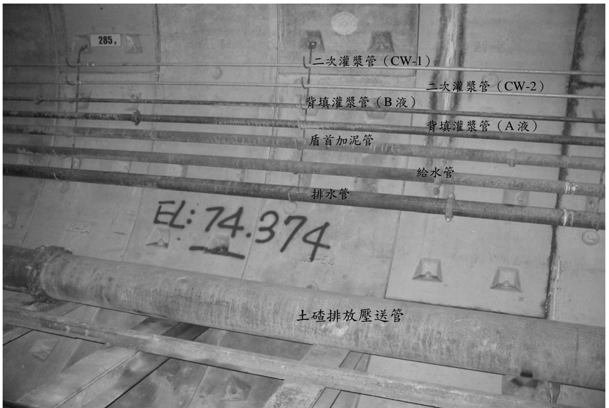
圖 4-15 (a) 隧道內部各種輸送管線
