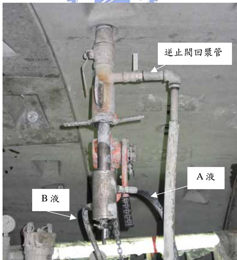
圖 4-15 (b) 背填灌漿注入施工
