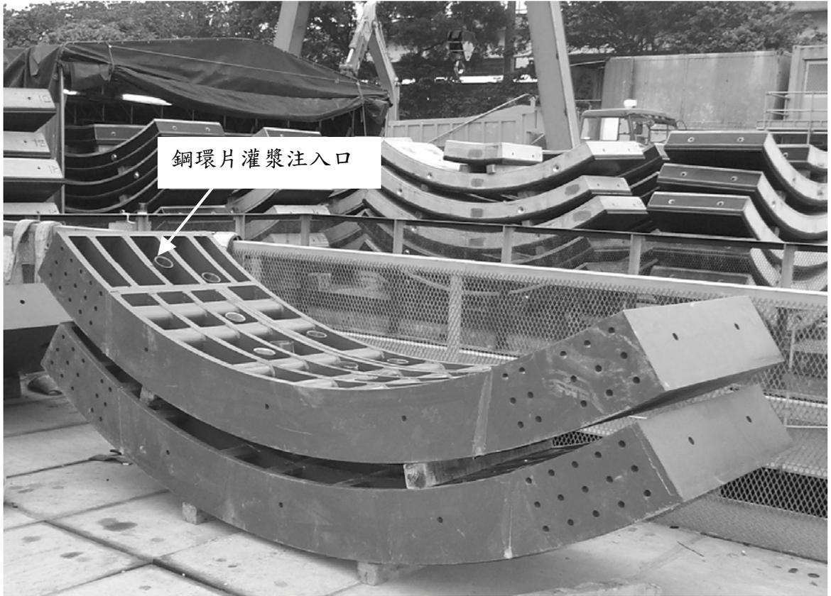
圖 4-14 聯絡通道處使用鋼製隧道襯砌環片
