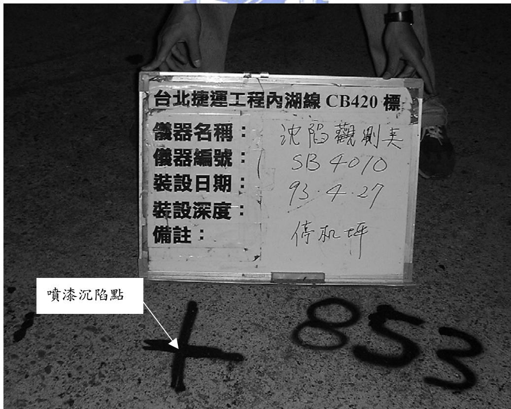
圖 4-20 機場停机坪鋪面沉陷觀測點 (SB) (摘自捷儀工程顧問公司 2003)
