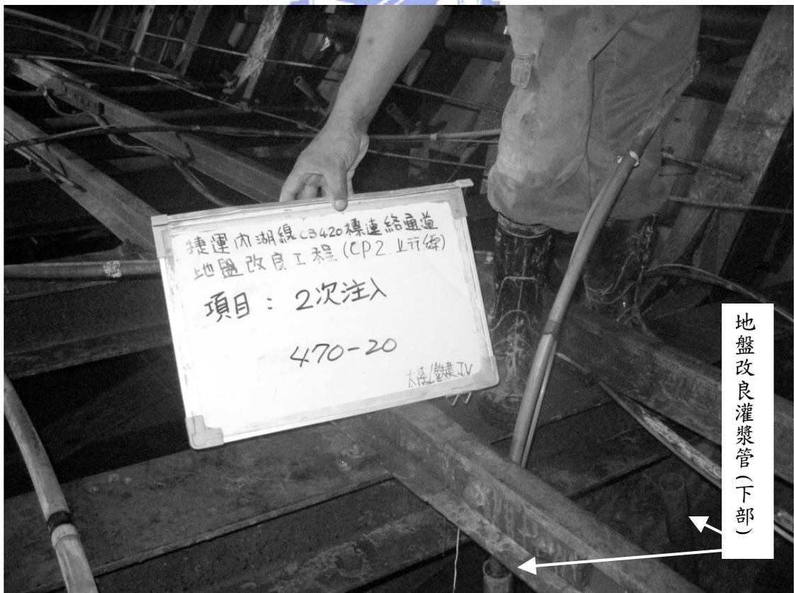
圖 6-13 隧道內裝柵管施作情形
