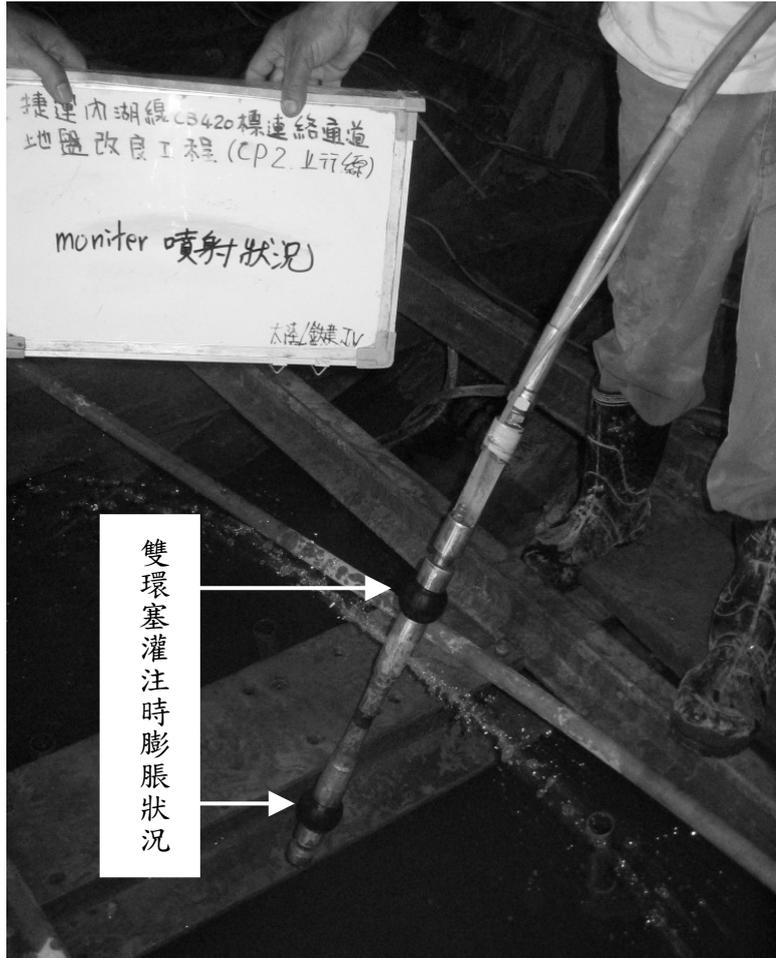
圖 6-8 雙柵管注入內管噴射情形
