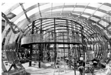
圖 1-56d.骨架組裝與施工
