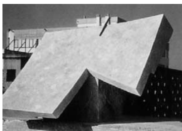
圖 1-54b.牆面由 CNC 鍛造製成
