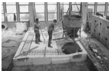
圖 1-55d. 灌注製成水泥牆面
