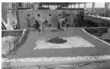
圖 1-55e. 灌注製成水泥牆面
