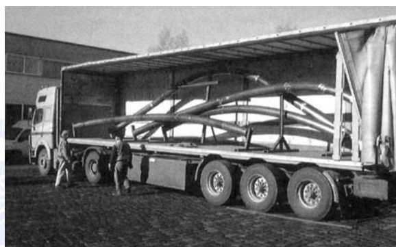
圖 3-79 局部拆解運至現場
