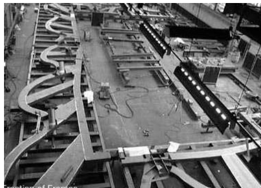
圖 3-96 Dynaframe 骨架單元切割完後進行焊接
