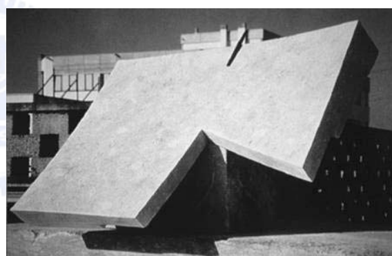
圖 3-28 每片不同形體石材由 CNC router 切割
