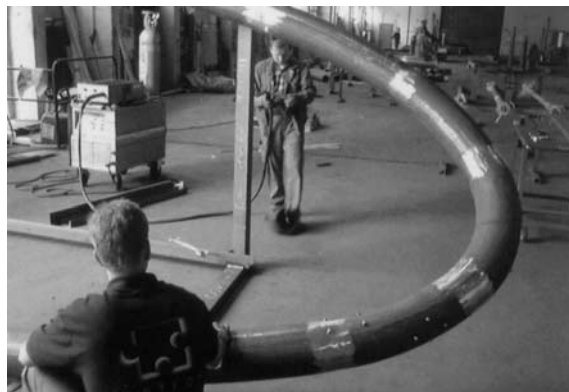
圖 3-76 工廠預組裝(空間定位假支撐)
