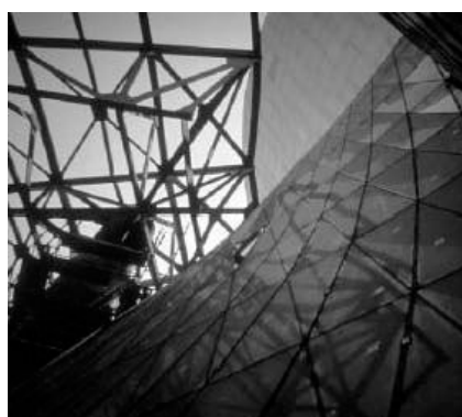
圖 3-30 三角玻璃組成的自由形玻璃帷幕
