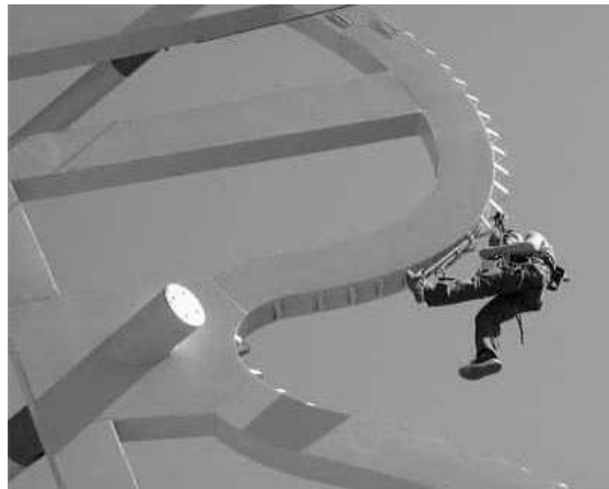
圖 3-102 登山隊將薄膜固定於骨架上
