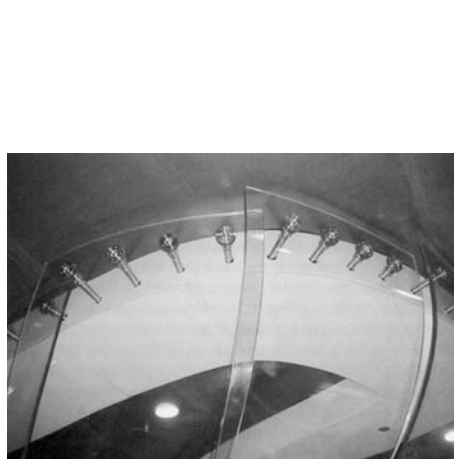
圖 3-54 抓勾精準與多向度曲面玻璃結合
