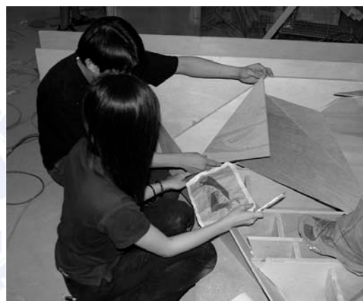
圖 4-47 現場依編號標示圖進行組裝
