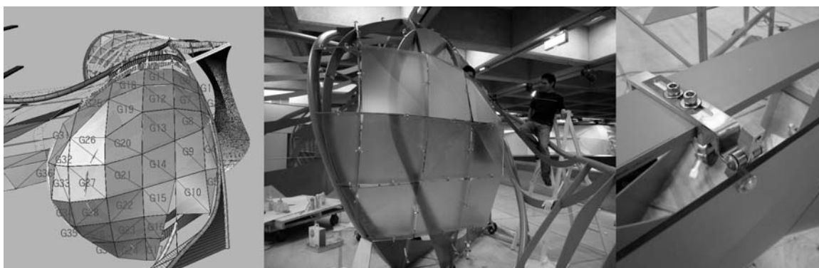
圖 5-83 現場組裝：壓克力折板安裝
