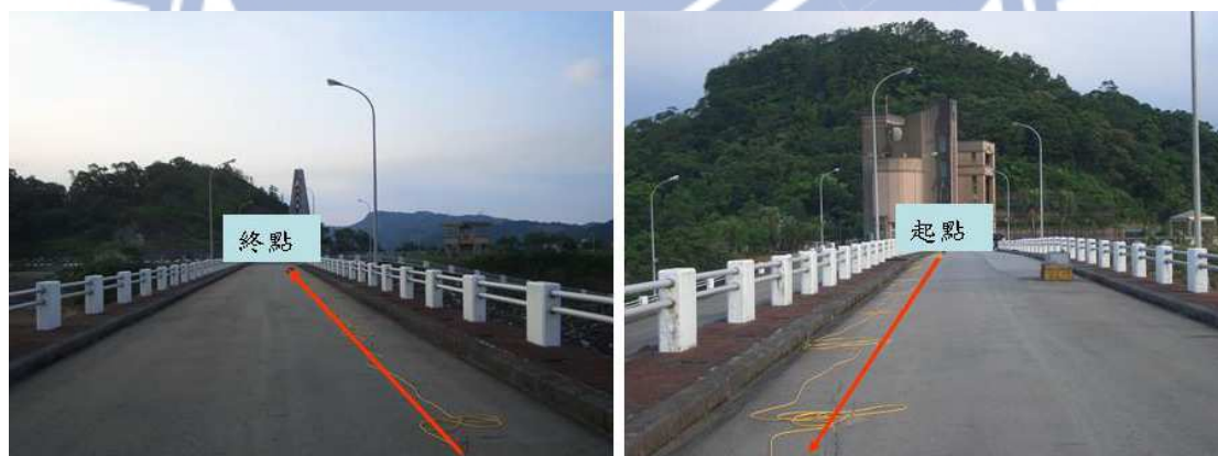
圖 3-27 新山水庫測線 A (壩頂) 施測情形
