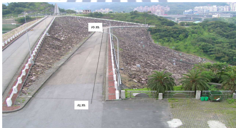
圖 3-29 新山水庫測線 B (殼層) 施測情形
