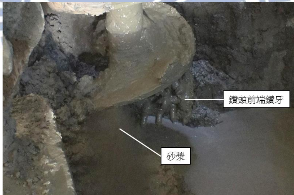
圖 4.24 砂漿自螺旋鑽桿之鑽頭噴出澆置
