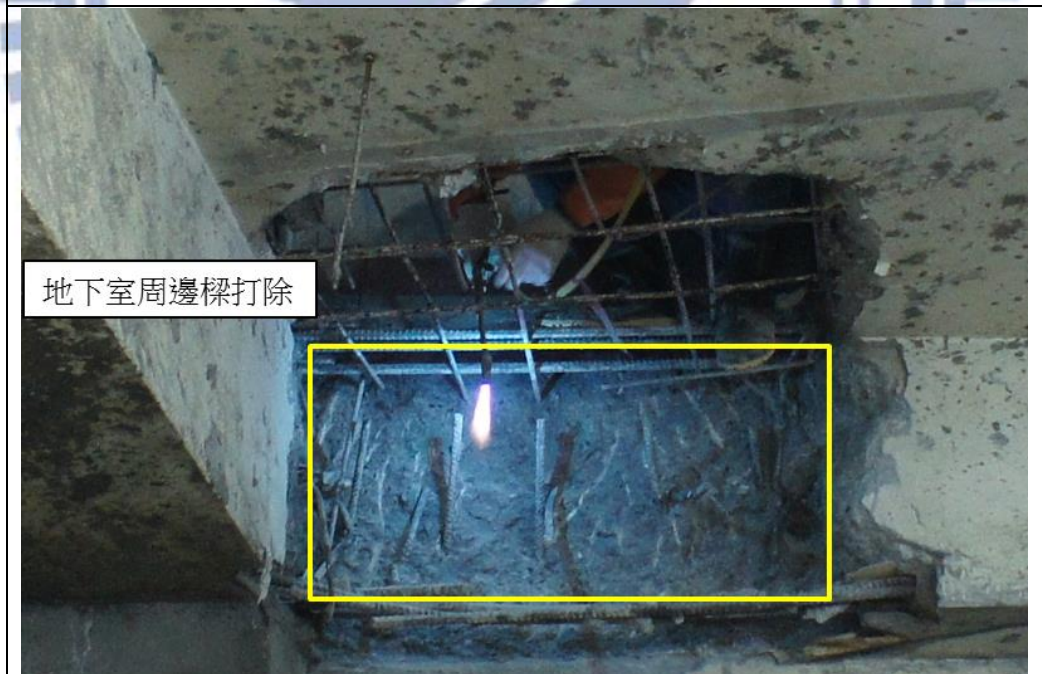
b. 將既有地下室周邊樑打除
