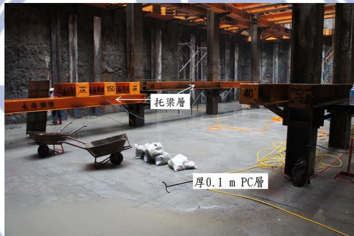
圖 5.10 構築 B3FL 前置作業
