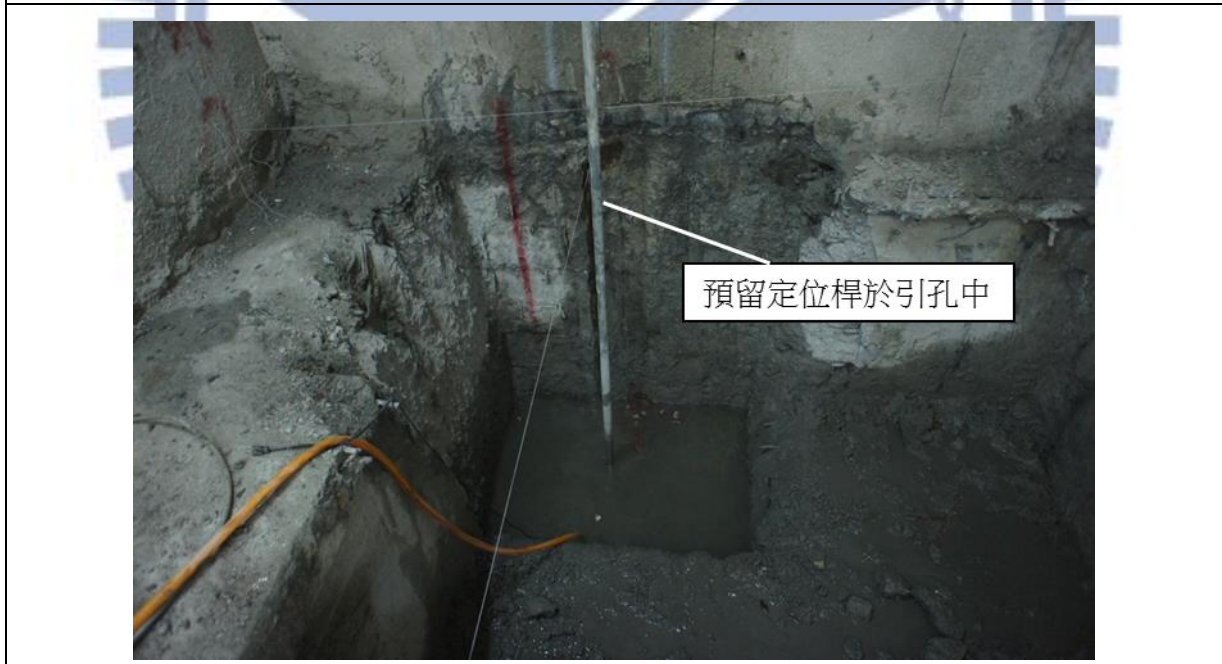
b. 引孔完成並預留孔中下定位桿
