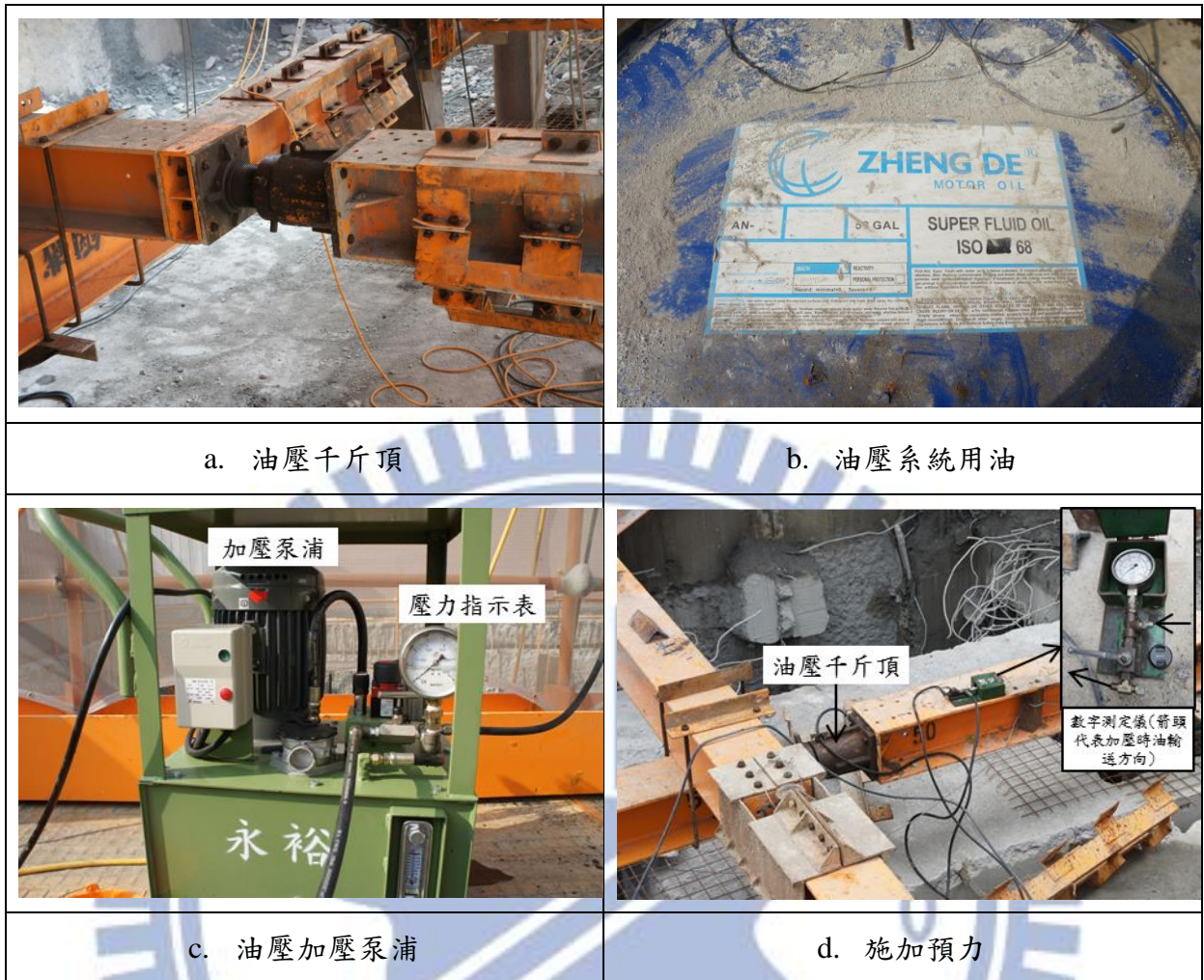
圖 5.6 以油壓千斤頂施於水平橫撐施加預壓力
