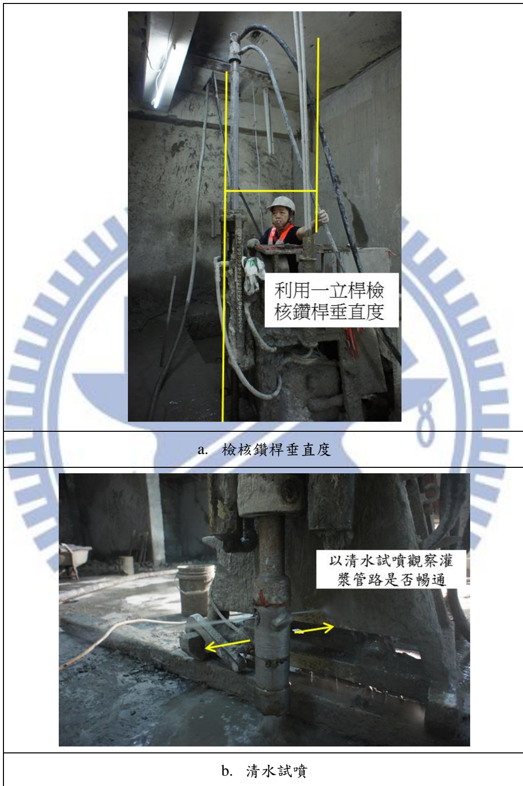
圖 4.8 鑽機定位及清水試噴
