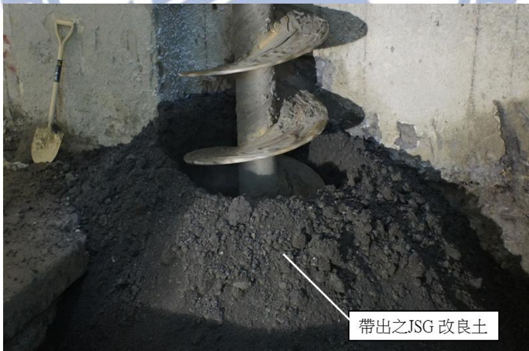
圖 4.22 螺旋鑽桿向下鑽掘帶出 JSG 改良土體
