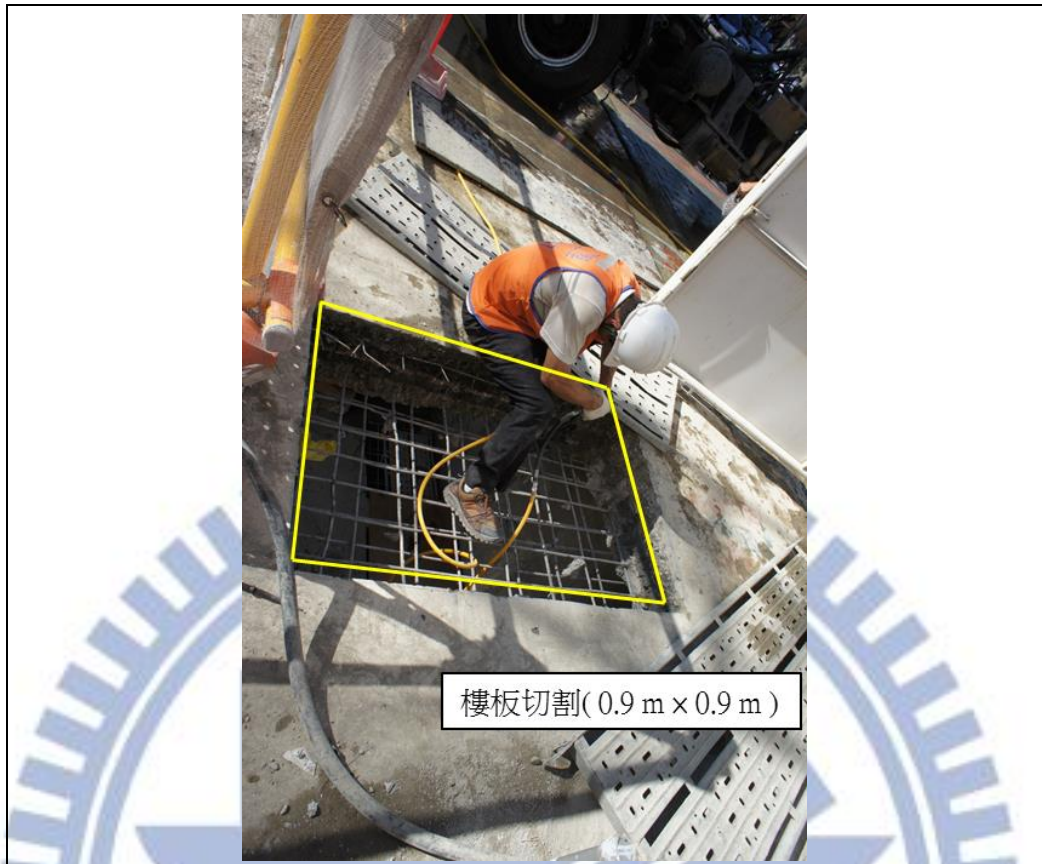
a. 切割既有樓版及打除混凝土
