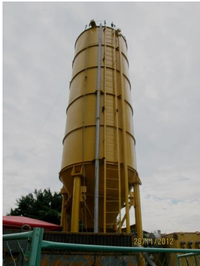
a. 水泥儲存槽
