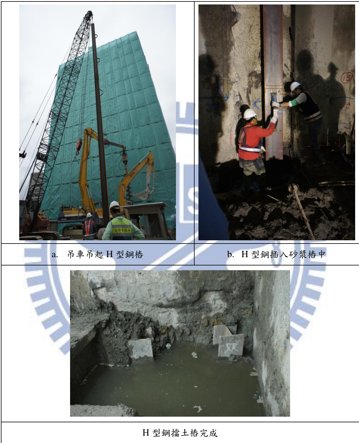
圖 4.26 H 型鋼樁吊放插入砂漿樁
