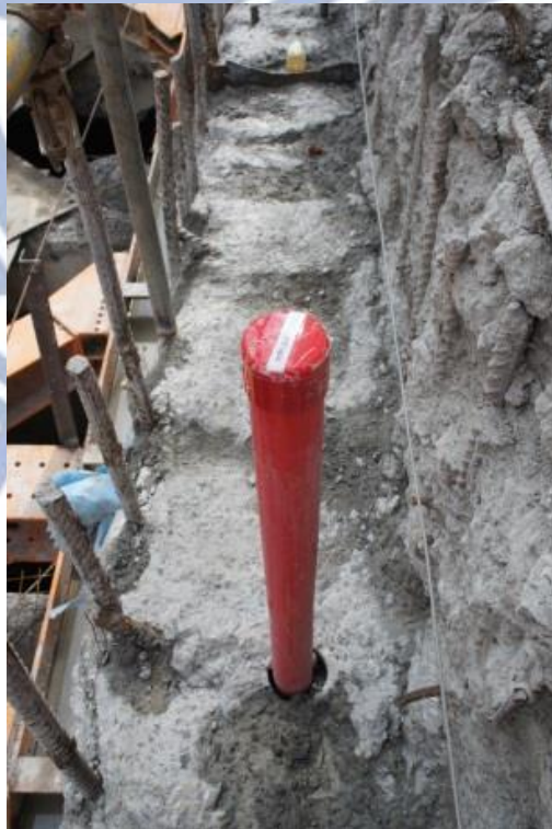
圖 3.16 舊連續壁體內傾度管
