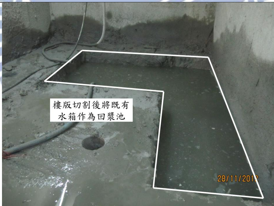
a. 樓版切割示意圖 (摘自森城建設公司, 2012)
