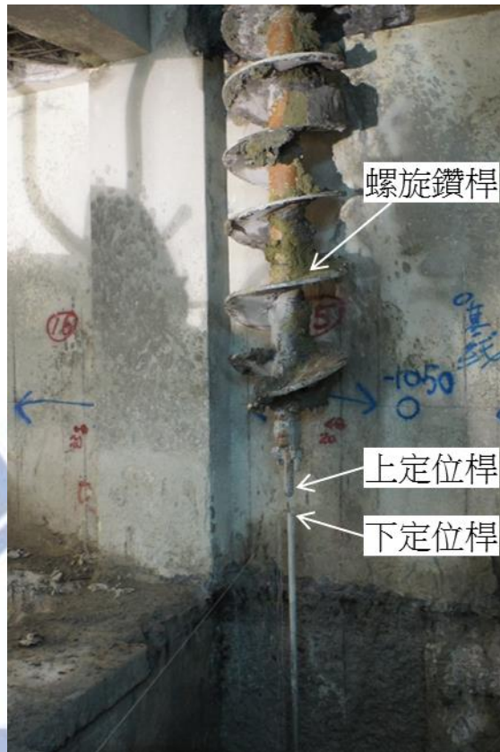
圖 4.21 螺旋鑽桿前端之上定位桿與鑽孔中之下定位桿
