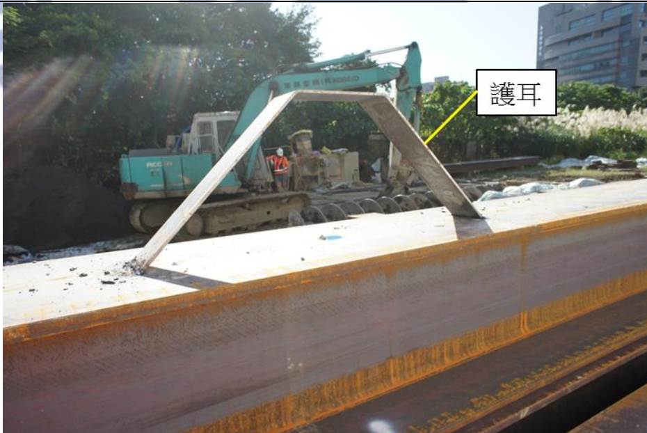
b. H 型鋼上焊接護耳(GL. -15.0m, -19.5m, -24.0m, -28.5m, -33.0m)
