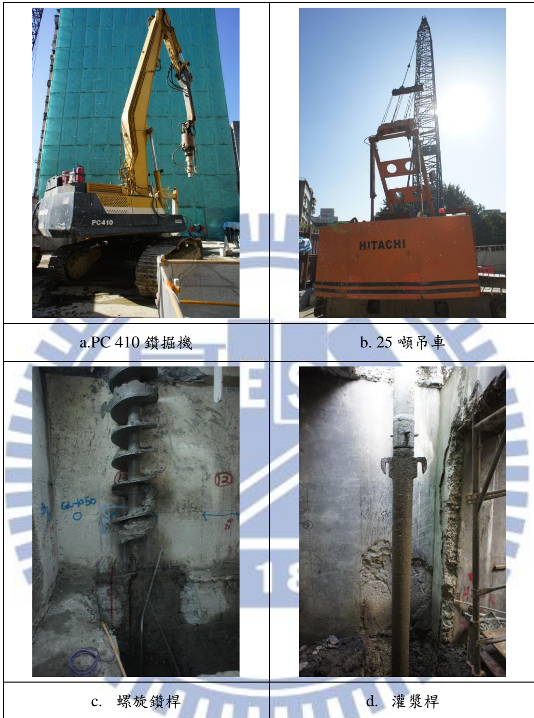
圖 4.14 H 型鋼擋土樁施作機具
