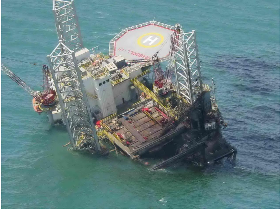
圖 1-4 鑽油平台支撐腳發生貫穿式破壞
