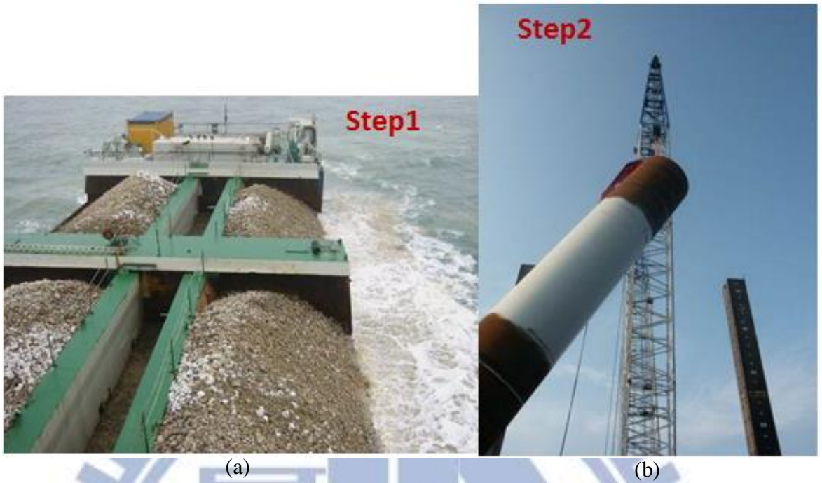
圖2-8 基礎沖刷防護層級配料鋪設及基礎吊裝(摘自呂威賢 2012)
