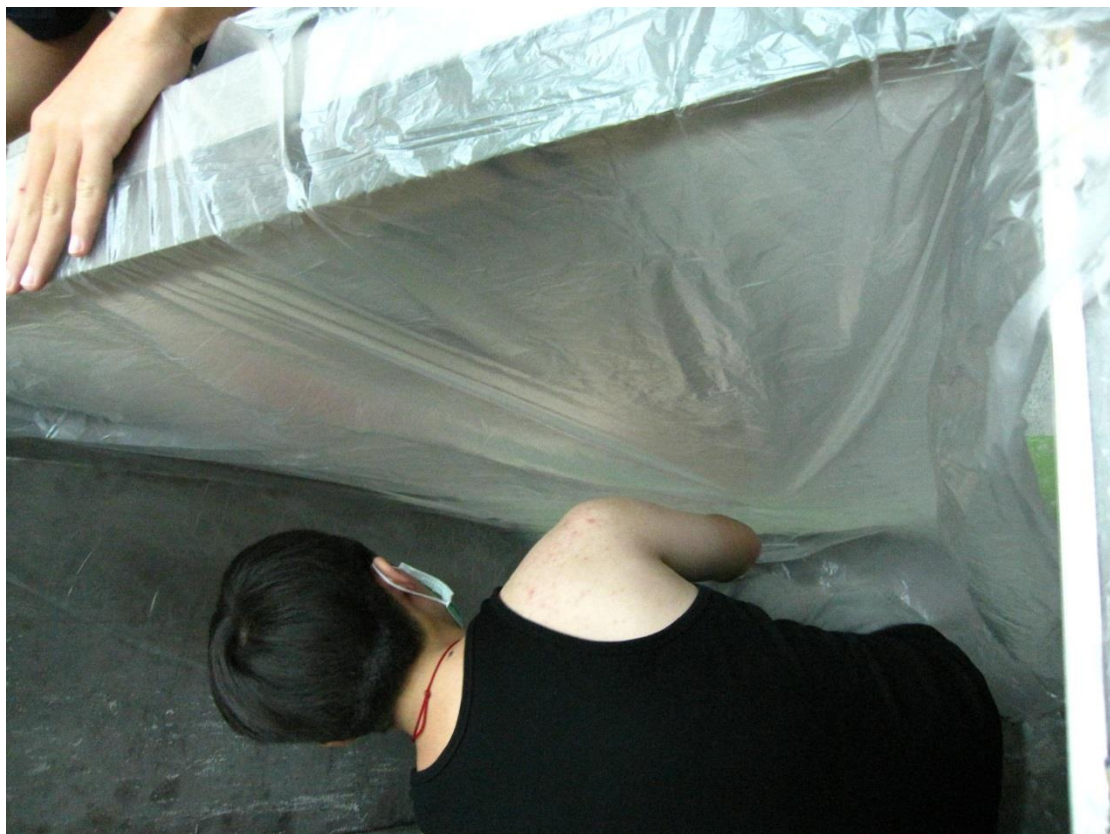
圖 5-11 將塑膠膜鋪設於壓克力牆內側
