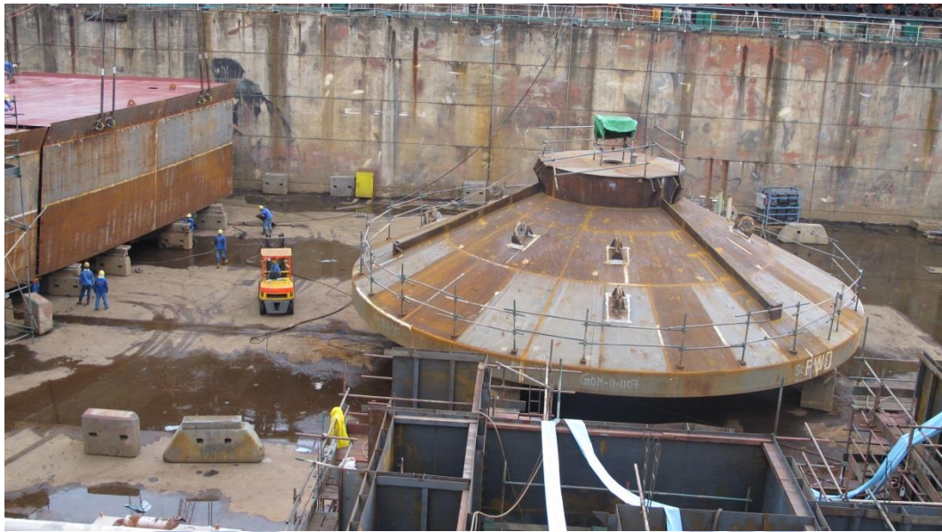
圖 2-14 鑽油平台之支撐基腳
