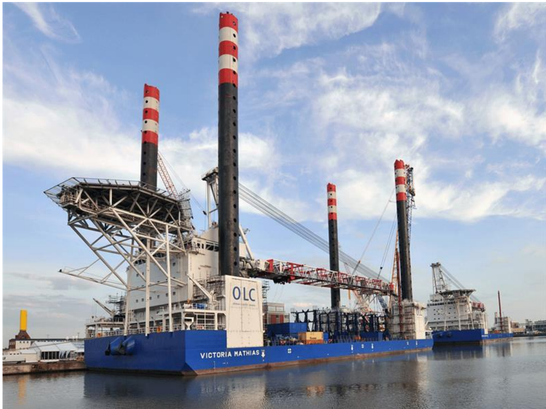
圖 2-6 自升式安裝船支撐腳收縮至船身上方
