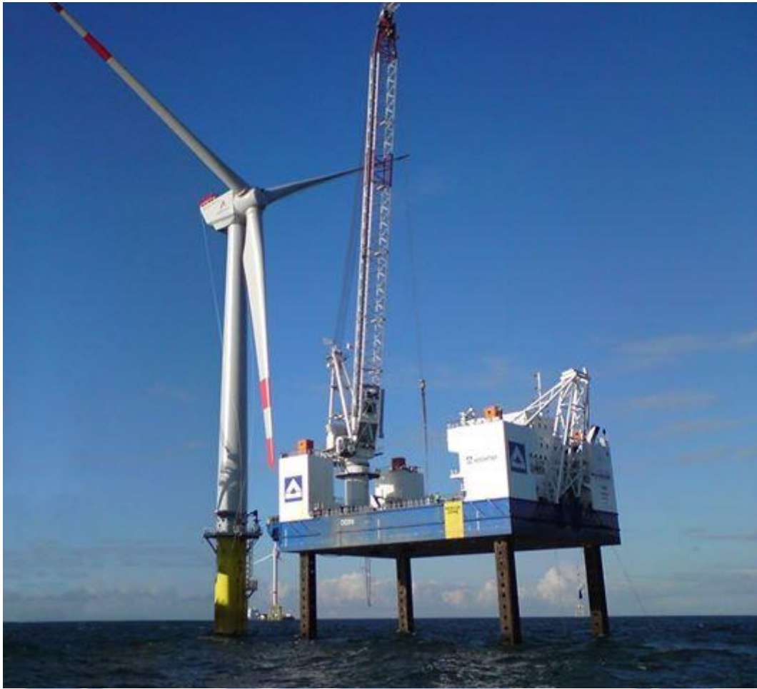
圖 1-2 自升式安裝平台船安裝離岸風機
