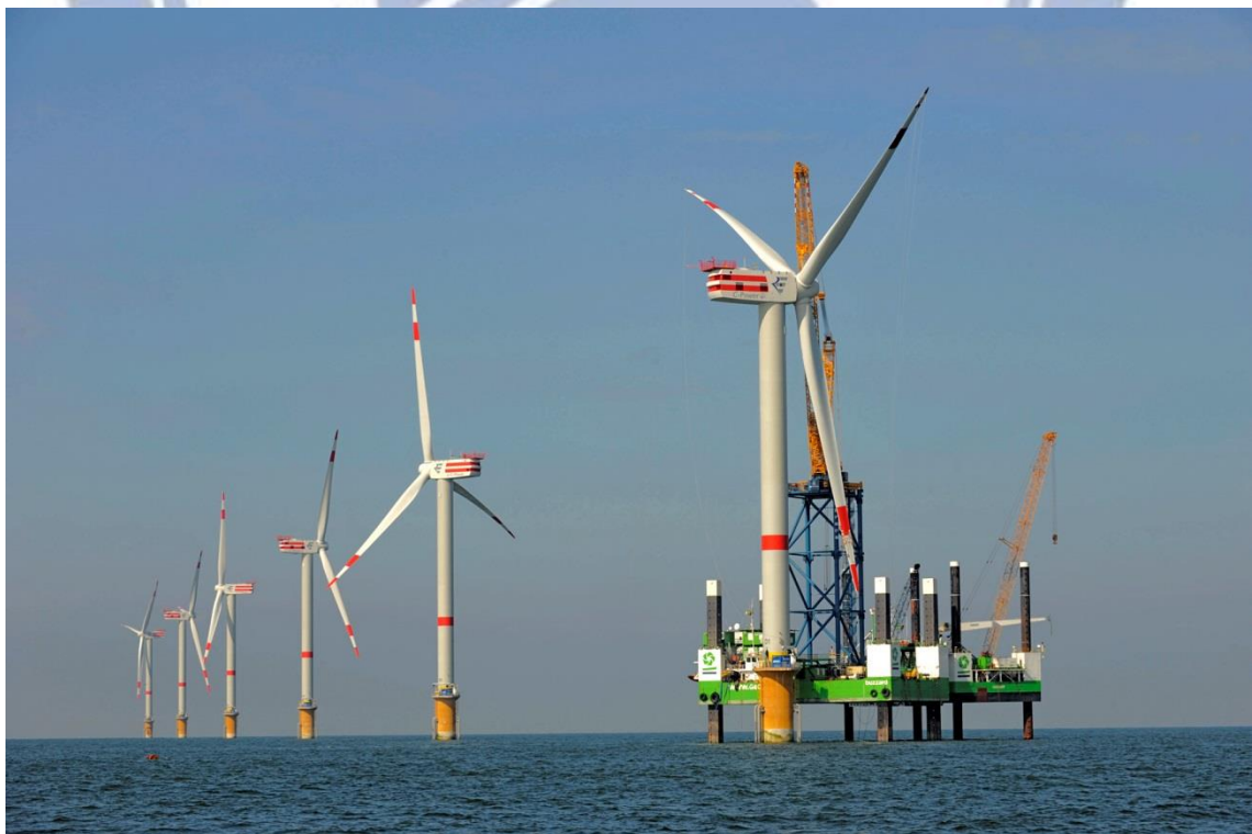
圖 2-5 自升式平台船安裝離岸風機
