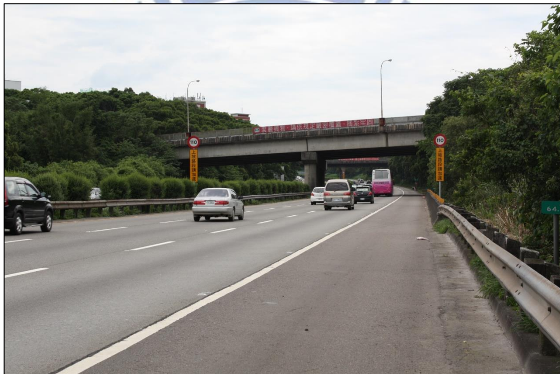
圖 3-4 64.77 k 輔助標誌設置情形
