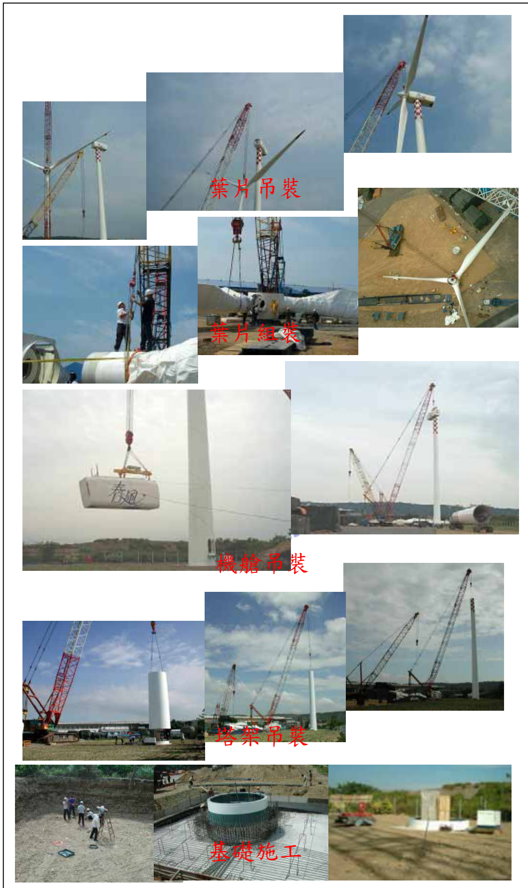
圖 3-10 春風風力發電示範系統施工記錄
