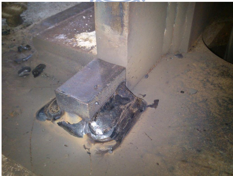
圖 4.14 側向滑移束制用鋼板
