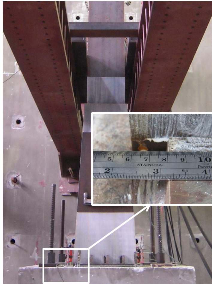
圖 4.13 鋼柱側向嚴重滑移
