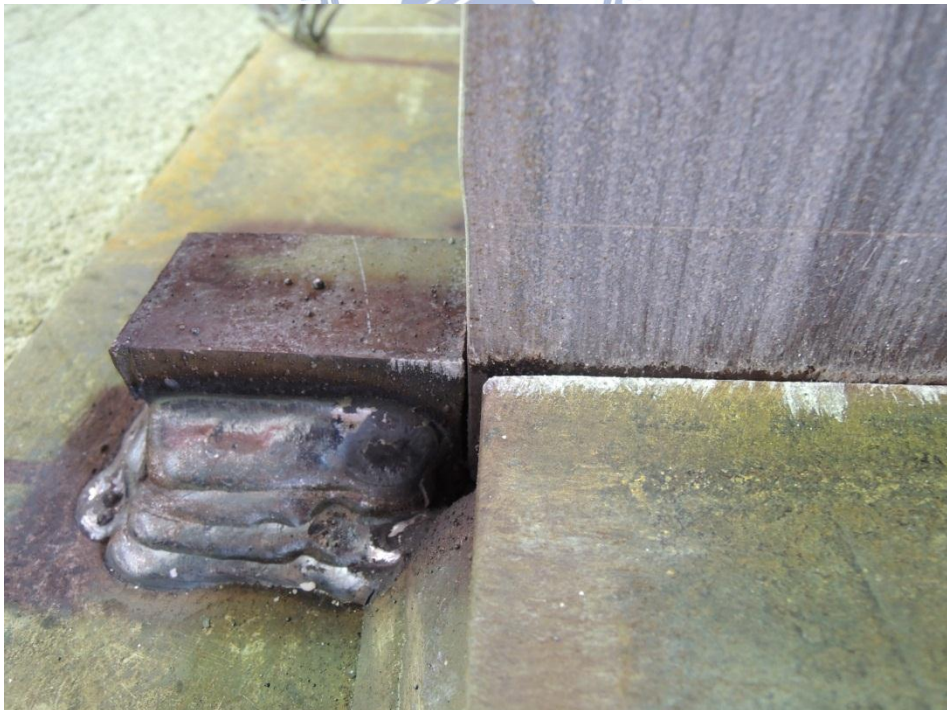
圖 4.16 鋼柱西向滑移頂至束制用鋼板
