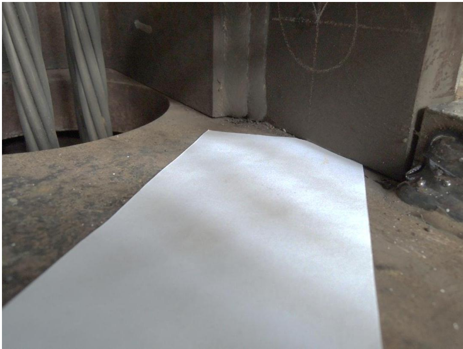
圖 4.15 間隙開啟且可放入一張 A4 厚度紙張
