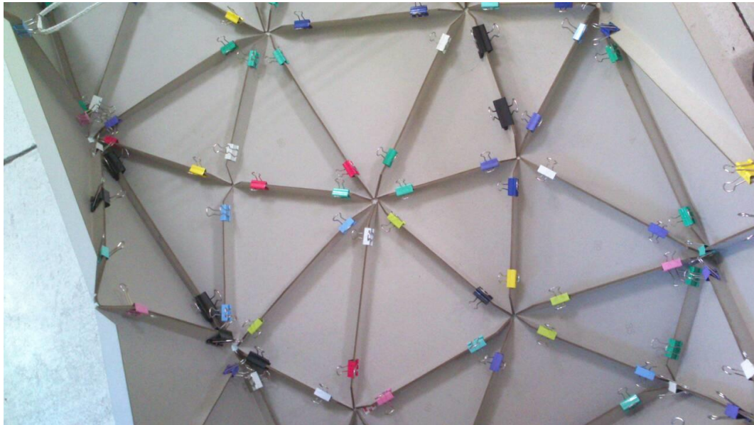
圖 4- 17 先利用燕尾夾快速的固定
