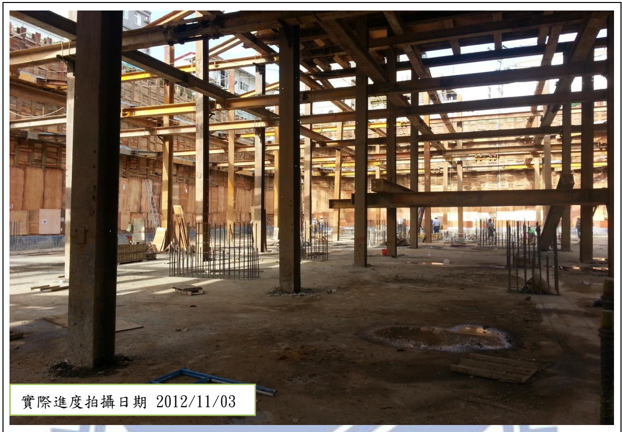
圖 4.34 實際工程進度
