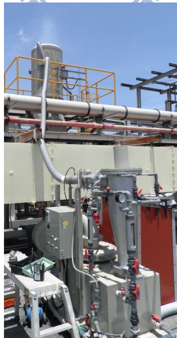
圖 3.2 實場測試濕式靜電旋風集塵器的照片。
