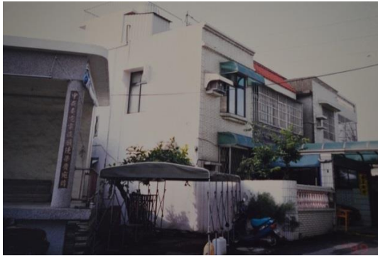
中正台後方的家屋（拆除前）
