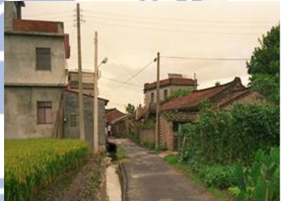
聚落巷道-加強磚造樓房建築
