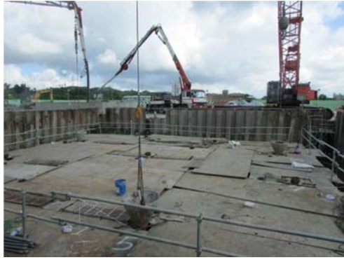
(a) 沉箱上方鋪設鋼板形成工作平台
