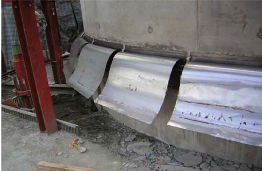
圖 2-13 沉箱外側之 NF 膜 (圖摘自台北市政府捷運工程局，2008)
