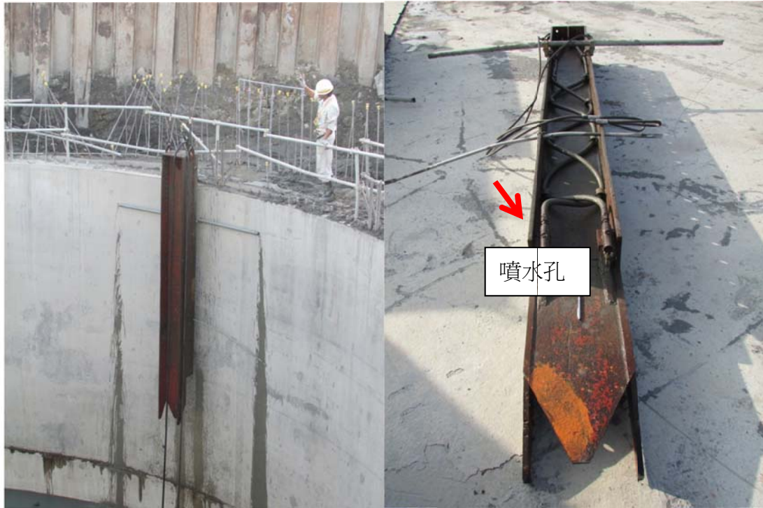
(a) 設備吊入水中圖
