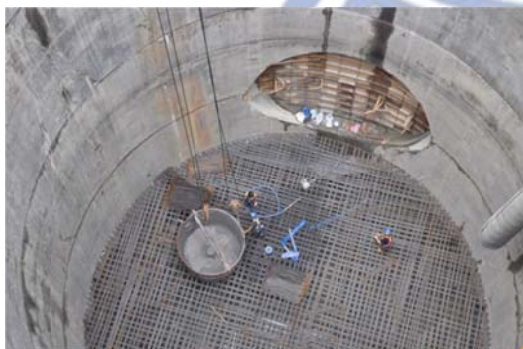
(a) 底板鋼筋綁紮
