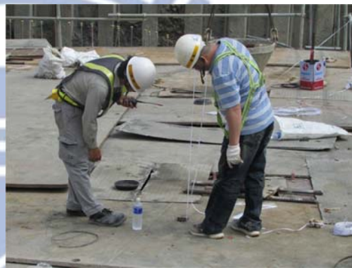
(d) 確認水中混凝土深度
