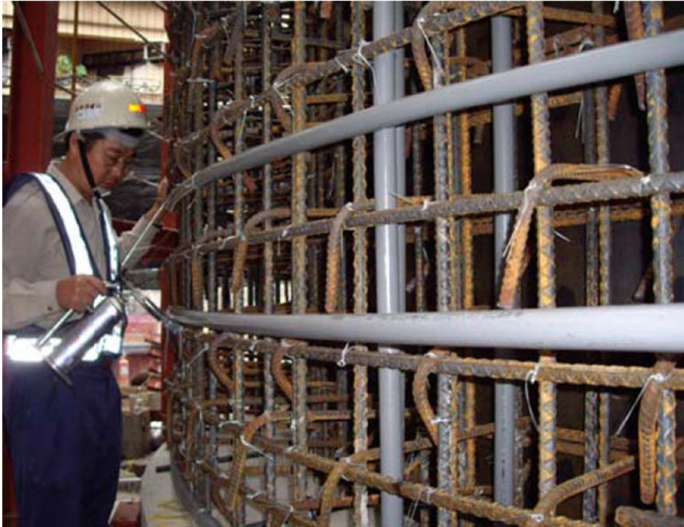
(a) 設置箱體內噴流管
