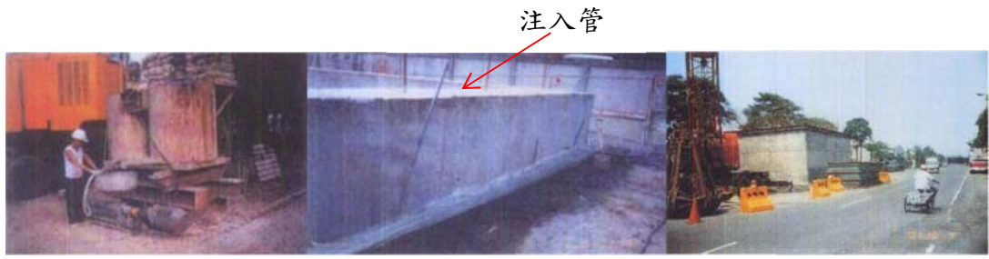
(a) 注泥設備 (b) 注入管與注入位置 (c) 開挖沉設
