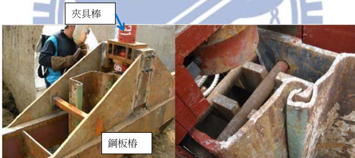
(a)鋼板樁與夾具棒連結圖
