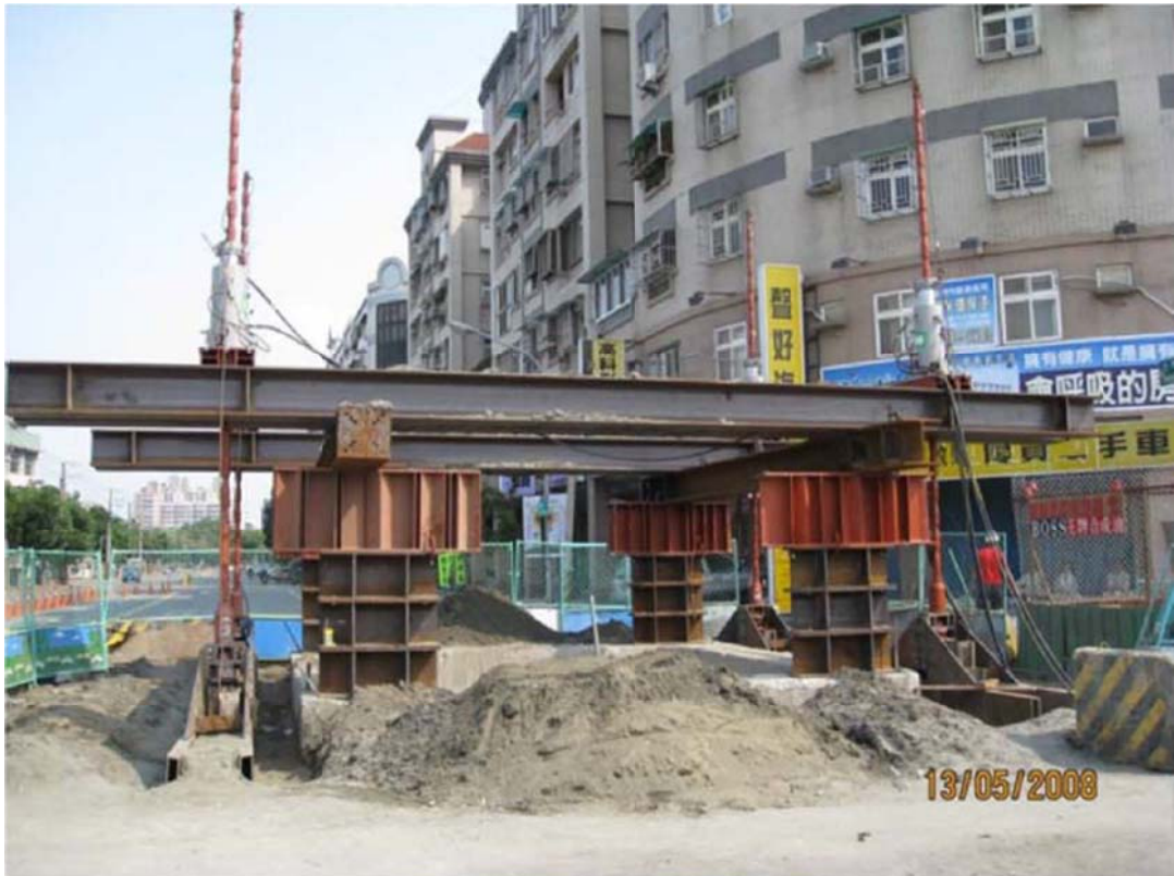
圖 3-15 高雄一號沉箱施工現場 (摘自蔡惠文, 2011)
