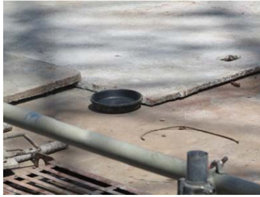
(b) 特密館內以橡皮碗確保混凝土不會於管內與水混合
