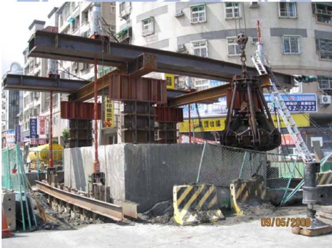
圖 3-16 反力鋼板樁上浮 (摘自蔡惠文, 2011)
