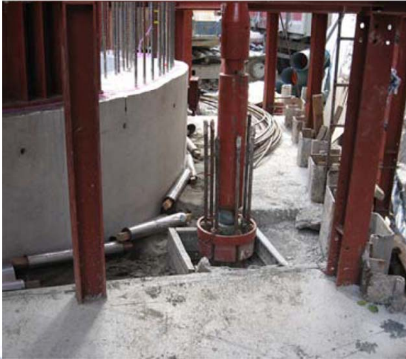
圖 2-7 地錨連結至竹節形夾棒 (圖摘自台北市政府捷運工程局，2008)
