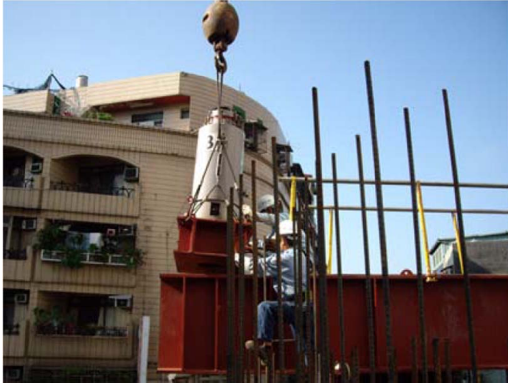
圖 2-11 千斤頂與加壓桁架 (圖摘自台北市政府捷運工程局，2008)
