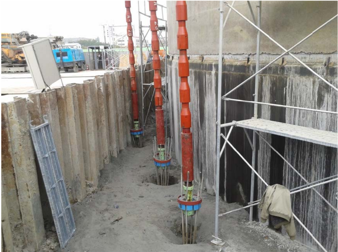
圖 4-11 竹節鋼棒與地錨之連接處
