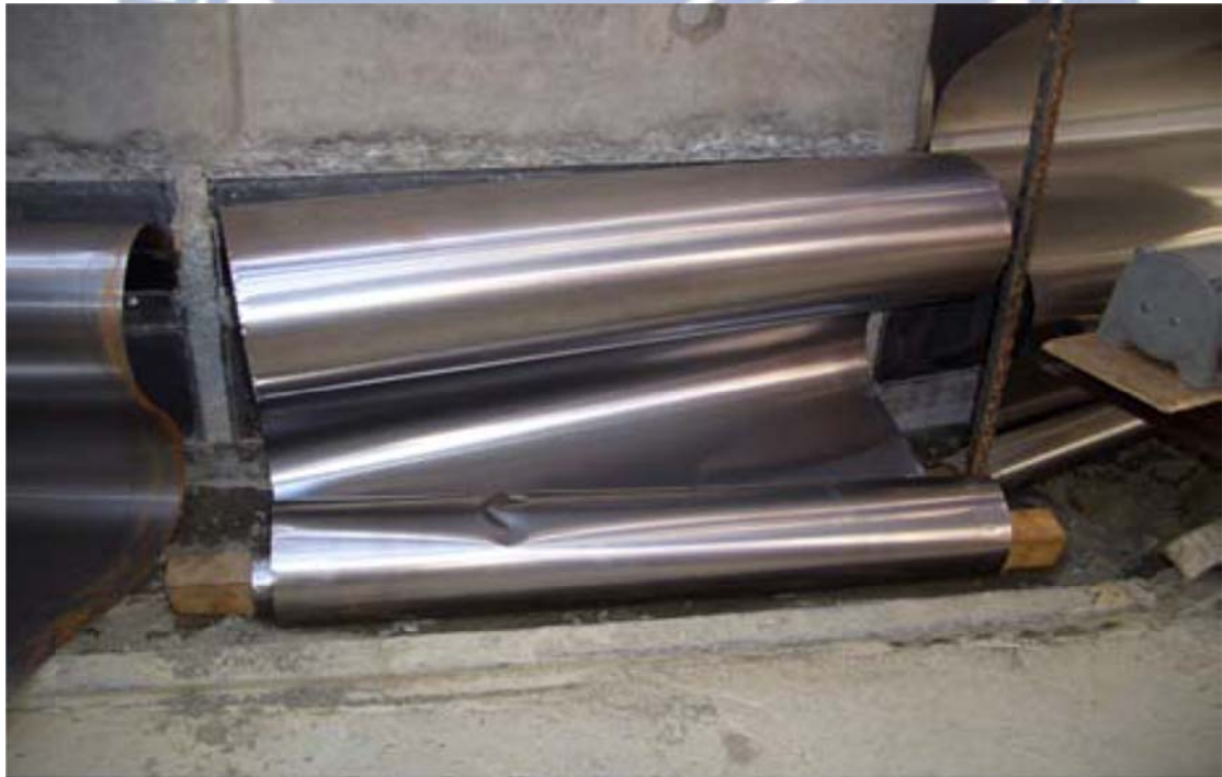
圖 2-16 沉箱壁外拉出之 NF 膜 (圖摘自台北市政府捷運工程局，2008)
