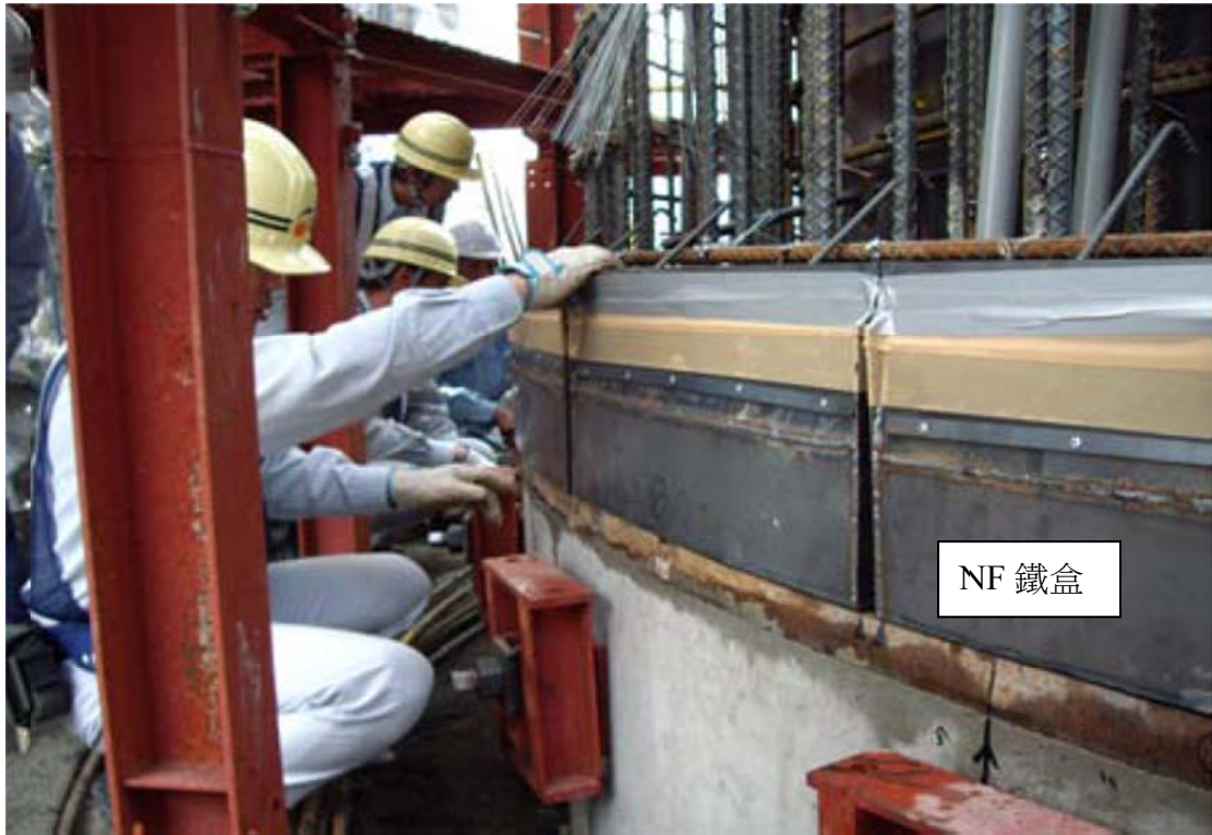
圖 2-15 安裝 NF 膜鐵盒 (圖摘自台北市政府捷運工程局，2008)
