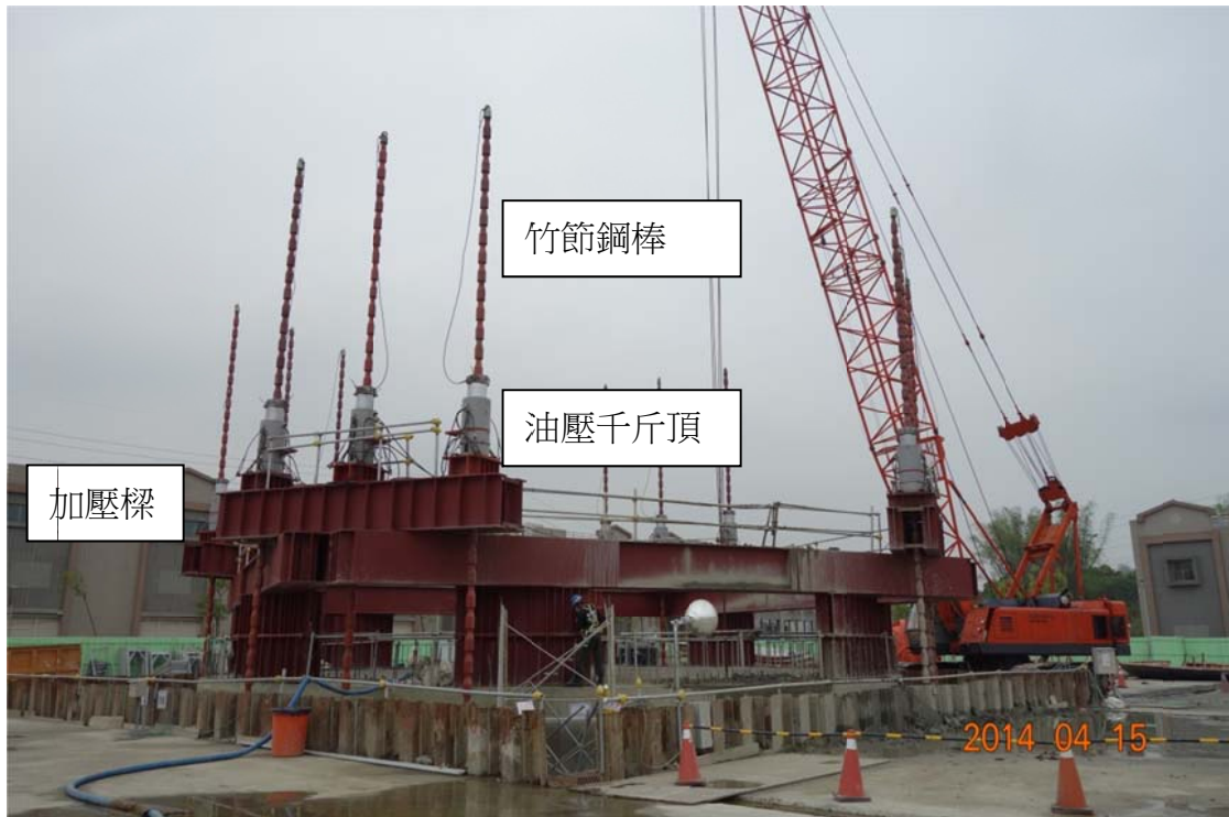
圖 4-5 壓入沉箱反力系統
