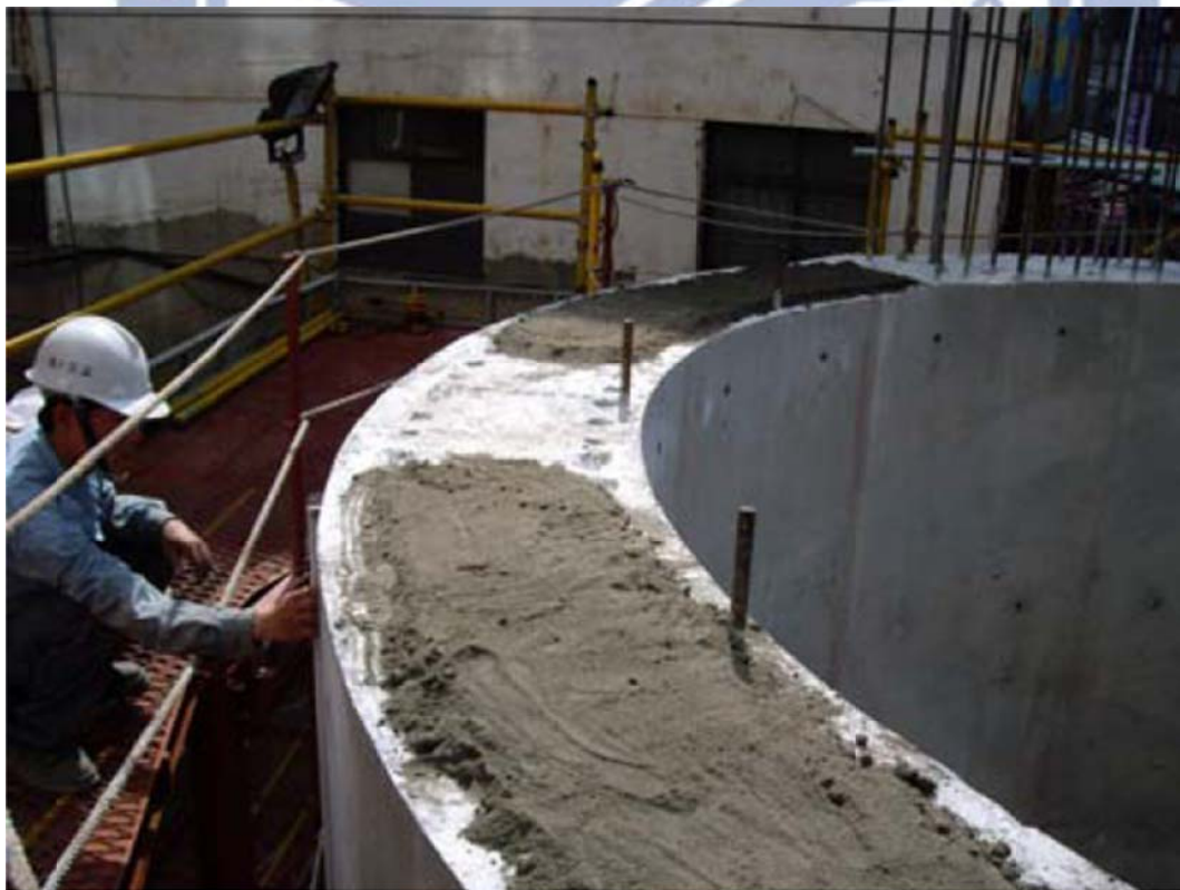
圖 2-12 加壓處鋪砂以均勻承載面之壓力 (圖摘自台北市政府捷運工程局，2008)
