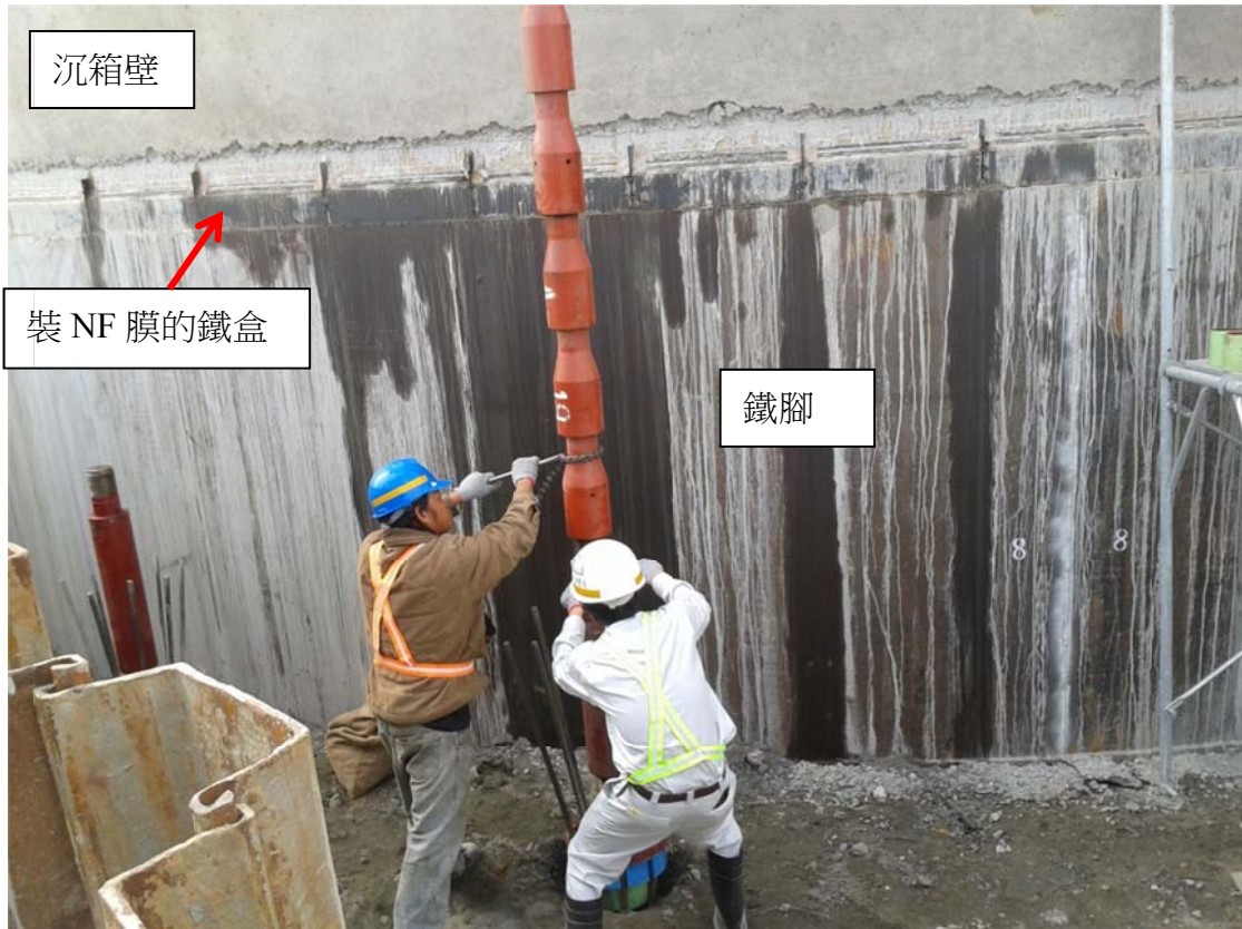
圖 4-17 焊在鐵腳上內裝 NF 膜的鐵盒
