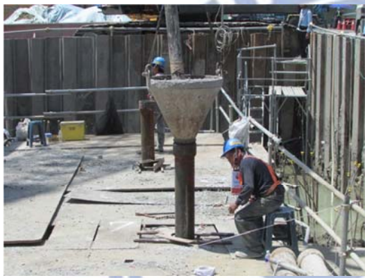
(c) 以特密管澆置水中混凝土
