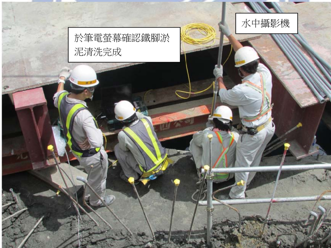
圖 4-25 以水中攝影機確認鐵腳處淤泥清洗完成
