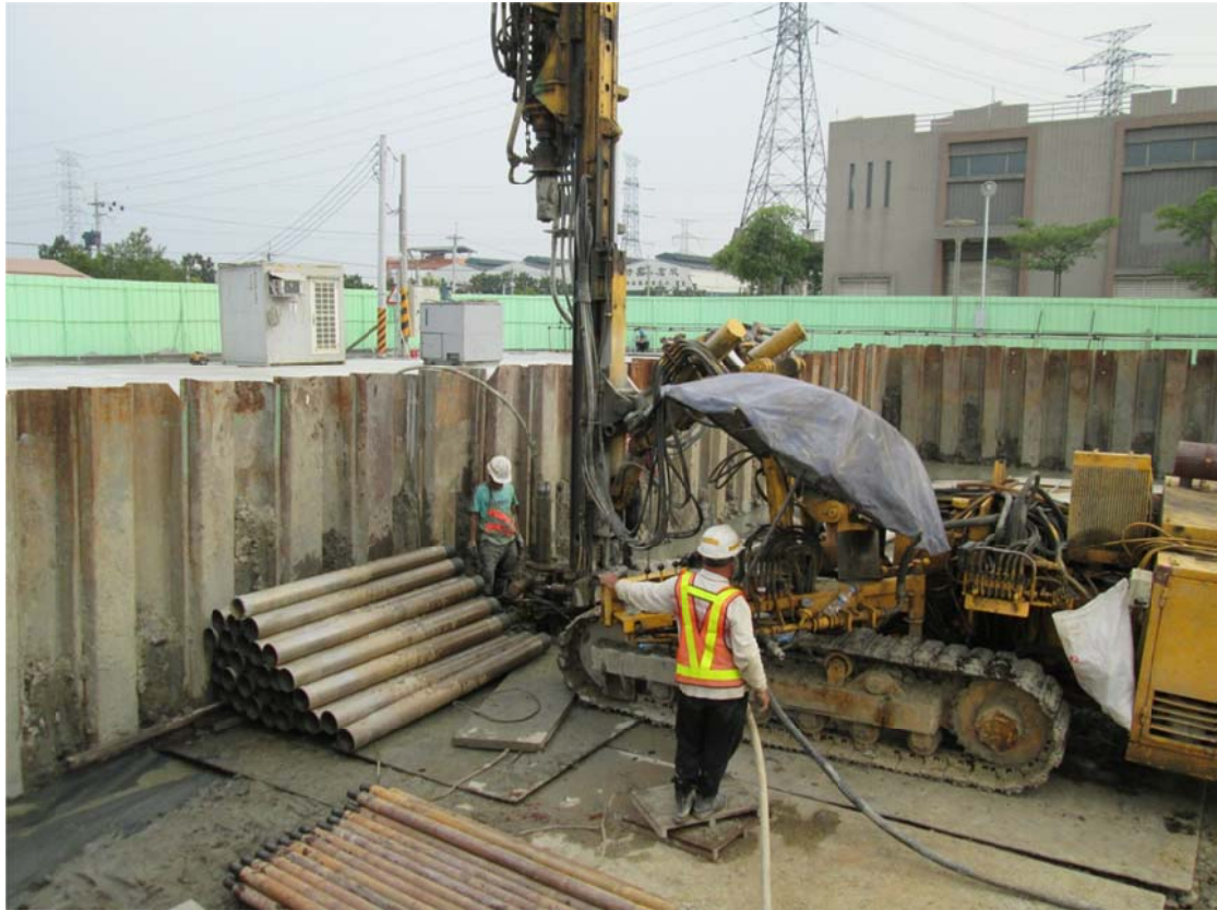
圖 4-3 於降挖地面上施作地錨
