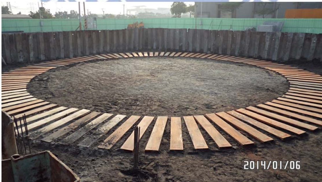
圖 4-14 墊木鋪設示意圖
