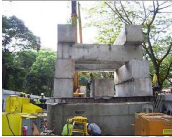
(a) 壓重式沉箱上的加重塊
