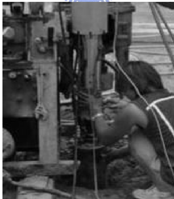
照片 B.4 儀器吊入孔內之照片(廖學志，2004)
