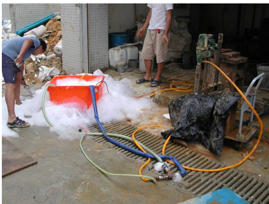
照片 4.8 泡沫鑽心取樣設備照片
