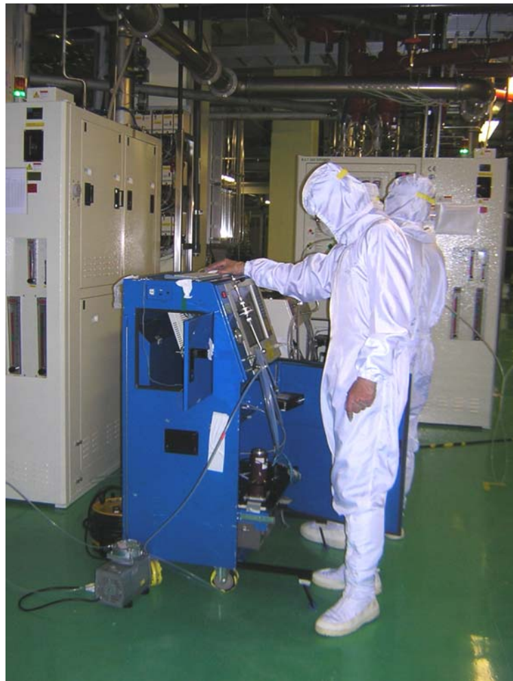
圖 3.13 RGA 進行無塵室現場量測作業
