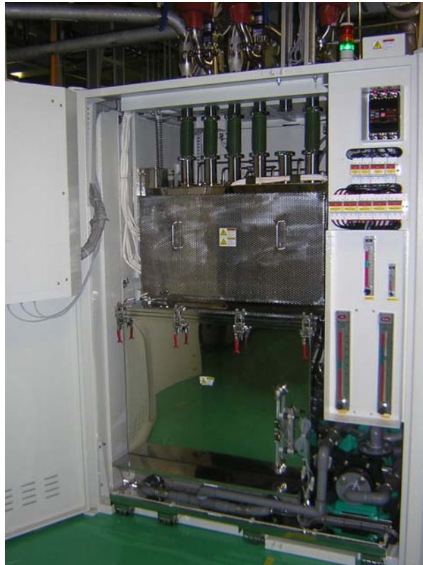
圖3.6 電熱水洗式Local Scrubber內部結構
