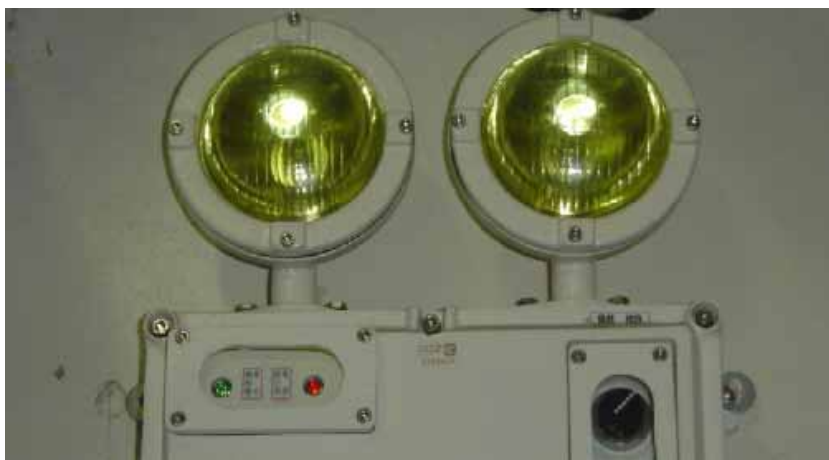
圖 4-6 防爆型緊急照明燈
