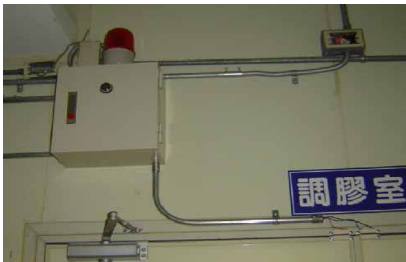
圖 4-18 出入口偵測器
