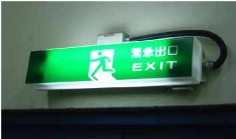
圖 4-5 防爆型出口標示及避難方向指示燈
