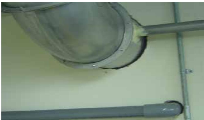
圖 4-32 開孔處之防火填塞
