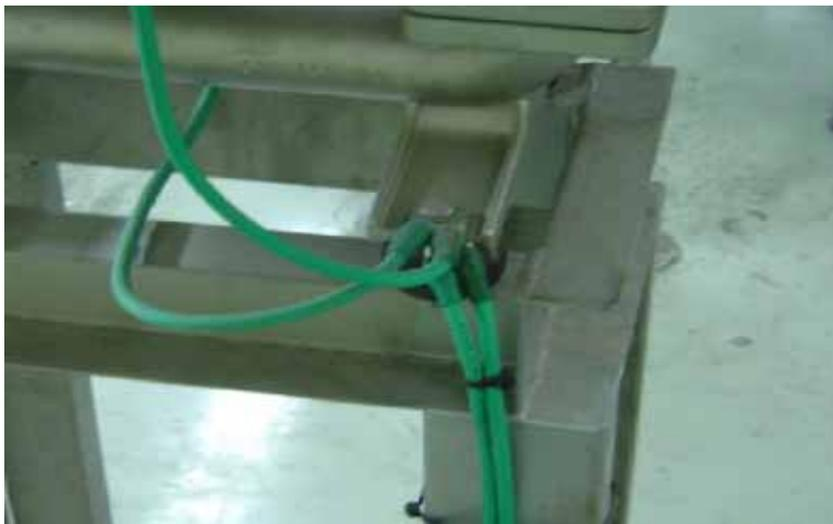
圖 4-21 基座及支撐之接地線
