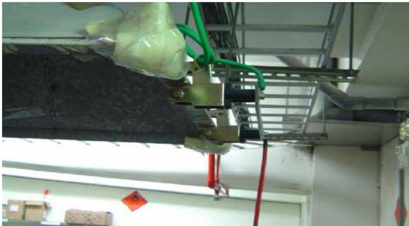
圖 4-22 風罩之接地線
