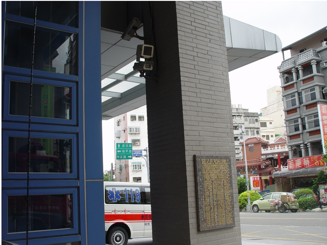
圖 4-2-2 新竹市消防局各分隊固接網路紅外攝影機圖
