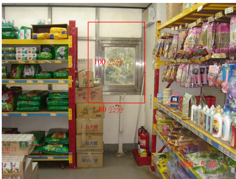
圖 3.2-5 緩降機操作開口面積不足法令規定（紅色框線為標準開口）
