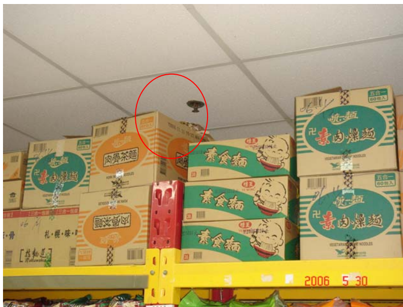
圖 3.2-4 挑高貨物架阻礙撒水設備放射功能（紅色圈選處）
