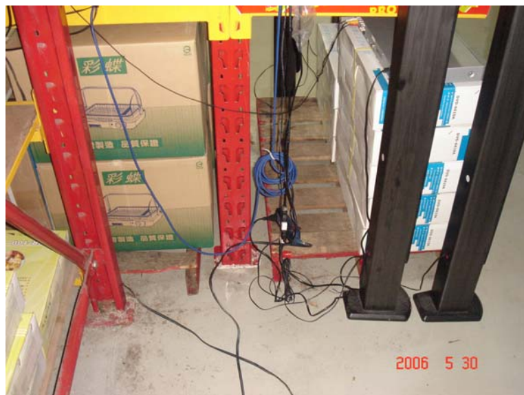
圖 3.2-9 大賣場電器展示區使用延長線情形 資料來源：本研究自行拍攝
