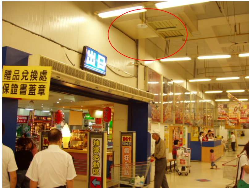
圖 3.2-1 排煙口設置於逃生出口上方影響逃生（紅色圈選處）
