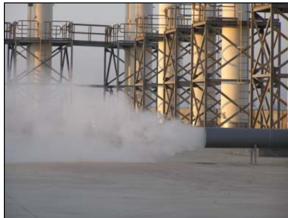
圖 17. 煙囪出口濃白煙(導電度 3 ms/cm)
