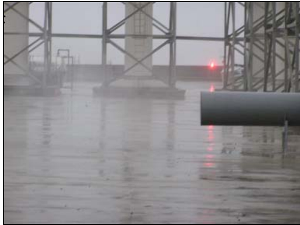
圖 19. 煙囪出口極淡白煙(導電度 70 ms/cm )
