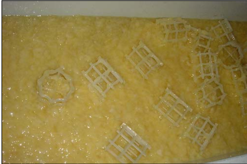
圖 31. 第二道洗滌塔填充材表面污泥累積狀況
