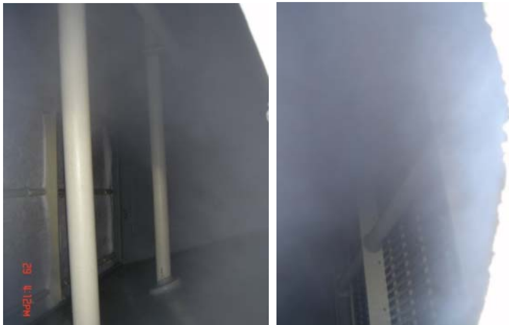
圖 3. 洗滌塔除霧層後白煙產生狀況(運轉中)
