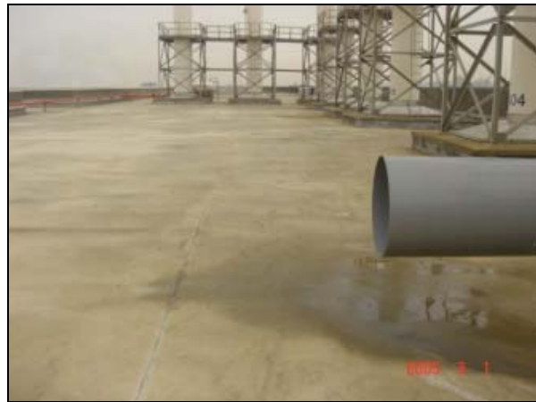
圖 20. 煙囪出口無白煙(導電度 88 ms/cm )
