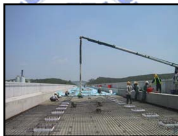
圖 3-81 保護層混凝土澆置
