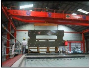
圖 4-35 軌道版吊離養生池
