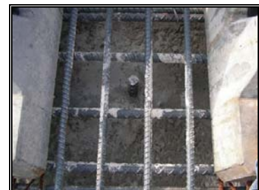
圖 3-119 剪力鋼筋(二)
