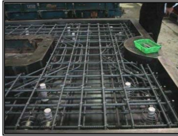
圖 4-16 鋼筋籠與預埋件
