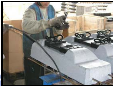
圖 4-60 鋼軌扣件安裝(一)
