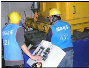
圖 4-46 混凝土澆置與震動控制
