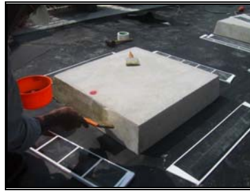
圖 3-112 彈性承載墊片安裝
