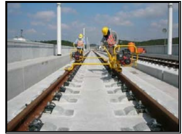
圖 3-141 鋼軌扣件鎖固
