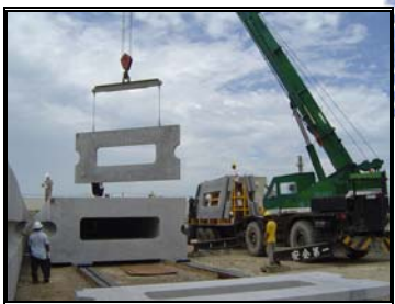
圖 4-38 軌道版吊放儲存
