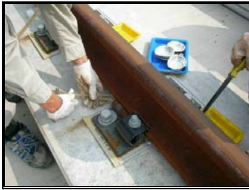
圖 3-70 可調整鋼軌墊片灌注(二)
