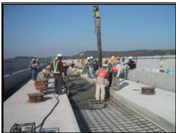
圖 3-18 橋樑段保護層混凝土澆置
