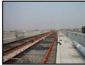
圖 3-10 橋樑段路盤混凝土模板組立
