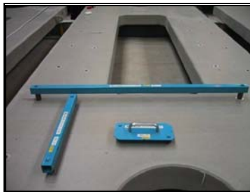
圖 4-27 預埋螺栓孔位置檢查
