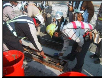
圖 3-7 橡膠支承墊灌漿圖
