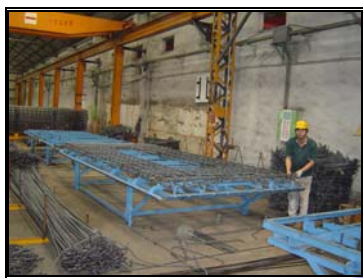
圖 4-10 鋼筋籠組立台
