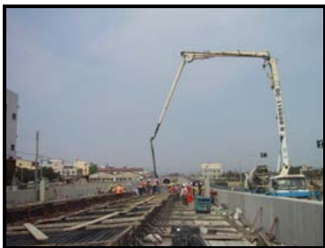
圖 3-15 路工段路盤混凝土澆置
