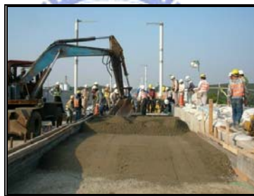
圖 3-90 乾拌混凝土機械刮平
