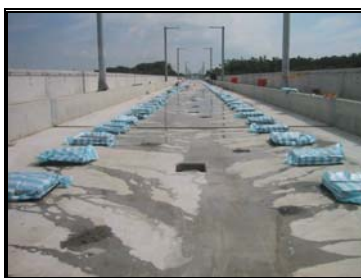
圖 3-86 冠版混凝土養生
