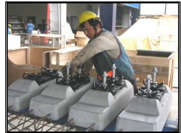
圖 4-61 鋼軌扣件安裝(二)
