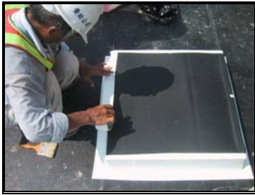
圖 3-114 彈性承載墊片膠帶密封
