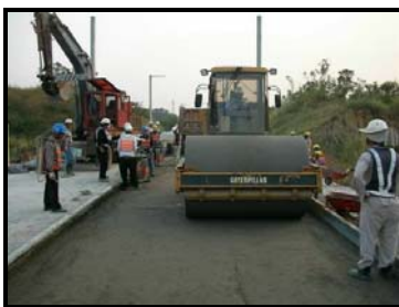
圖 3-92 水力結合層滾壓震動夯實
