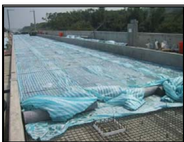
圖 3-83 保護層混凝土養生
