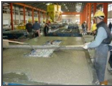
圖 4-22 混凝土完成面處理
