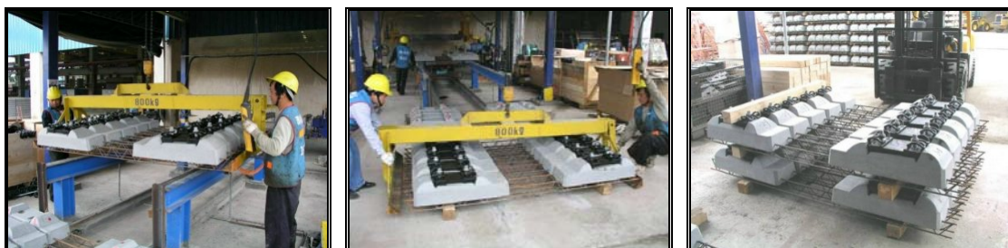
圖 4-67 預鑄軌枕搬運(一) 圖 4-68 預鑄軌枕搬運(二) 圖 4-69 預鑄軌枕搬運(三)
