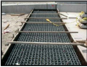
圖 3-98 整平層鋼筋
