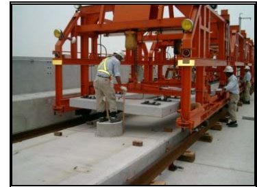
圖 3-46 軌道版安裝車鋪設軌道版
