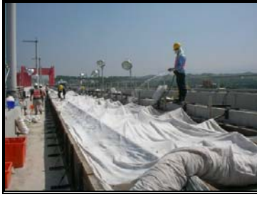
圖 3-136 道版混凝土養生
