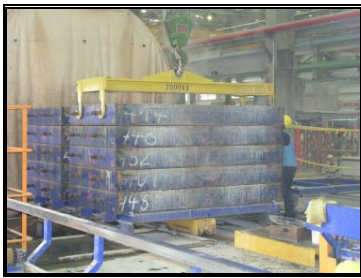
圖 4-48 鋼模吊放至蒸氣養生棚前
