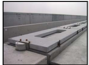
圖 3-49 預鑄軌道版鋪設完成圖
