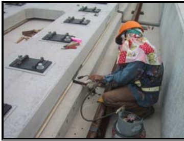
圖 3-54 CA 砂漿注入口封頭
