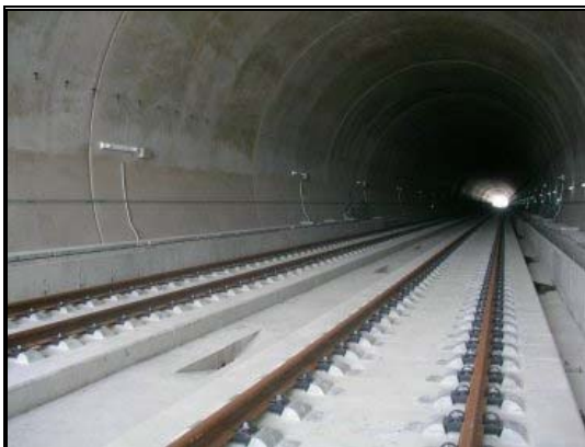
圖 3-143 德國 Rheda 2000 版式軌道隧道段完成圖
