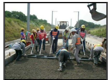
圖 3-91 乾拌混凝土人工刮平
