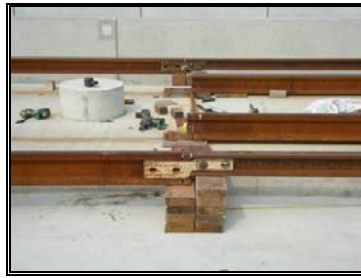
圖 3-42 37kg/m 鋼軌延伸圖
