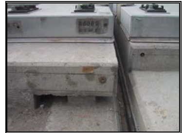
圖 3-26 路工段橡膠支承墊完成圖
