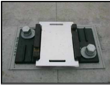
圖 3-61 鋼軌墊片安裝
