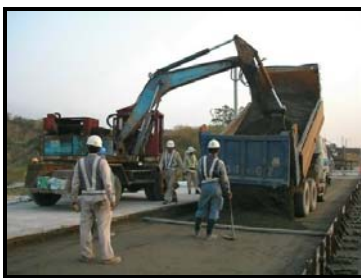
圖 3-89 水力結合層乾拌混凝土卸載
