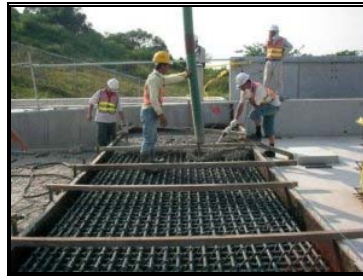
圖 3-99 整平層混凝土澆置
