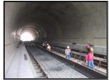
圖 3-11 隧道段路盤混凝土施工
