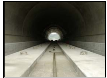
圖 3-29 隧道段下部結構完成圖
