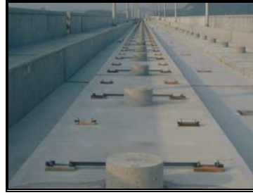
圖 3-32 臨時軌道墊片與軌距固定桿
