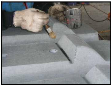
圖 4-54 鋼軌基座處混凝土裂縫檢查
