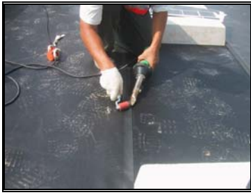
圖 3-111 彈性隔離膜焊接
