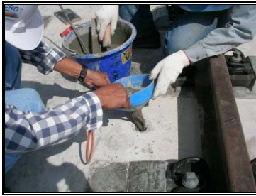
圖 3-139 鋼軌支撐架孔洞灌漿
