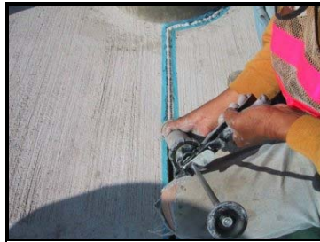
圖 3-25 路盤混凝土伸縮縫填縫圖
