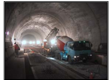
圖 3-14 隧道段路盤混凝土澆置圖
