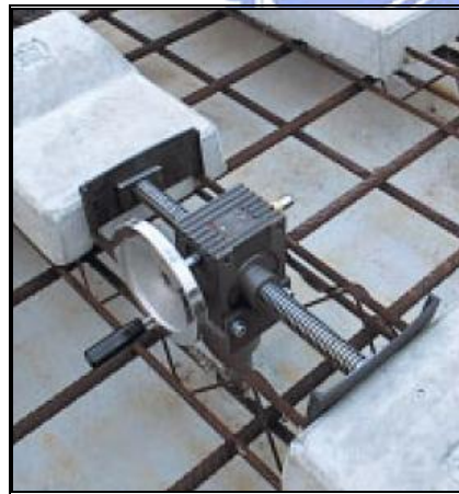
圖 2-13 軌枕水平調整器[20]
