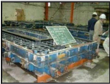
圖 4-18 混凝土澆置前檢查
