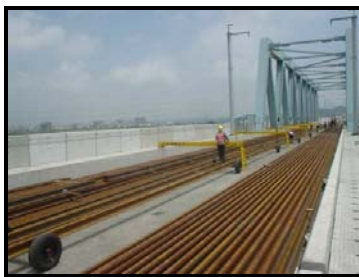
圖 3-107 鋼軌臨時存放場
