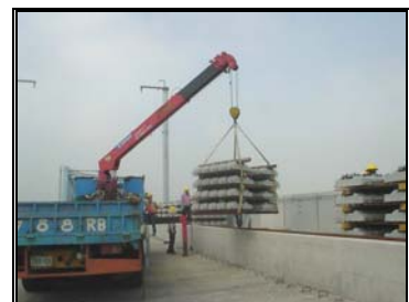
圖 3-105 預鑄軌枕分配至安全走道上
