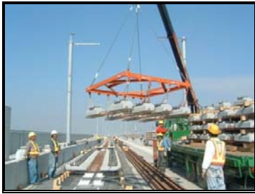
圖 3-124 軌枕鋪設(吊卡車)
