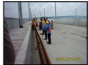
圖 3-109 鋼軌臨時放置於軌道兩側
