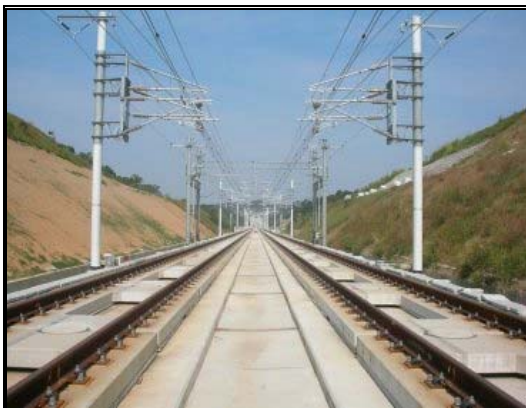
圖 3-73 日本 AF-55 版式軌道路工段完成圖
