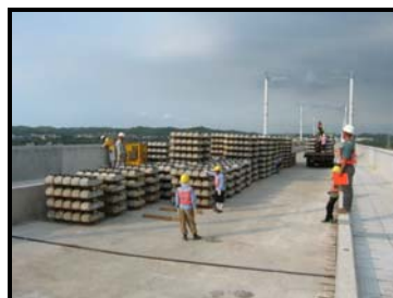
圖 3-104 預鑄軌枕臨時存放橋面版
