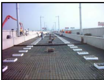
圖 3-80 保護層與冠板鋼筋
