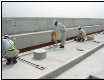
圖 3-37 臨時鋼軌鋪設(三)
