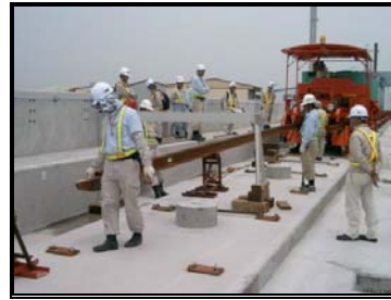
圖 3-35 臨時鋼軌鋪設(一)
