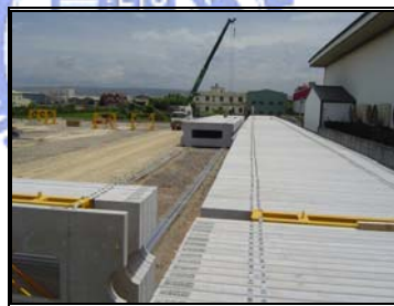
圖 4-39 軌道板儲存場
