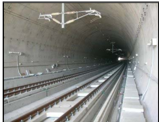
圖 3-74 日本 AF-55 版式軌道隧道段完成圖
