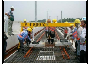
圖 3-123 軌枕鋪設(門型架)
