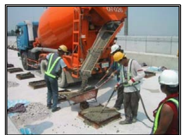
圖 3-85 冠版混凝土澆置
