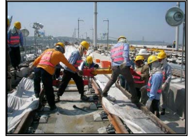
圖 3-138 鋼軌支撐架移除
