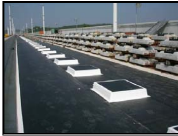
圖 3-115 彈性隔離膜與成載墊片完成圖
