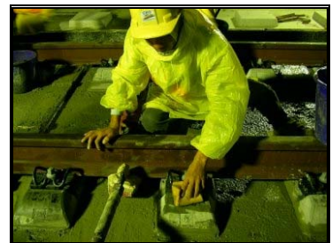
圖 3-135 道版混凝土澆置後清理
