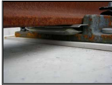
圖 3-71 可調整鋼軌墊片完成圖
