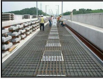
圖 3-121 橋樑段道版底部鋼筋組立
