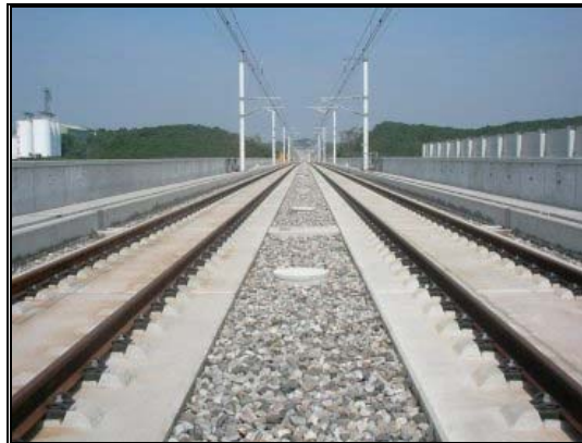
圖 3-142 德國 Rheda 2000 版式軌道橋樑段完成圖
