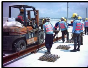
圖 3-108 鋼軌以堆高機運輸
