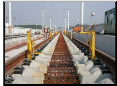
圖 3-126 鋼軌抬升起重機
