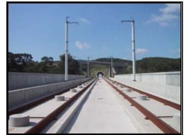
圖 3-39 臨時軌道鋪設完成圖
