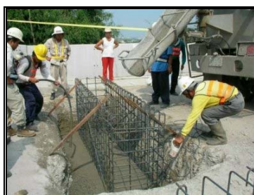
圖 3-96 地樑混凝土澆置
