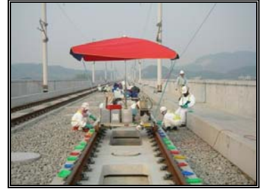
圖 3-69 可調整鋼軌墊片灌注(一)
