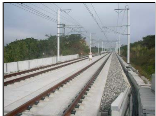
圖 3-144 德國 Rheda 2000 版式軌道路工段完成圖
