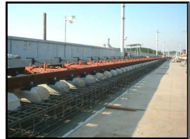
圖 3-129 道版上部鋼筋組立
