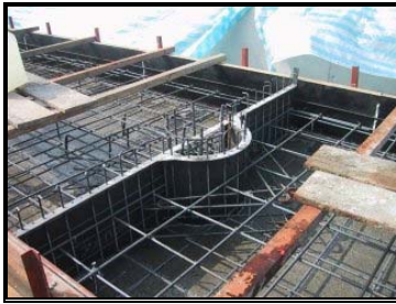
圖 3-9 橋樑段路盤鋼筋組立圖
