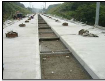
圖 3-22 路工段保護層鋼筋與模板
