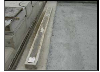
圖 3-8 橡膠支承墊完成圖
