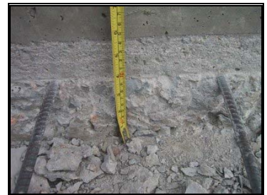
圖 3-17 保護層與路盤混凝土界面
