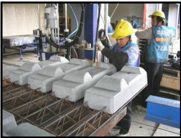
圖 4-59 扣件螺栓孔注入防銹油
