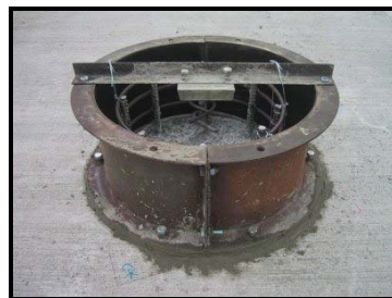
圖 3-19 防動塊混凝土鋼模
