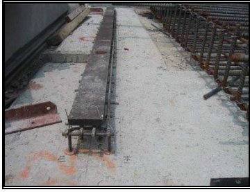
圖 3-6 橡膠支承墊組立圖
