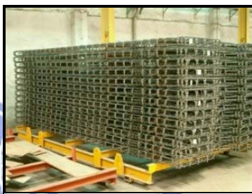
圖 4-11 軌道板鋼筋籠存放
