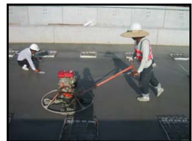
圖 3-82 保護層混凝土面機械鏟平
