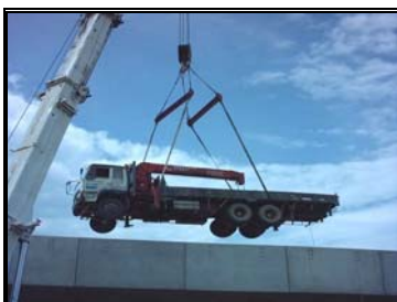
圖 3-103 吊卡車吊至橋面版
