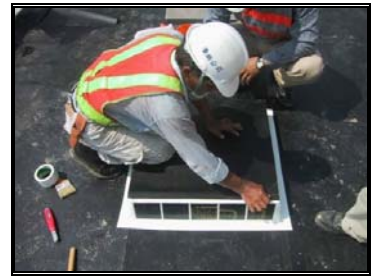
圖 3-113 彈性隔離膜冠版頂部安裝
