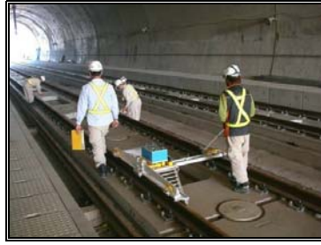
圖 3-68 軌道檢測(Track Master)
