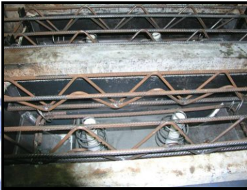
圖 4-43 桁架安裝
