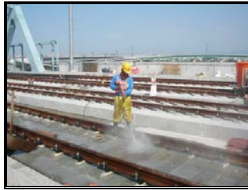
圖 3-140 高壓水柱清理道版相關構件
