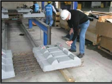
圖 4-56 不合格軌枕噴漆標示
