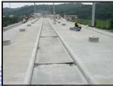
圖 3-28 路工段下部結構完成圖
