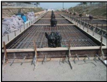
圖 3-12 路工段路盤混凝土施工圖
