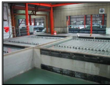
圖 4-34 軌道版浸水養生(二)
