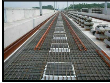
圖 3-122 軌枕臨時支撐架
