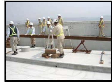
圖 3-36 臨時鋼軌鋪設(二)
