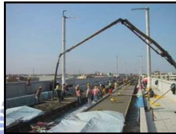
圖 3-13 橋樑段路盤混凝土澆置圖
