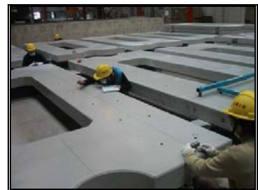
圖 4-28 軌道版平整度檢查
