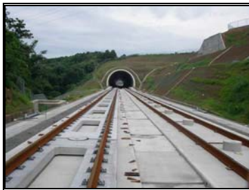
圖 3-65 鋼軌安裝完成圖
