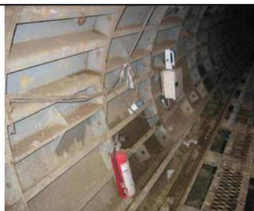
圖 149 隧道設滅火器
