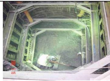
圖 134 支撐需先檢算合格後施工
