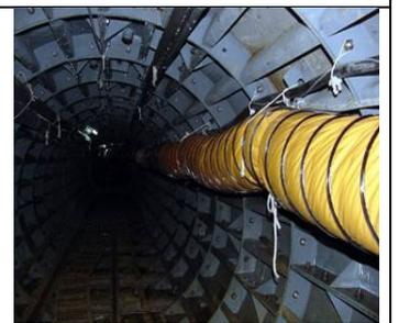
圖 156 通風設備設置
