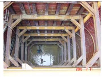
圖 135 鋼襯版需逐層施工並備妥深井抽水機
