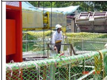
圖 133 施工人員配帶安全帶施工
