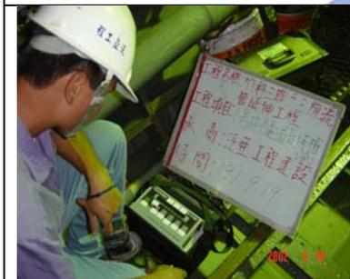
圖 160 隧道內有害氣體偵測
