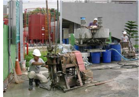
圖 11 地層穩定處理措施相片
