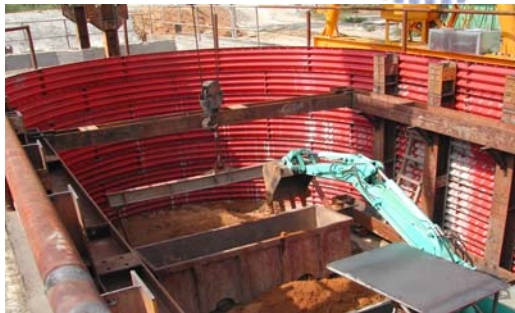
圖 10 工作井擋土開挖及支撐相片
