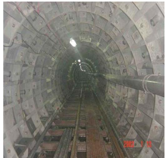
圖 100 92.01.13 一號潛盾機鋼環片襯砌完成
