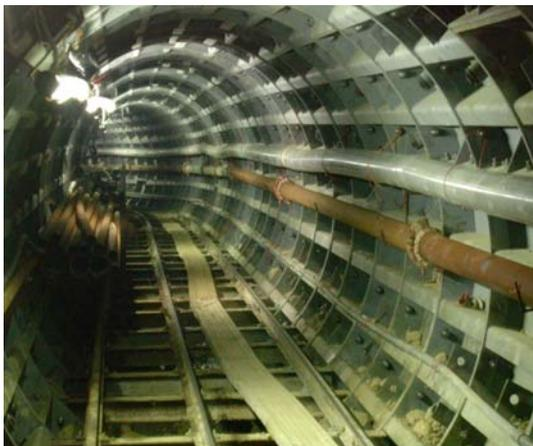
圖 75 隧道內轉彎處一次襯完成相片
