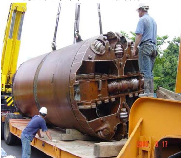
圖 99 92.08.17 三號潛盾機完成掘進出坑及吊出二號工作井之作業
