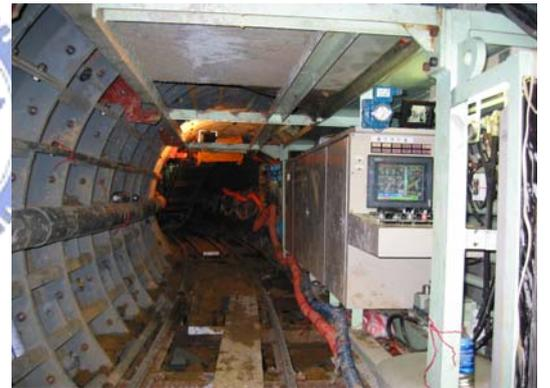
圖 74 隧道內潛盾機操作台相片
