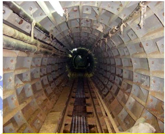
圖 119 已施工完成之鋼環片襯砌相片
