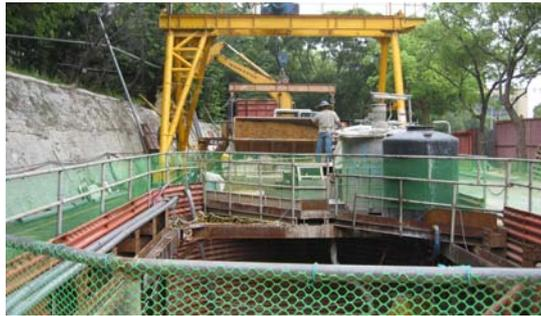
圖 71 工作井上方吊棄土施工
