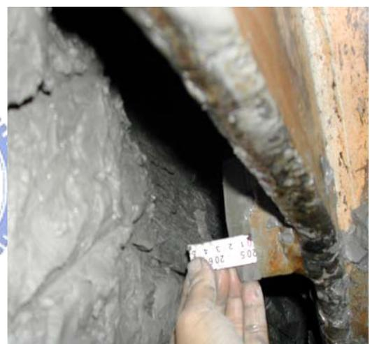
圖 98 92.06.29 三號潛盾機檢查切削刀刃
