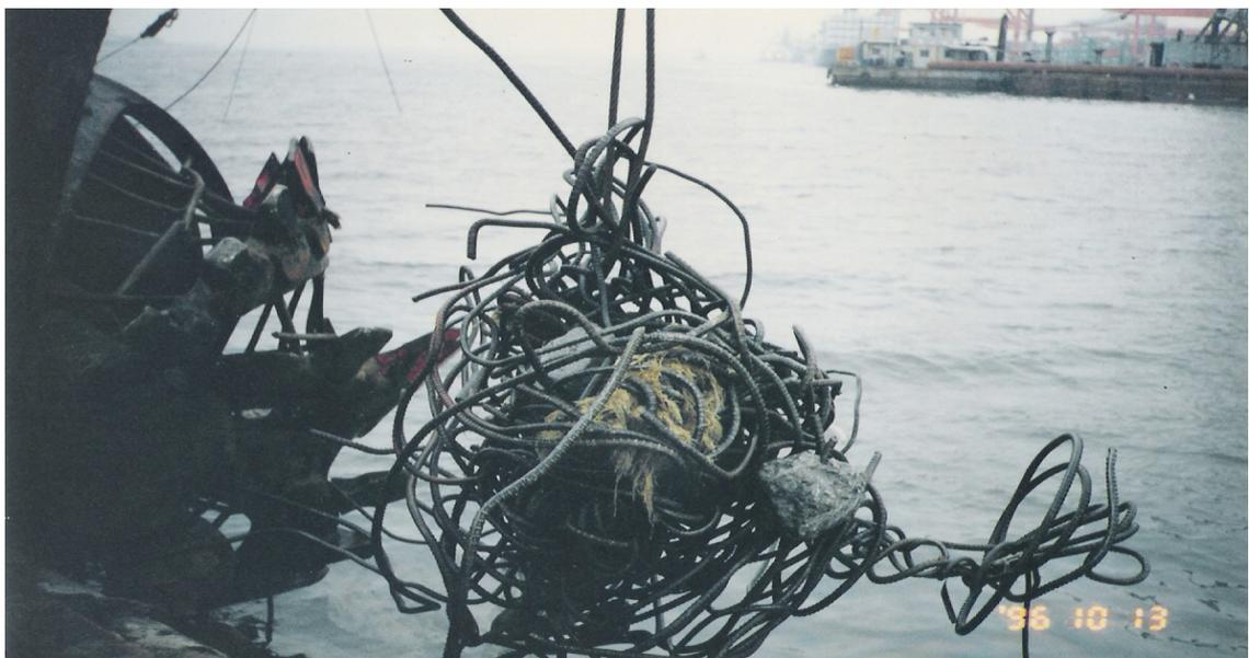
圖 5-10 挖泥作業時挖到廢鋼筋水泥塊實體圖
