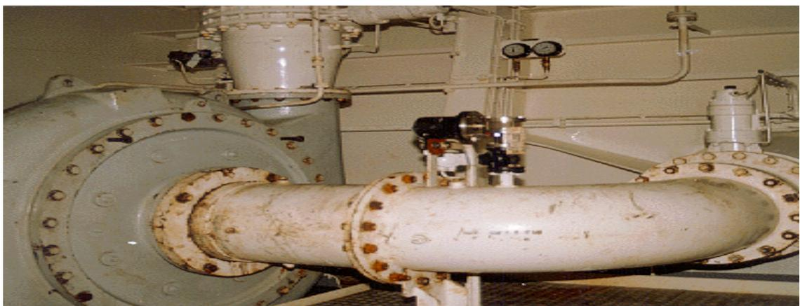
圖 3-33 水上加壓站內之泵浦、管路實體圖
