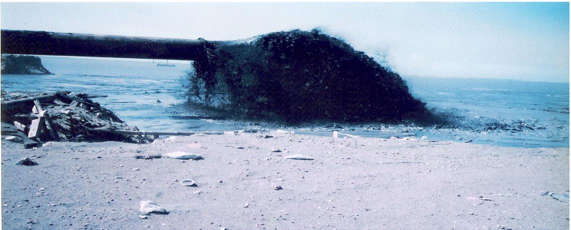
圖 3-6 挖泥船將水底下砂石排放至填區造地情形
