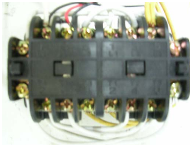
圖 4-8 電磁開關關閉，馬達不運作
