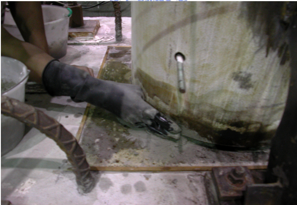
照片 3.12 修補節塊底部混凝土
