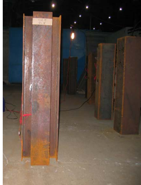
(b) 鋼骨組立完成
