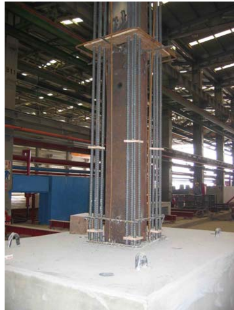
(b) 柱基礎混凝土灌漿完成
