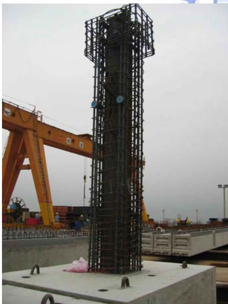
(c) 柱身箍筋與主筋綁紮完成
