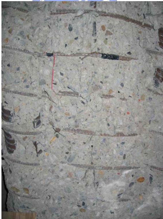
(b) 箍筋輕微彎曲
