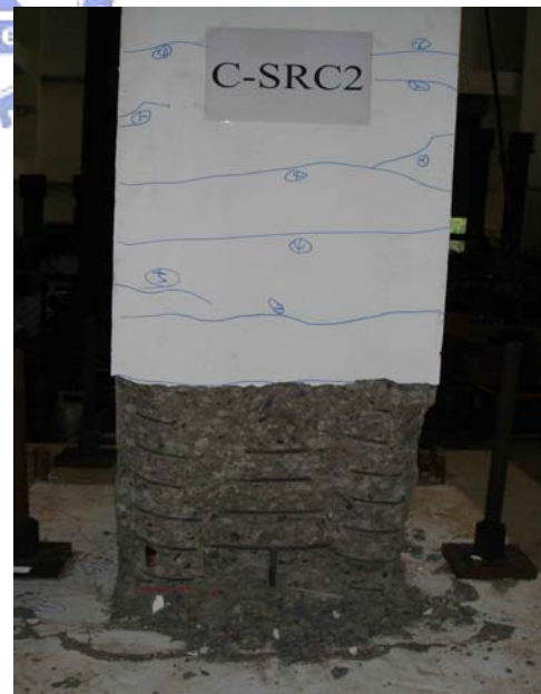
(b) 在五螺箍圍束區域內之混凝土、主筋與箍筋仍然保持良好狀態
