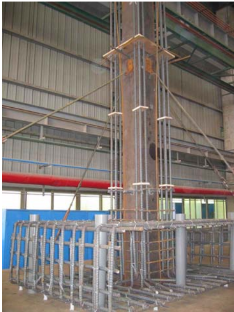
(a) 鋼骨、主筋與柱基礎主筋 組立完成
