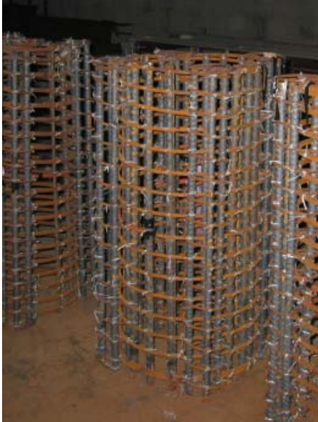
(a) 箍筋及主筋組立完成
