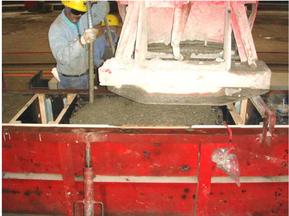
照片 3.2 SRC 柱試體灌漿並搗實
