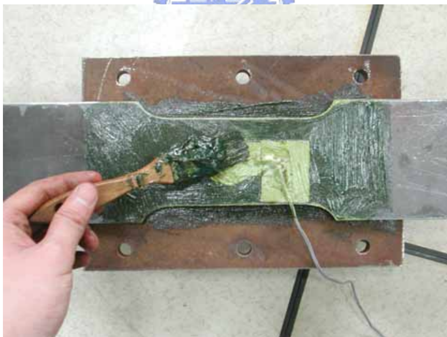
照片 3.32 塗油於消能鋼板及蓋板
