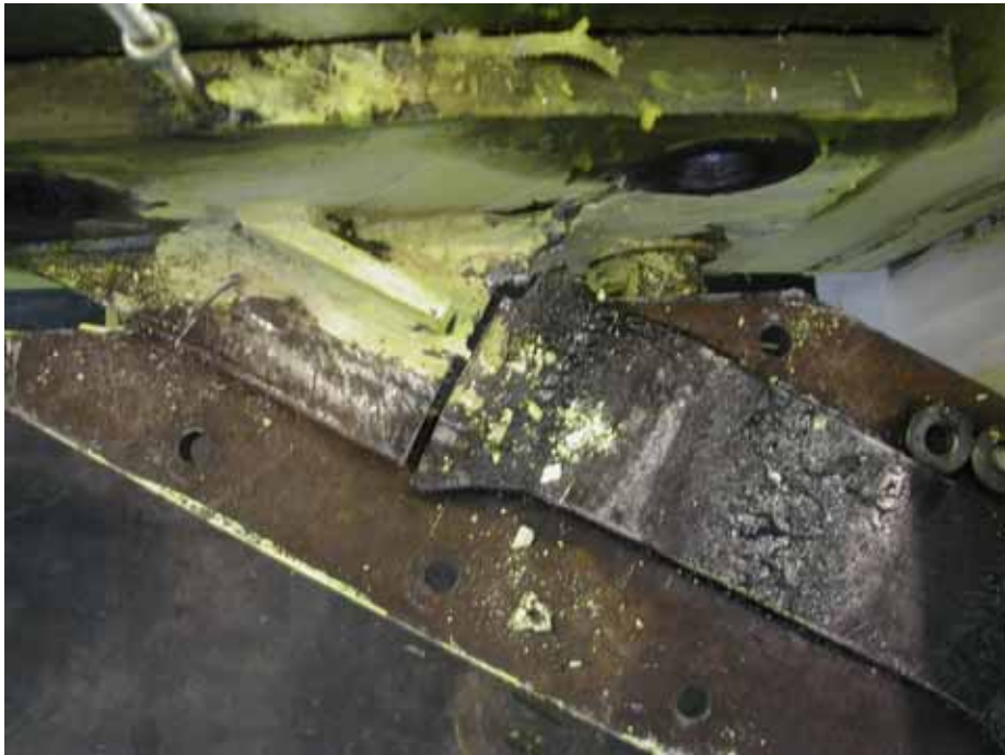
照片 3.13 試體 2 消能鋼板拉伸斷裂
