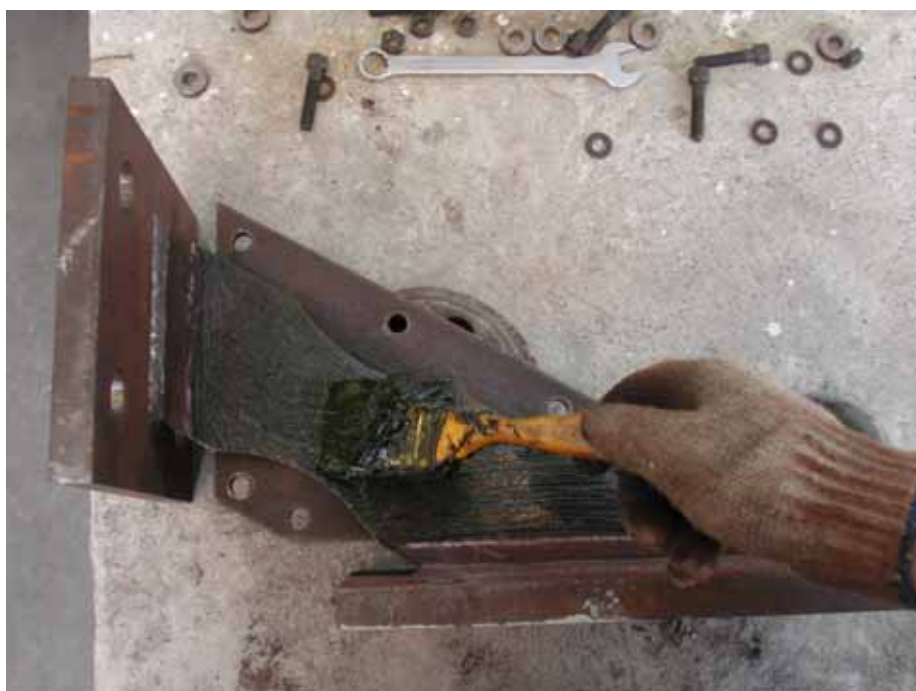
照片 3.3 試體 1 挫屈束制鋼板消能器組裝
