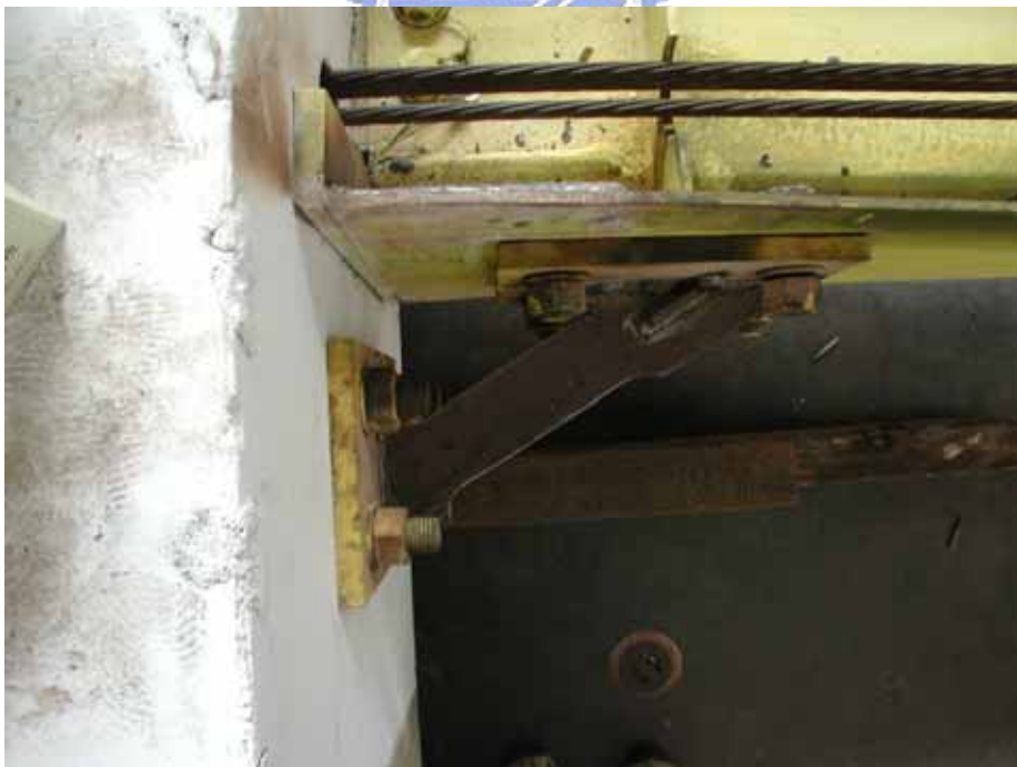
照片 3.10 試體 2 消能鋼板點焊於底板
