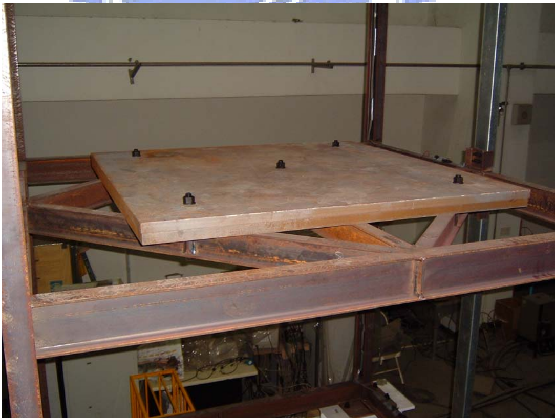
圖4-6 樓板俯視照片
