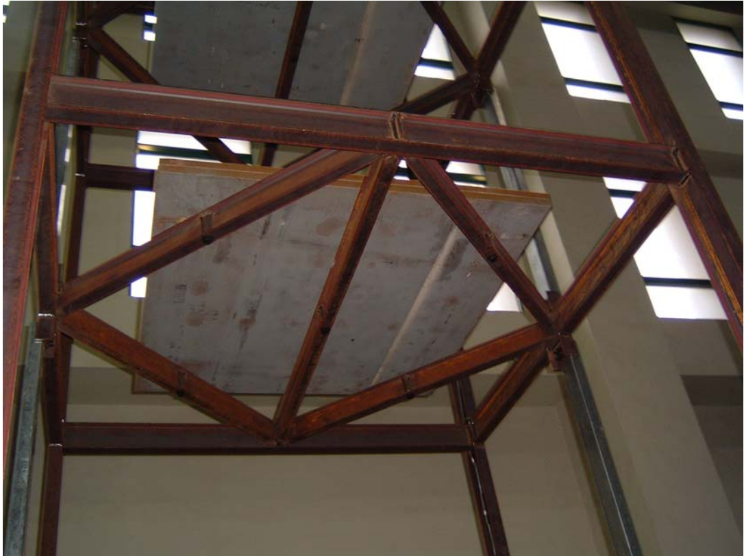
圖4-7 樓板仰視照片
