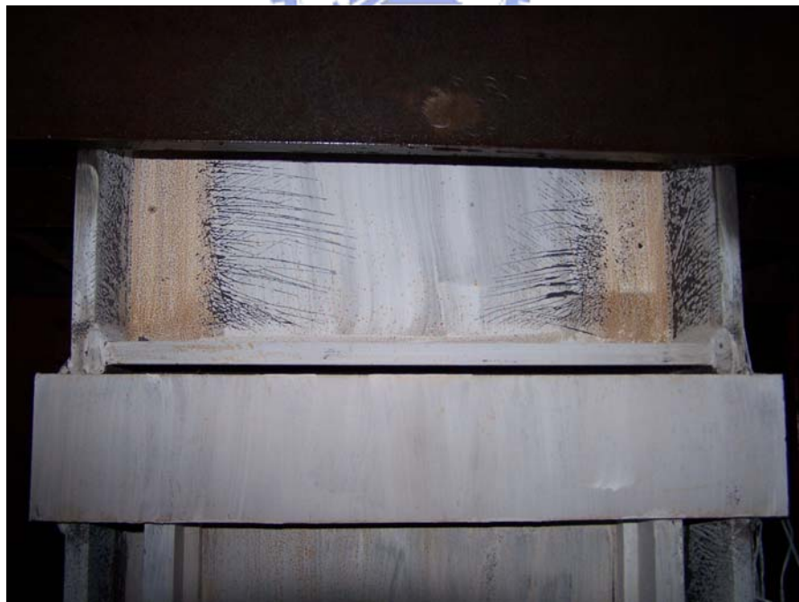
照片 5.5 試體一 CM600 支撐段外側梁腹板石灰剝落從兩側向中心延伸(3% drift)
