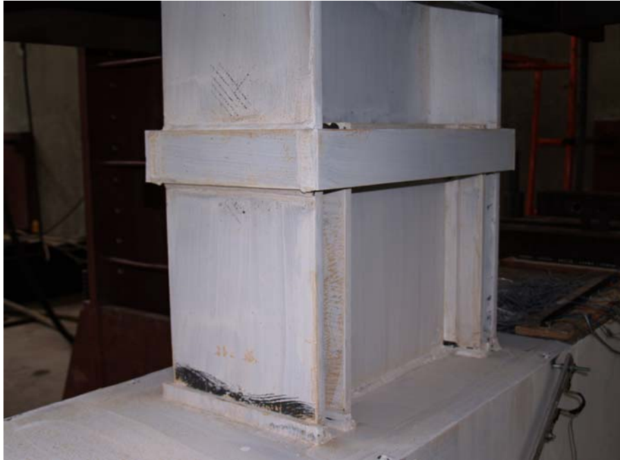
照片 5.16 試體三 CM400 支撐段外側翼板石灰有較明顯剝落的現象，而支撐處內側石灰少許剝落(1% drift)
