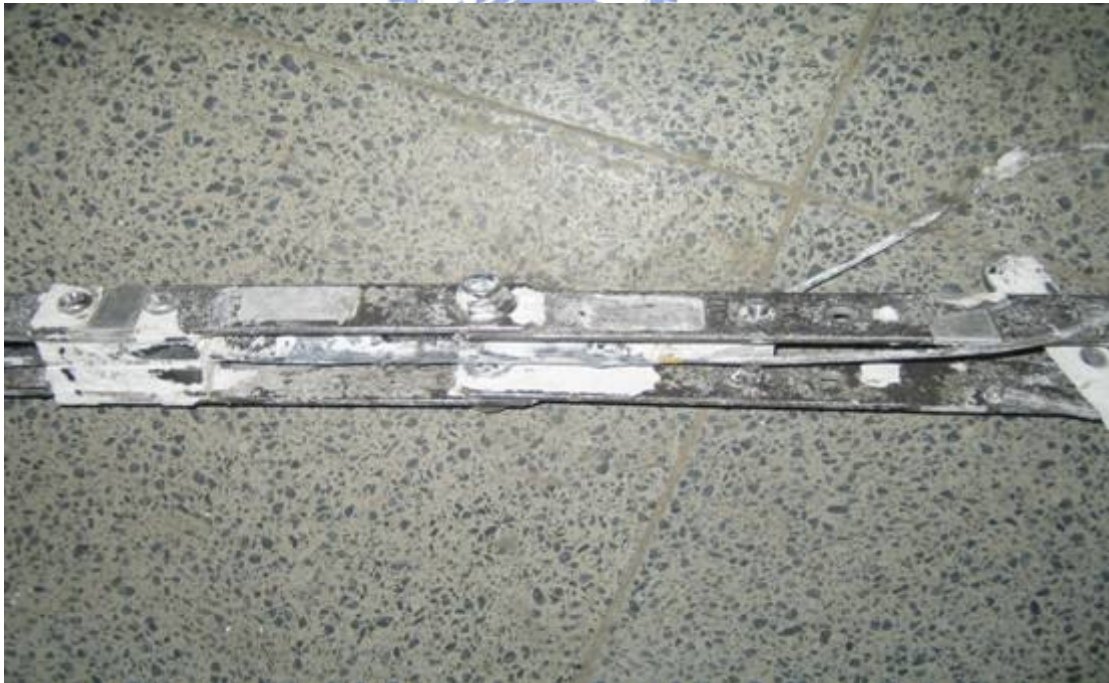
圖 3-6 感測器於監測完成取出之腐蝕情形
