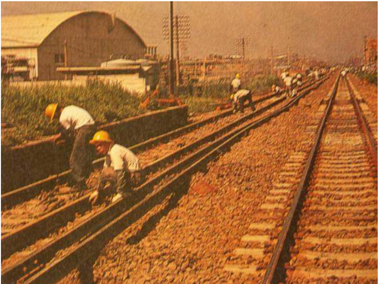
圖 4-1 抽換鋼軌作業圖
