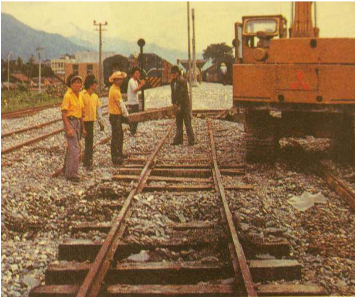
圖 4-7 抽換木枕作業圖
