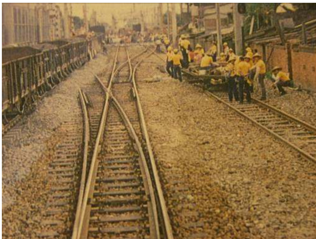
圖 4-3 抽換道碴作業圖
