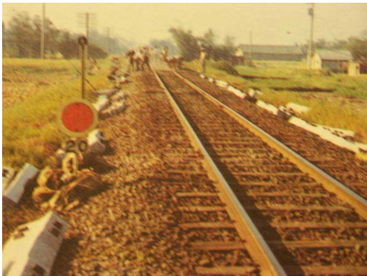
圖 4-5 抽換 PC 枕作業圖
