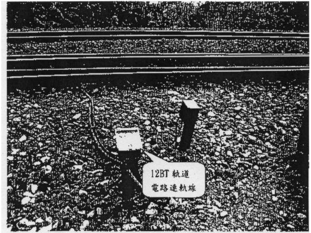
圖 5-5 施工人員施作地點（崇德站南側 12BT 之軌道電路 14A 道岔連軌線） （資料來源北區檢查所）
