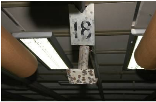
圖 3.9、掛靶架損壞情形
