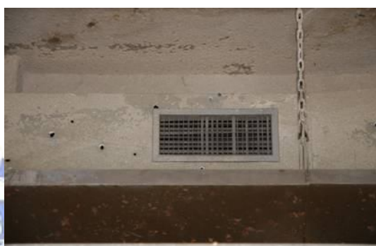
圖 3.6、抽風系統遭子彈射擊
