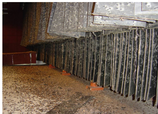
圖 2.22、百葉式布幕捕彈陷阱
