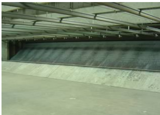
圖 2.21、高張力鋼板捕彈陷阱
