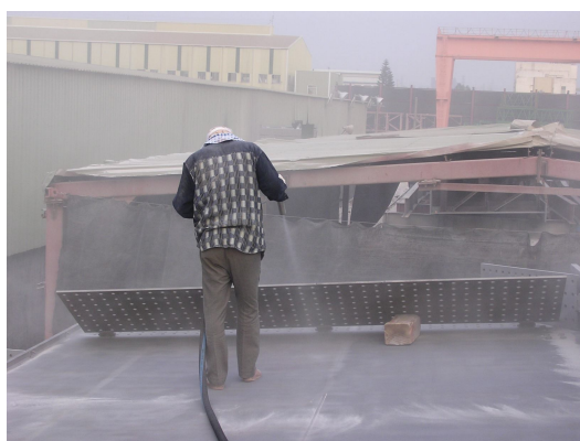
圖 5-13 人員於箱型樑上從事噴砂作業
