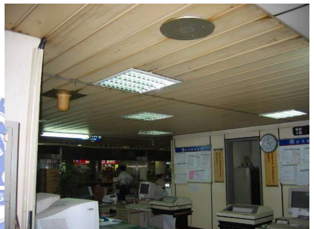
G+1臺鐵售票非公共區未設撒水頭防護
