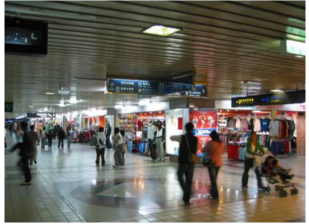
U-1穿堂層公共空間未設置撒水頭防護
