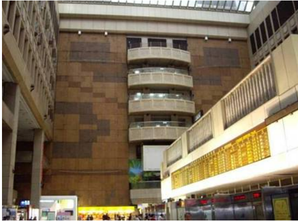
樓地板 > 1500m 2 無法設置平面防火區劃
