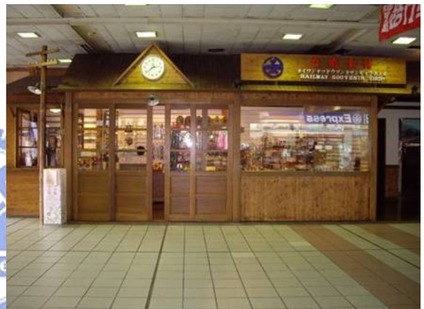
室內裝修未使用防火建材、不燃耐燃材料
