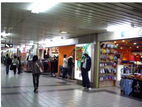
商店使用未依面積及用途設置防火區劃
