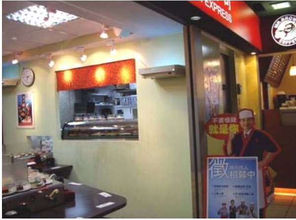
G+1餐廳廚房未設防火區劃
