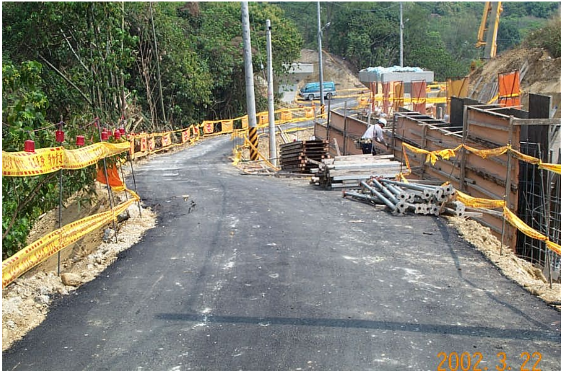
圖 2-10 營建工程工區周邊道路瀝青鋪面鋪設實照
