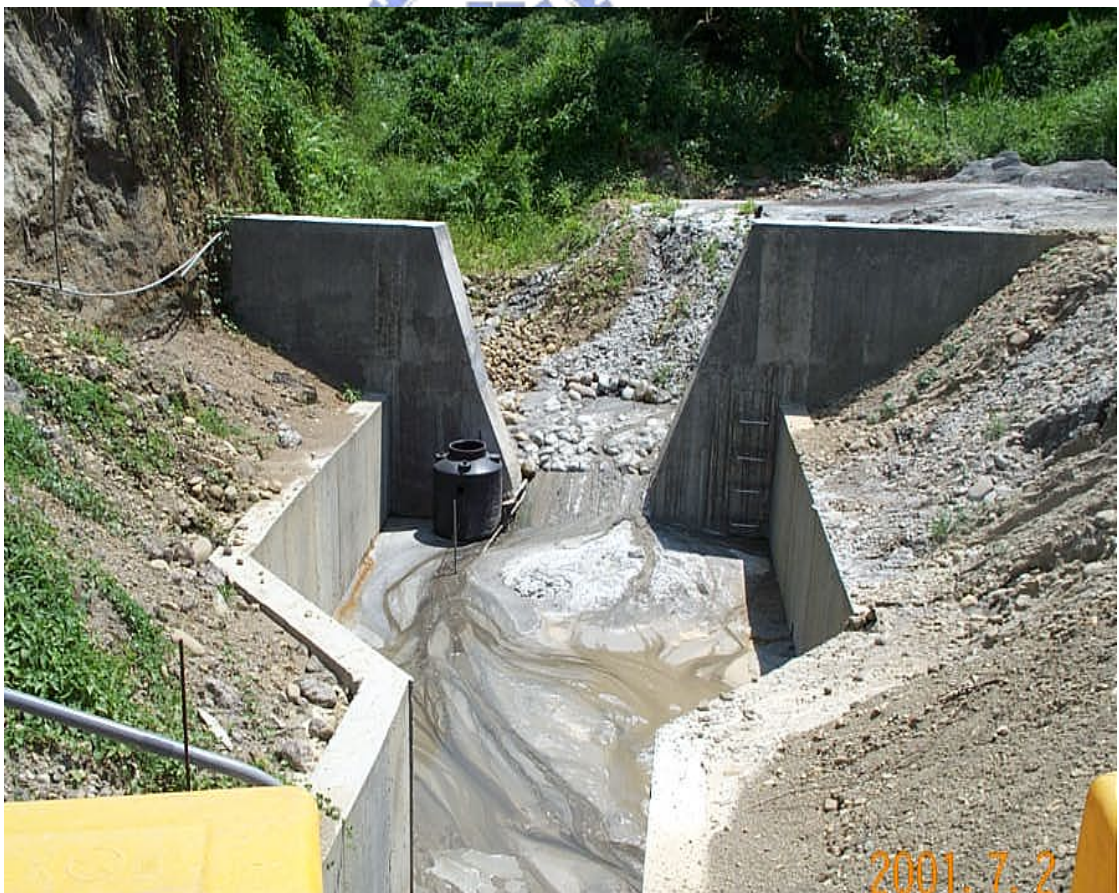
圖 2-9 營建工程工區內設置大排水溝與沈砂池實照
