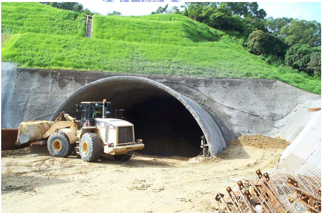
圖 2-13 營建工程隧道洞口施工前階段植被與噴漿防護實照
