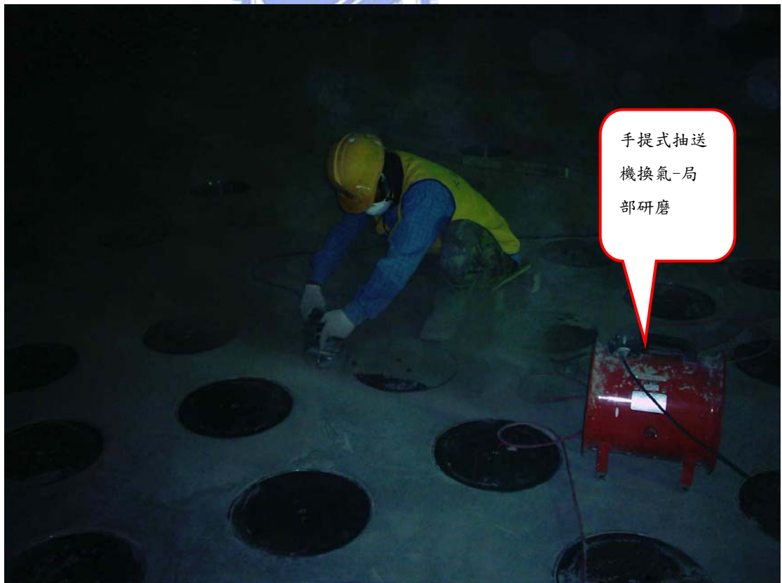
圖 1-5 研磨作業時使用手提抽送風機通風的情形(地面樓層封閉區)
