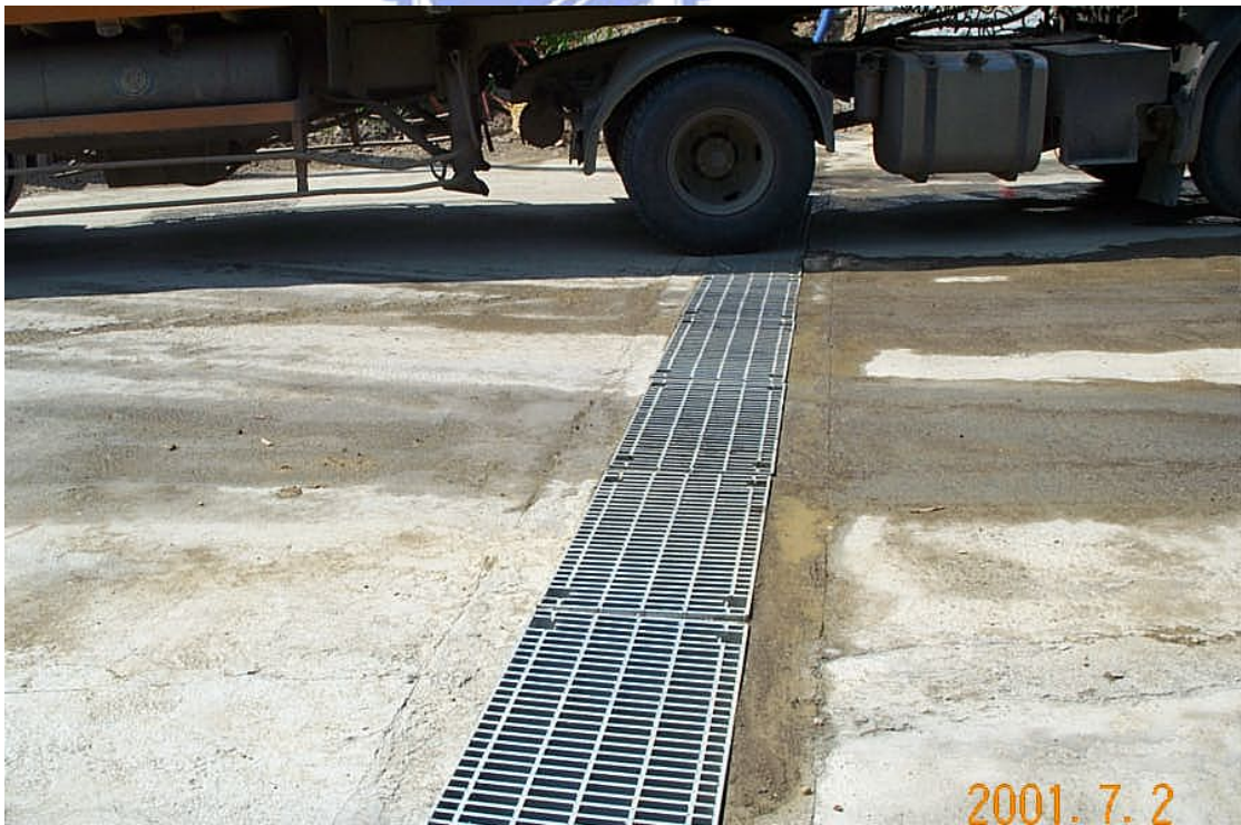
圖 2-5 營建工程工區內道路設置截水溝實照
