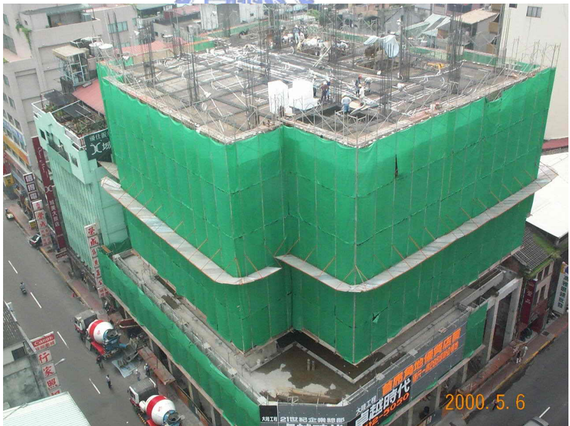
圖 2-1 建築物外圍包覆防塵網實照
