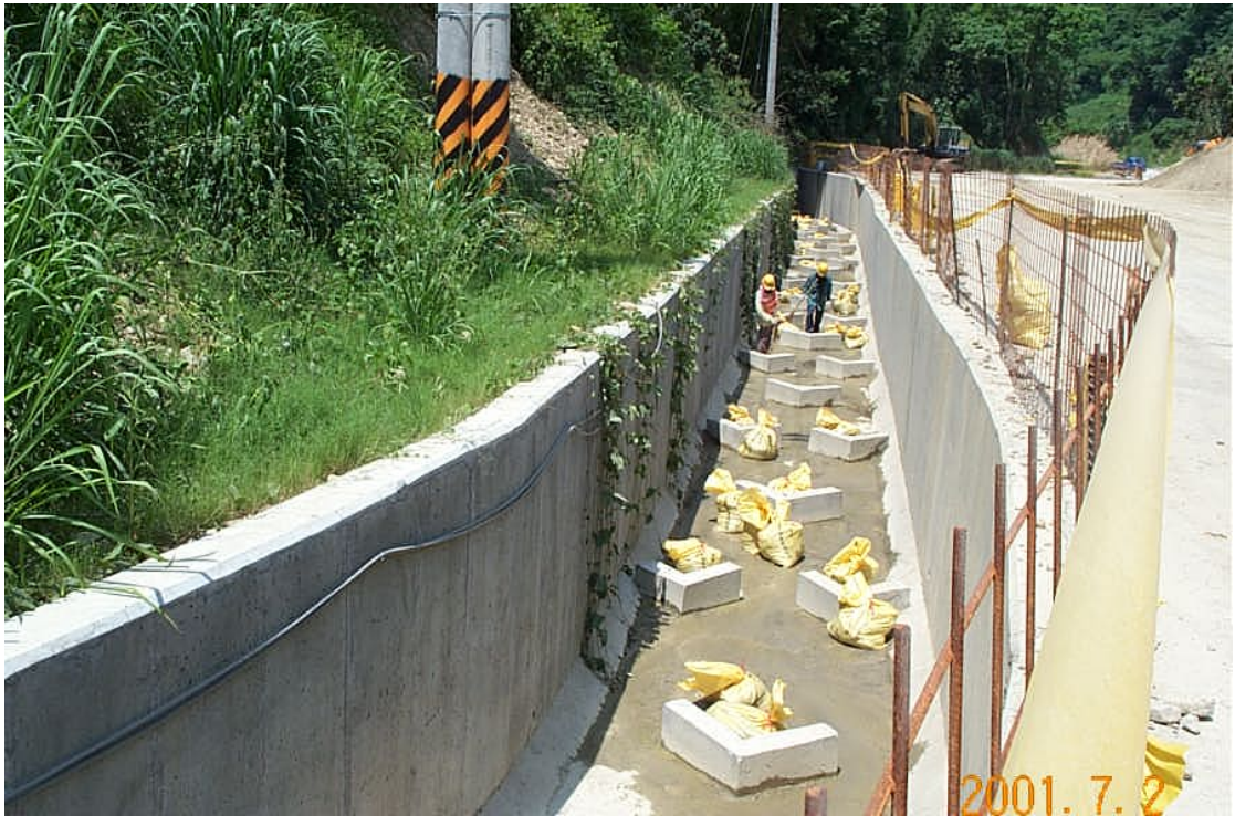
圖 2-6 營建工程工區內外排水溝設置攔砂墩實照
