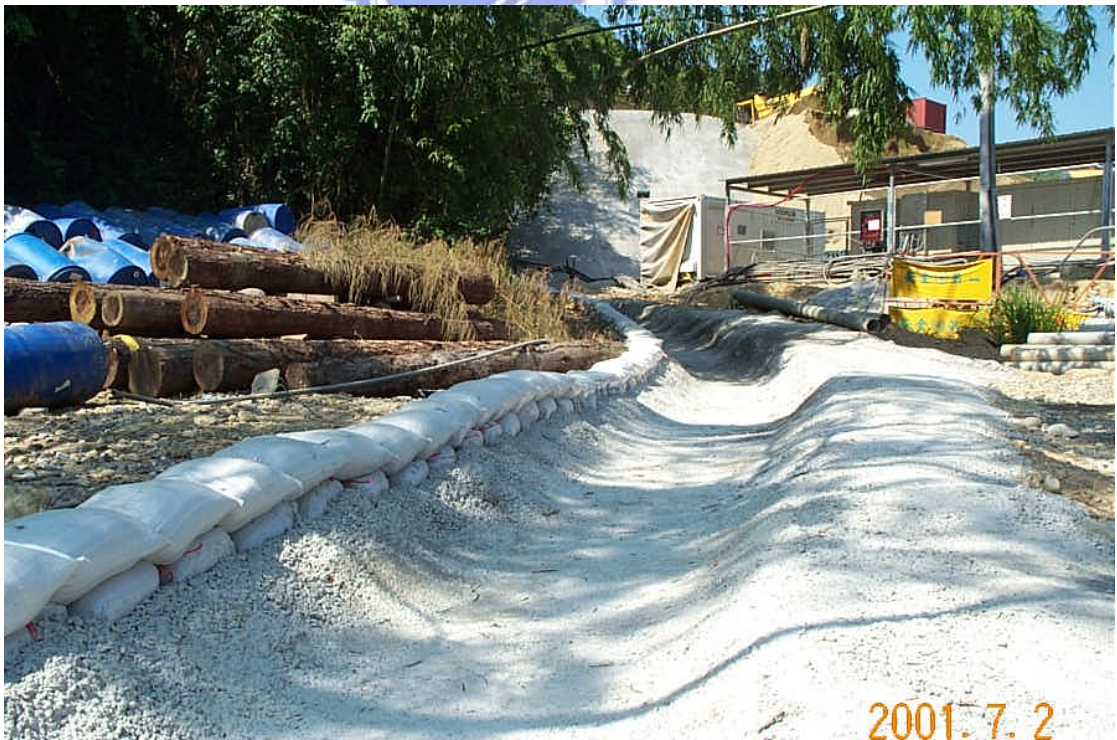
圖 2-7 營建工程工區內設置小排水溝實照
