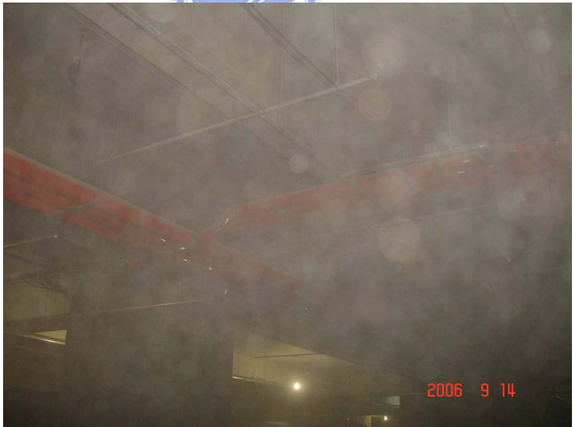
圖 3-7 研磨作業粉塵逸散污染設備管線(地下室)-作業中
