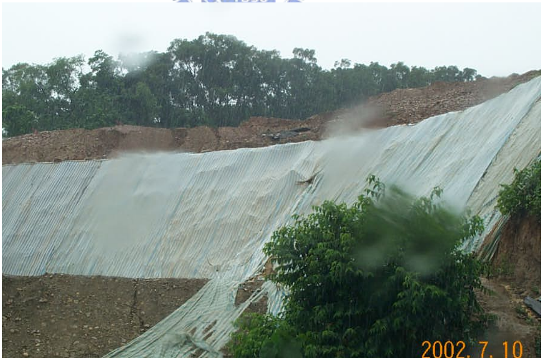
圖 2-11 營建工程工區周邊邊坡覆蓋帆布實照
