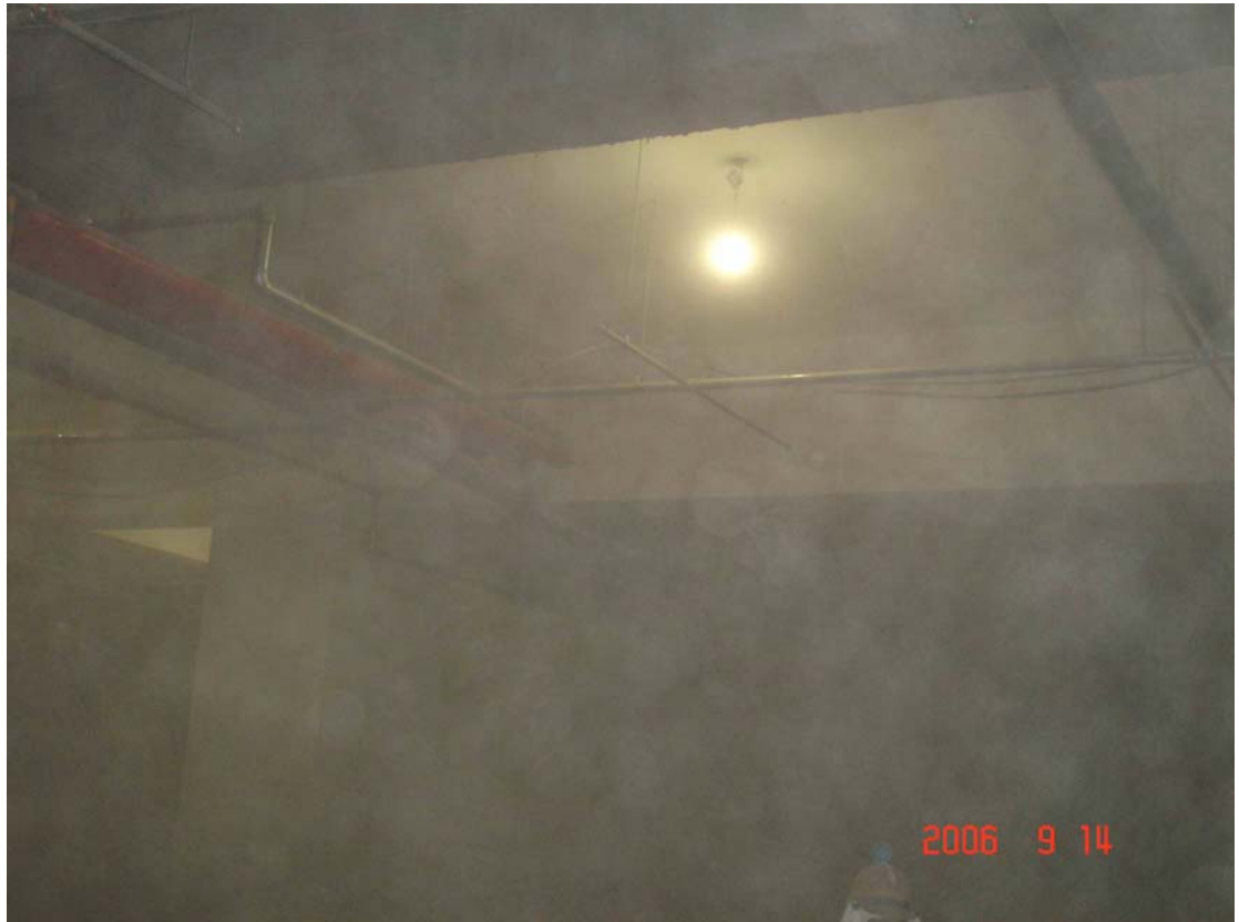
圖 3-6 研磨作業粉塵逸散污染設備管線(地下室)-作業中
