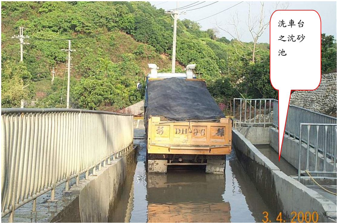
圖 2-2 營建工程設置洗車台與沈砂池實照
