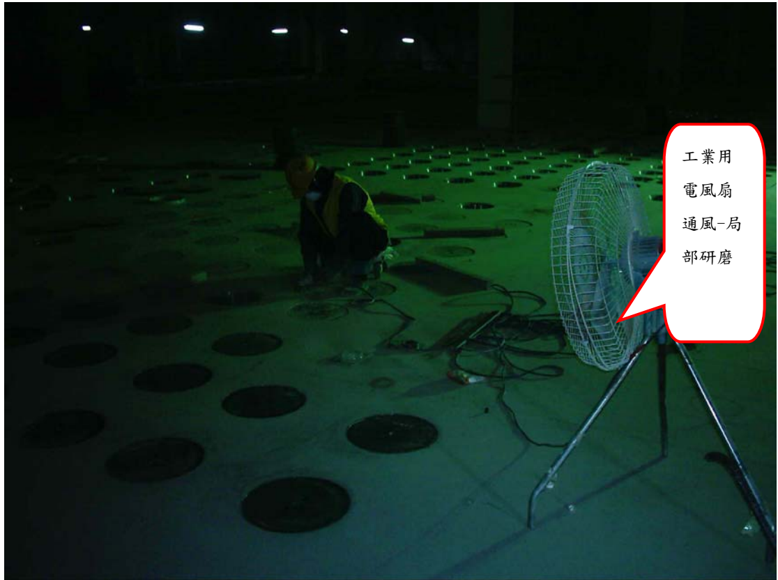
圖 1-4 研磨作業時使用工業用電風扇通風的情形(地面樓層封閉區)
