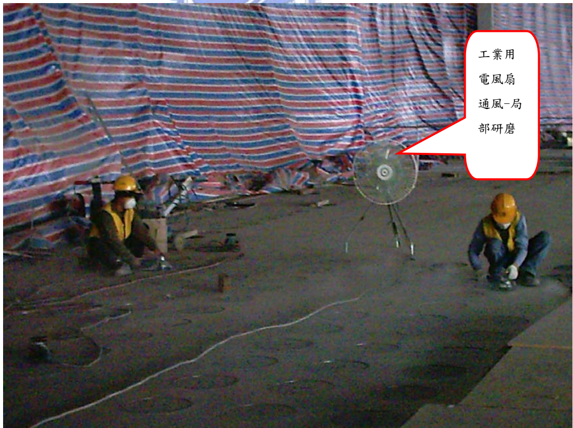
圖 1-3 研磨作業時使用工業用電風扇通風的情形(地面樓層開放區)
