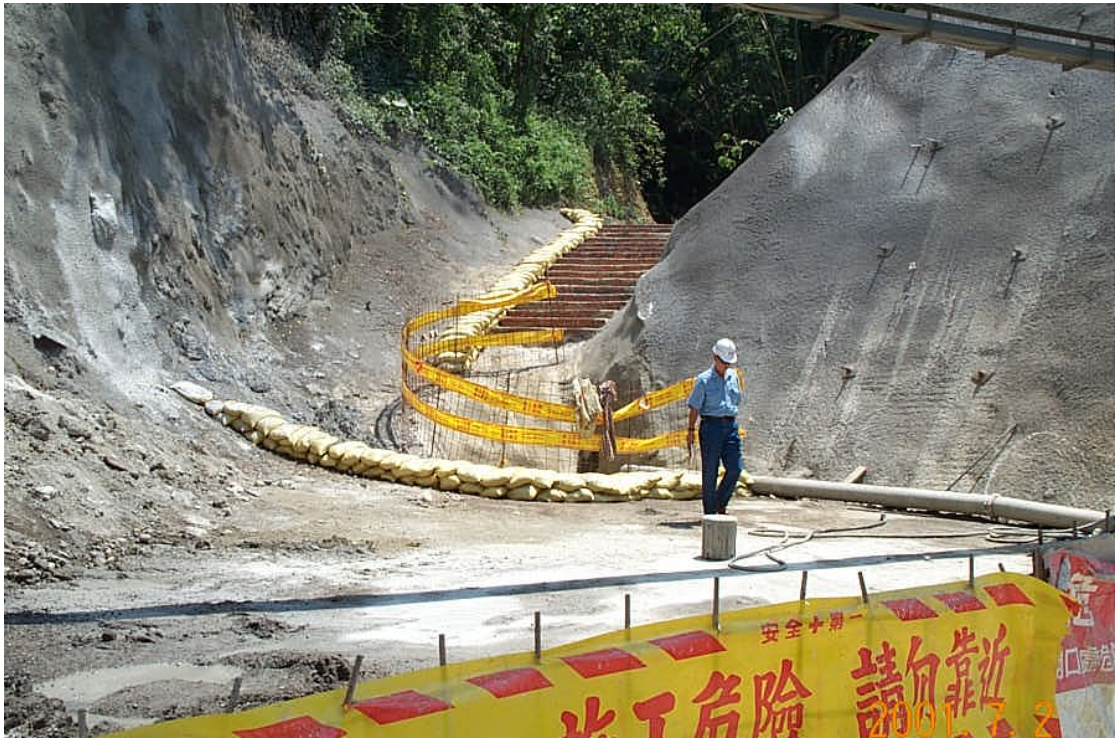
圖 2-8 營建工程工區內設置大排水溝實照
