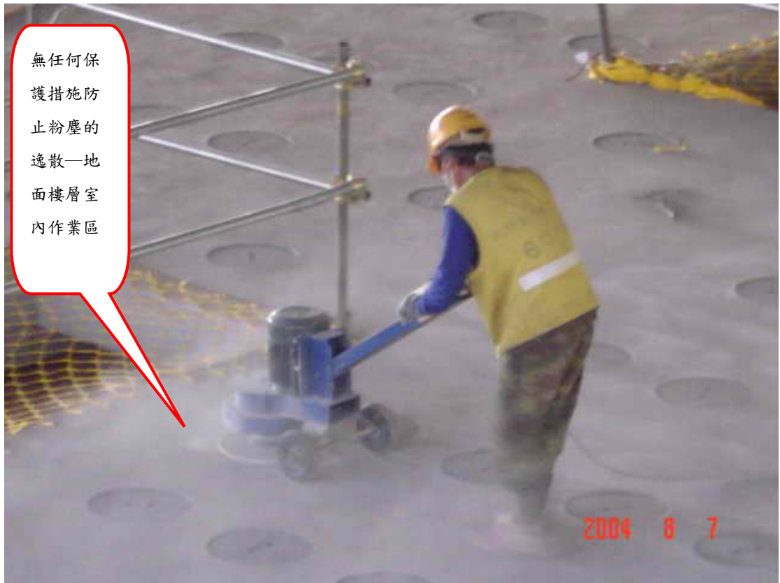
圖 1-2 研磨作業時粉塵逸散情形(地面樓層作業區)—無防護措施
