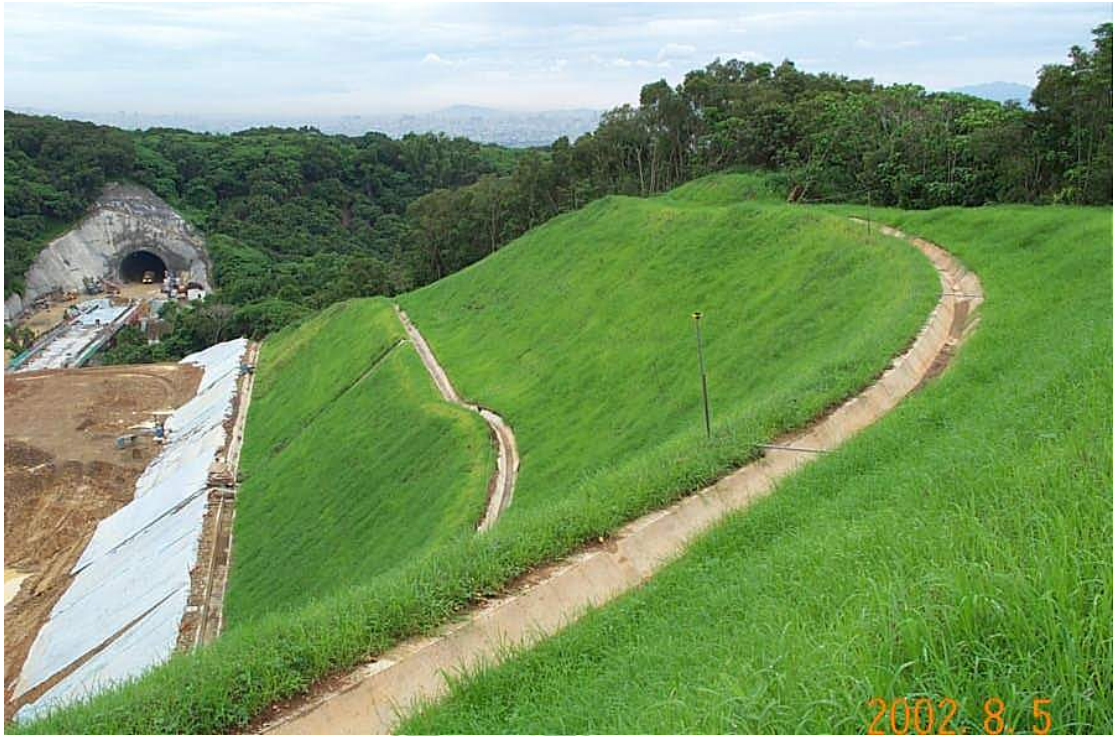
圖 2-12 營建工程工區邊坡於施工階段植被實照
