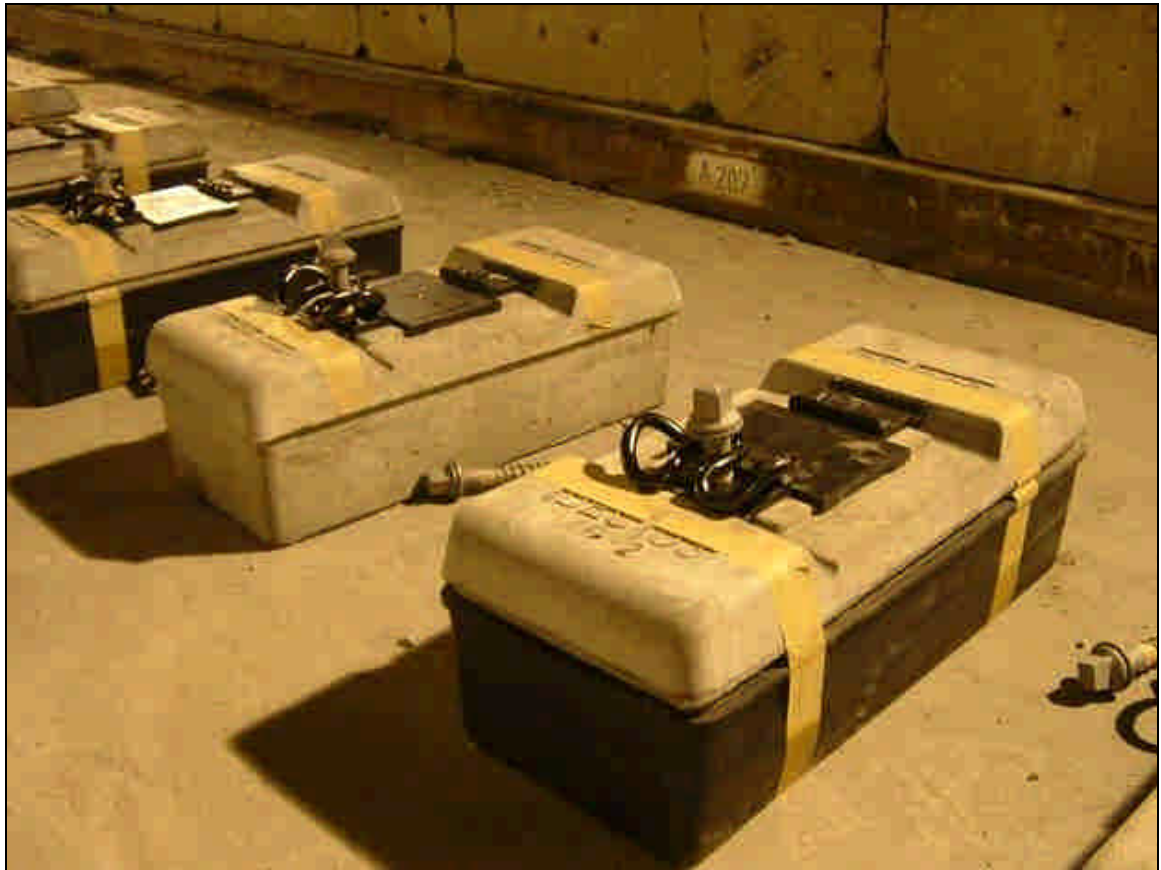
圖 2-18、LVT 所需之扣件分配妥當
