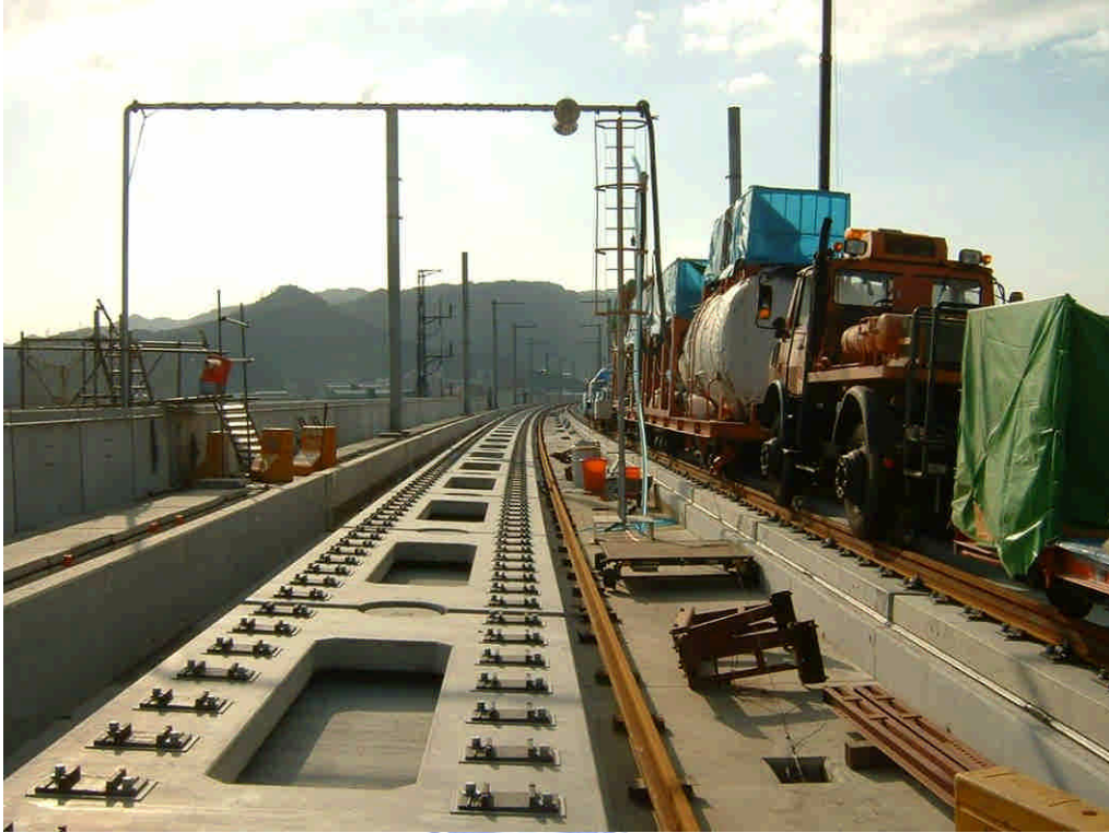
圖 2-9、J-SLAB 之 CA 砂漿拌合及灌注設備
