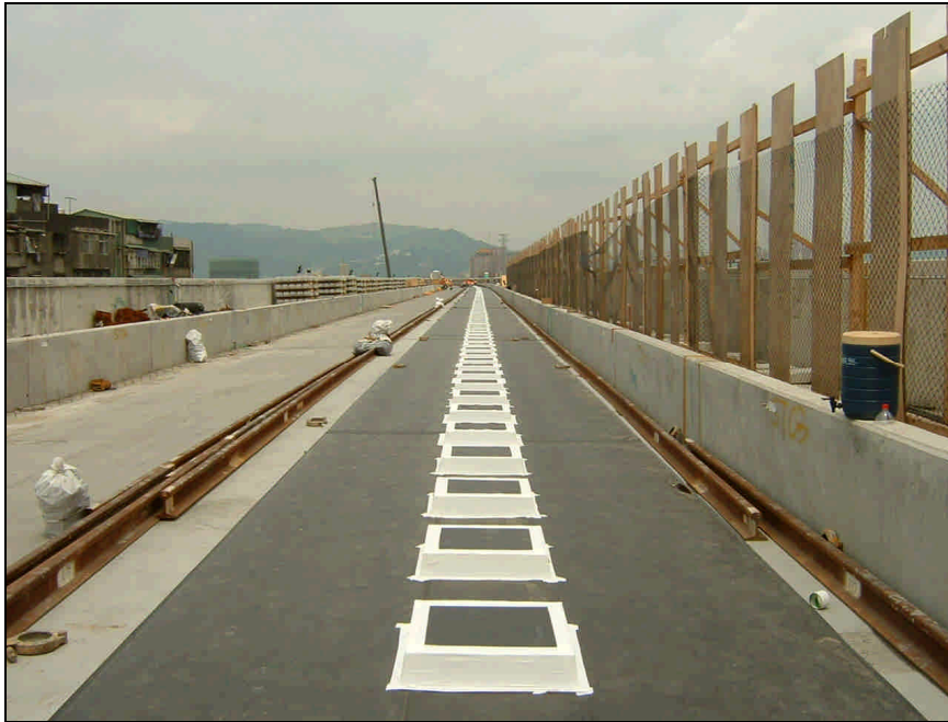
圖 2-23、鋪設完成之橡膠墊層(a)(b)
