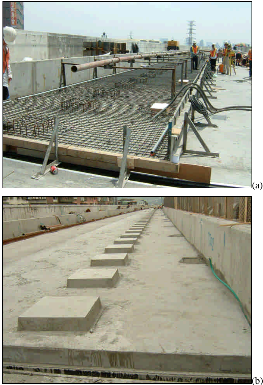
圖 2-22、高架段之 Protection Layer(a)(b)
