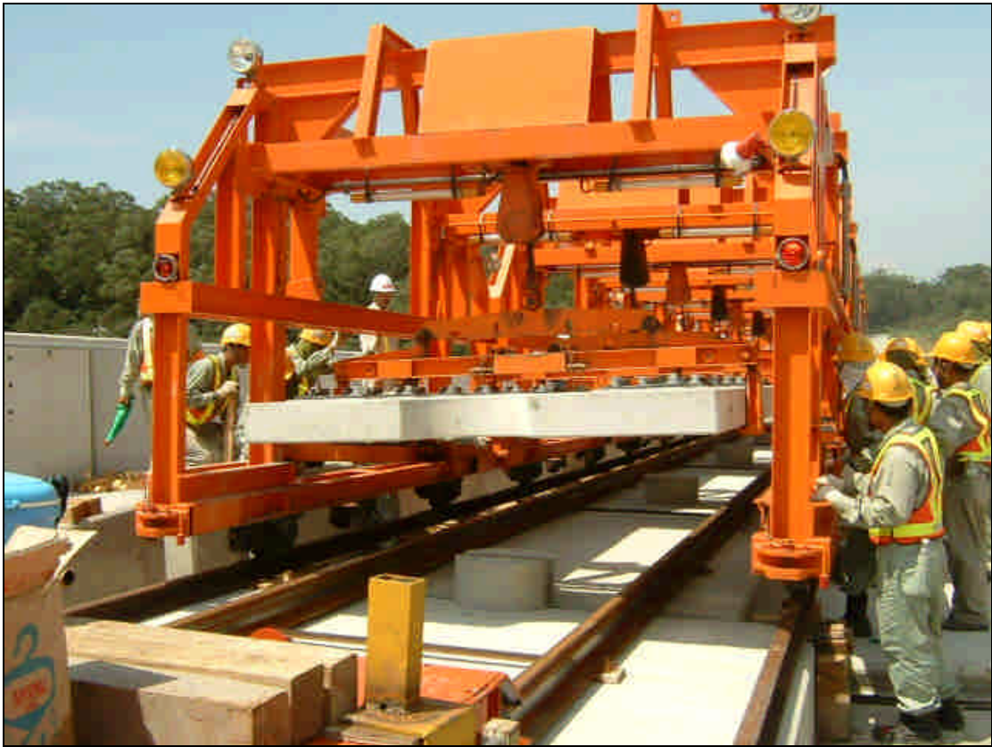
圖 2-7、安裝軌道版鋪車鋪設軌道版
