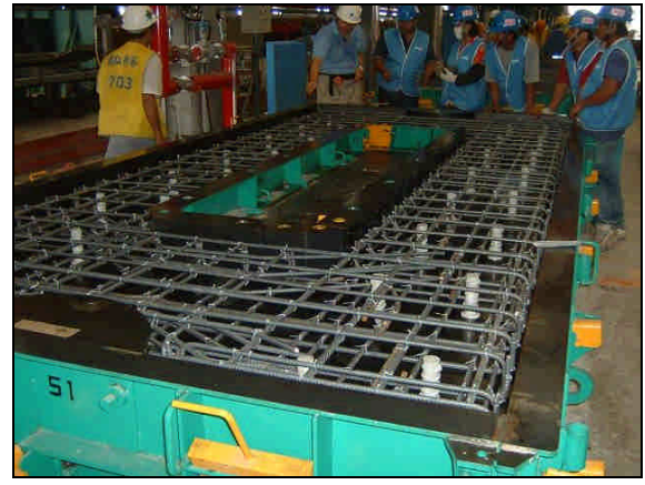
(2)鋼筋籠綁紮及螺栓套管預埋
