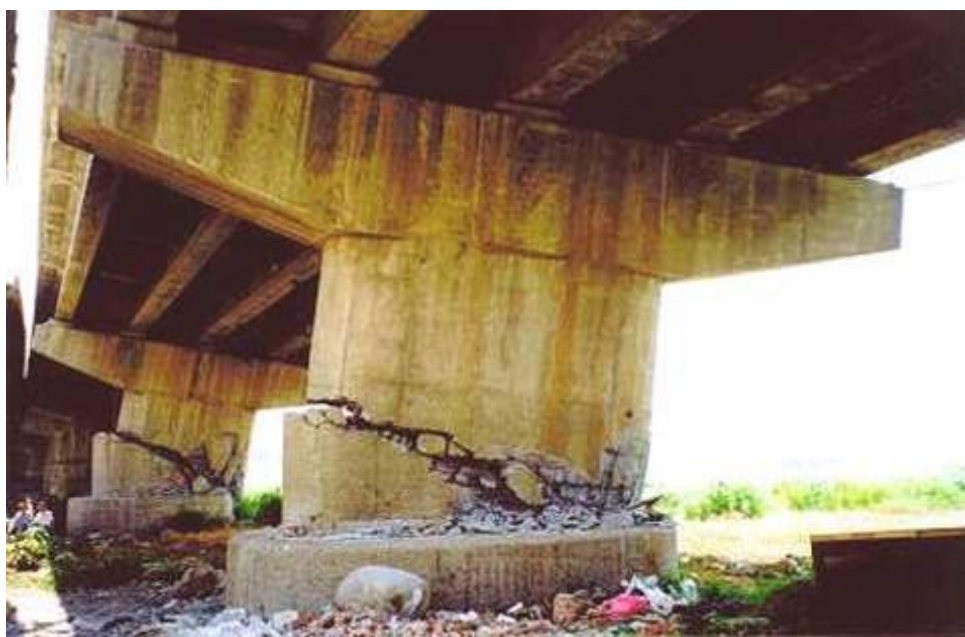
圖3.12 烏溪橋南下線橋墩剪力裂損
