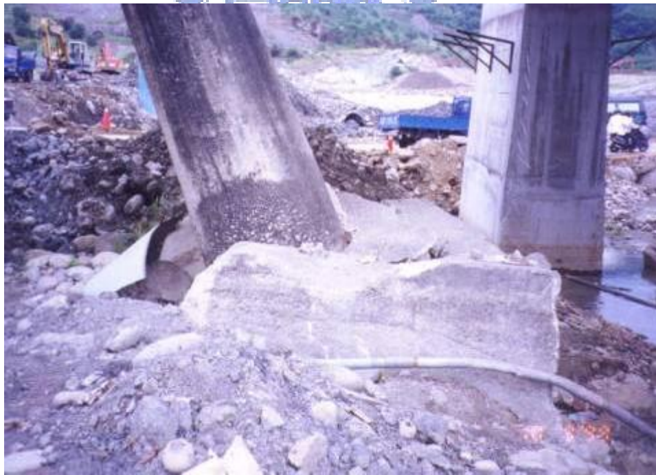
圖3.15 一江橋基礎受推擠損壞傾斜
