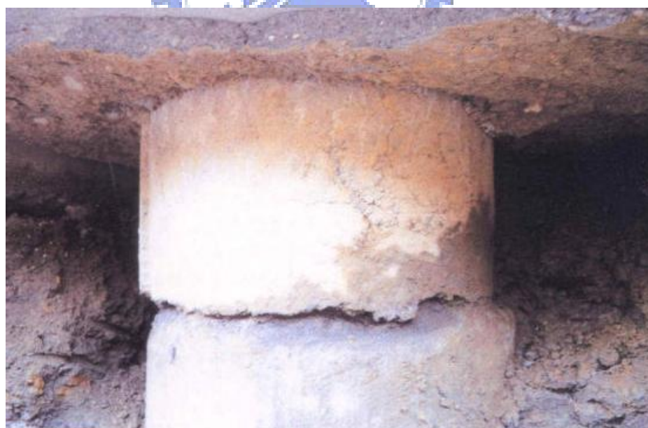
圖3.17 中二高包尾山穿越橋A1橋台基樁受斷層位移推擠而剪斷
