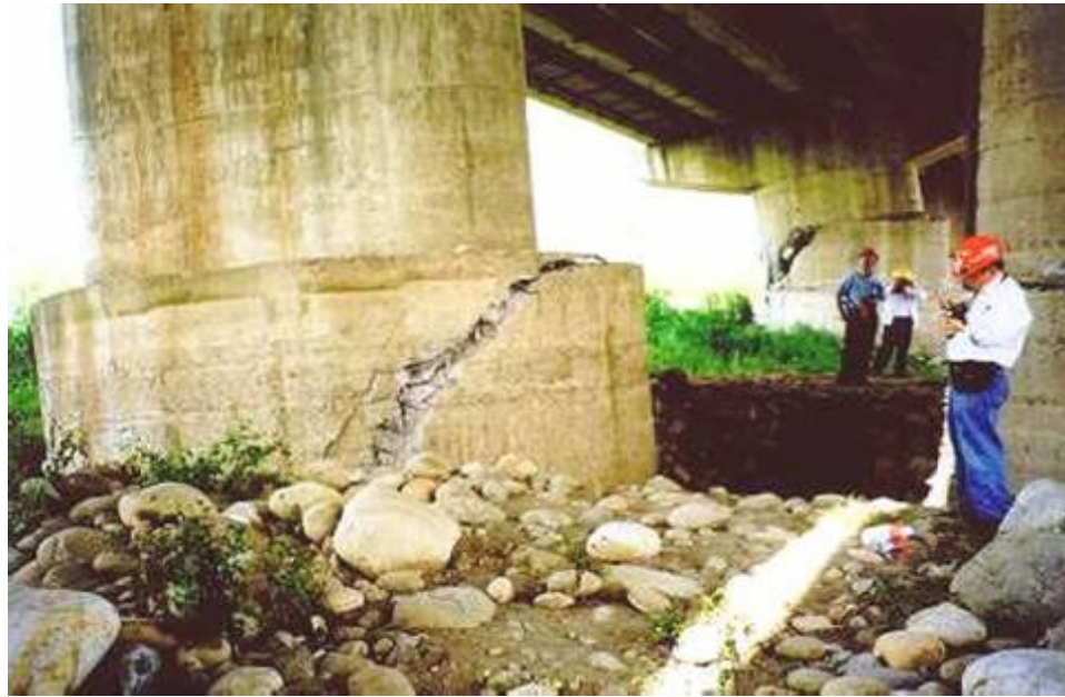
圖3.14 烏溪橋南下線沉箱剪力裂損
