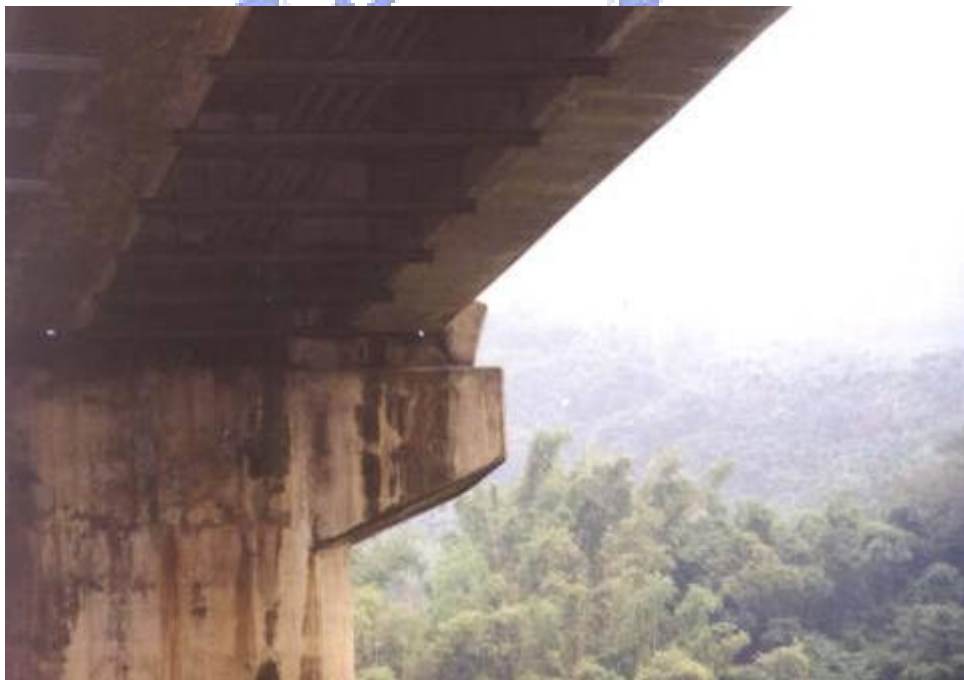
圖3.11 乾峰橋止震塊受損
