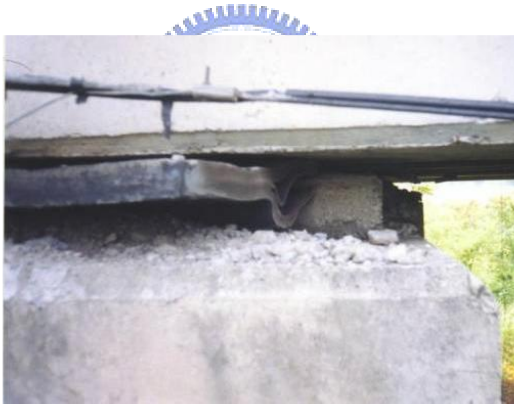
圖3.9 炎峰橋頂力梁之橡膠支承產生移位破壞之情形
