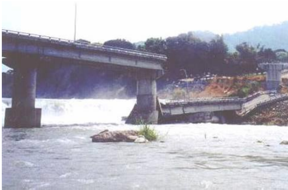
圖3.5 埤豐橋上游斷層錯動產生落差
