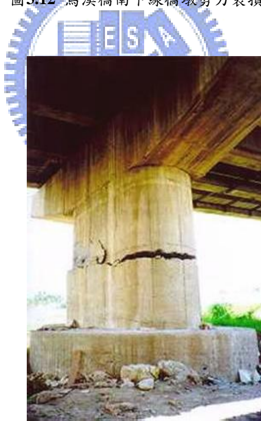
圖3.13 烏溪橋南下線橋墩剪力裂損
