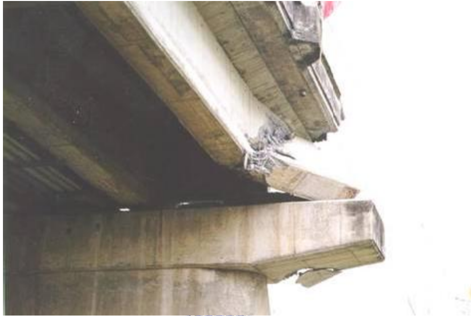
圖3.3 烏溪橋北側東邊第三橋墩上之支承梁端部有折斷之現象
