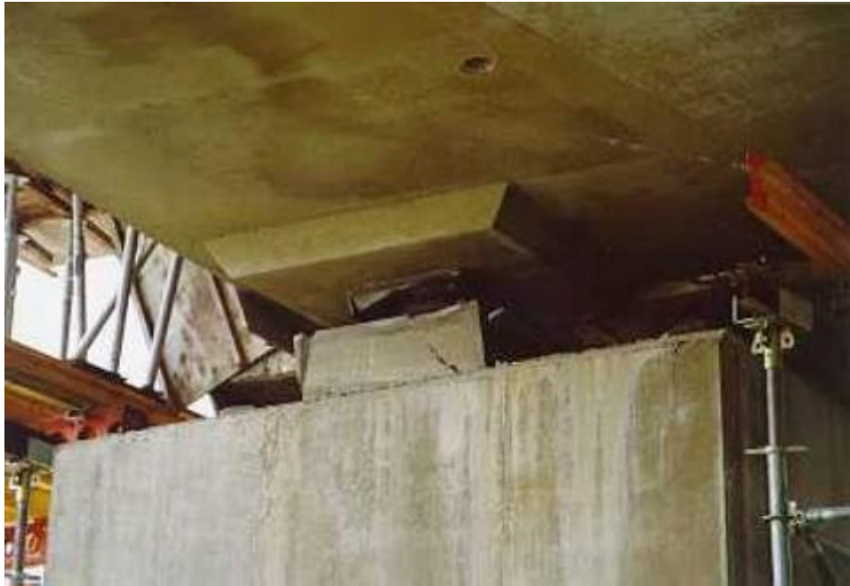
圖3.10 中二高台中環線豐原高架橋橋墊座之毀損情況
