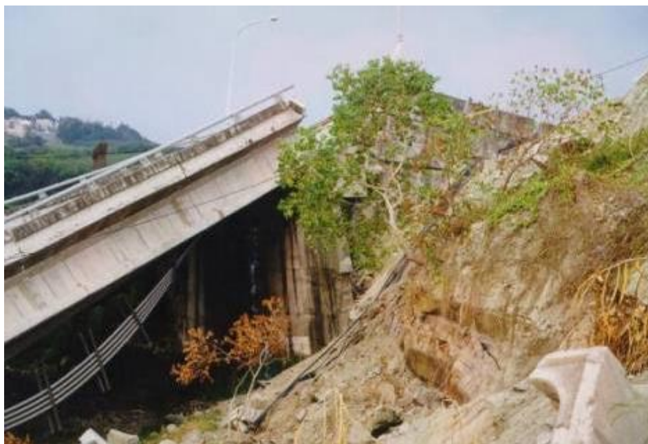
圖3.16 石圍橋橋南側之橋台向北傾斜
