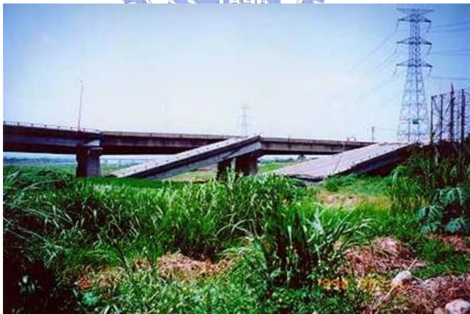
圖3.2 烏溪橋北上線落橋，照片上右側為霧峰端，左側為草屯端，地表破裂帶穿越第三跨，造成第一、二跨落橋
