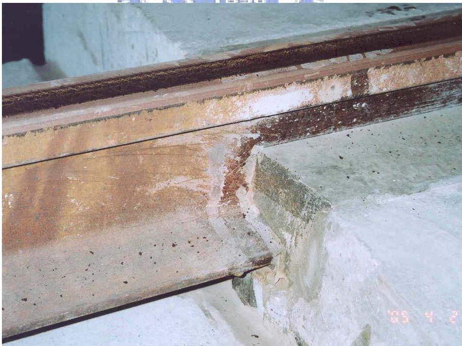
圖 2.8 台灣高鐵直接埋入式軌道示意圖
