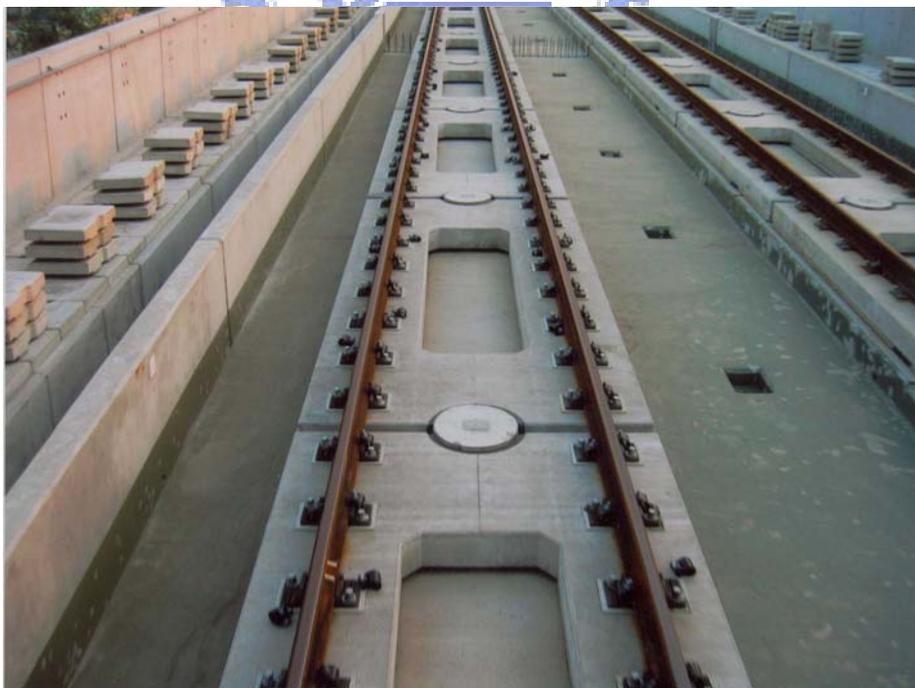
圖 2.10 台灣高鐵日本框架式道床軌道示意圖
