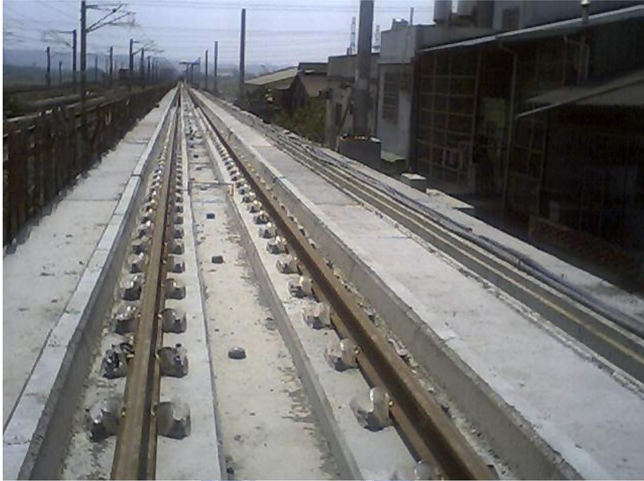
圖 2.5 台鐵混凝土基座道床軌道示意圖
