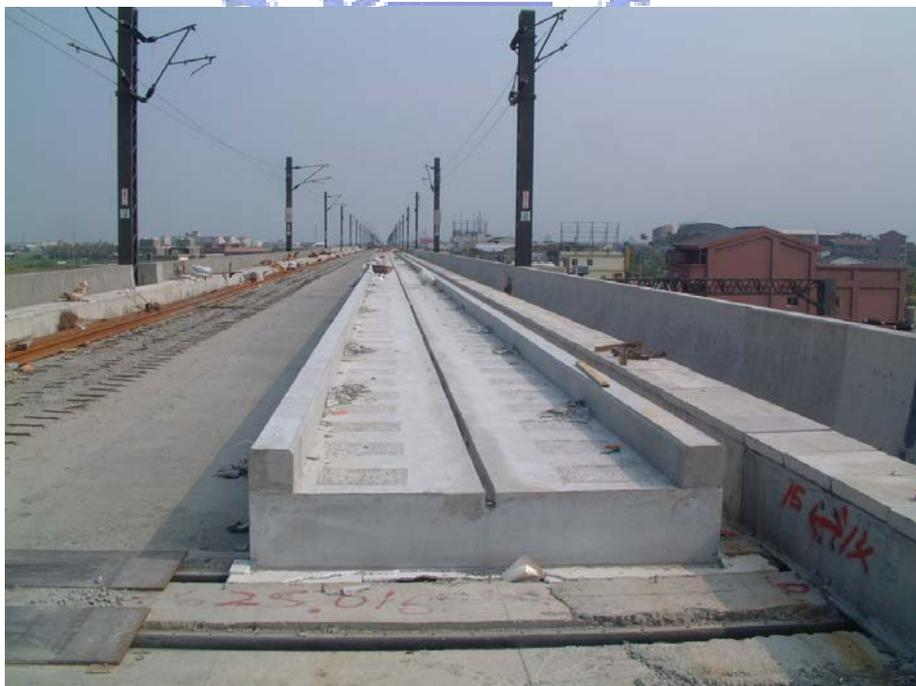
圖 2.4 台鐵平版式道床軌道示意圖
