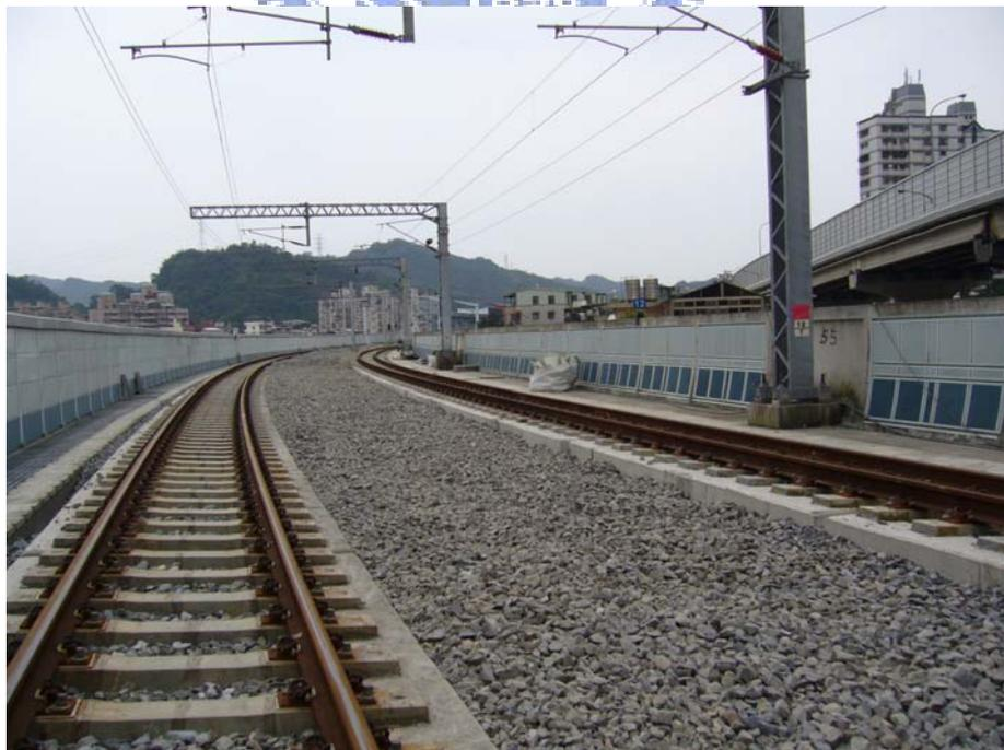
圖 2.13 石碴散佈型軌枕埋入式軌道示意圖
