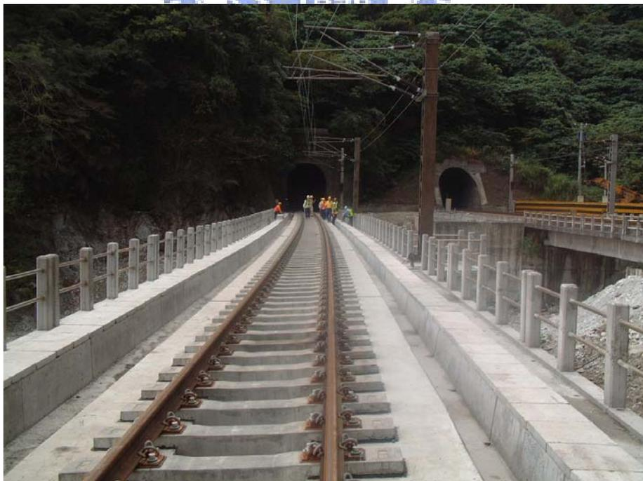
圖 2.6 台鐵軌枕埋入式軌道示意圖
