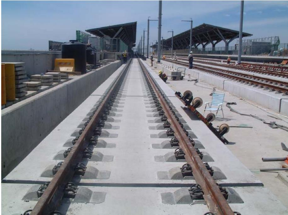
圖 2.7 台灣高鐵軌枕埋入式軌道示意圖
