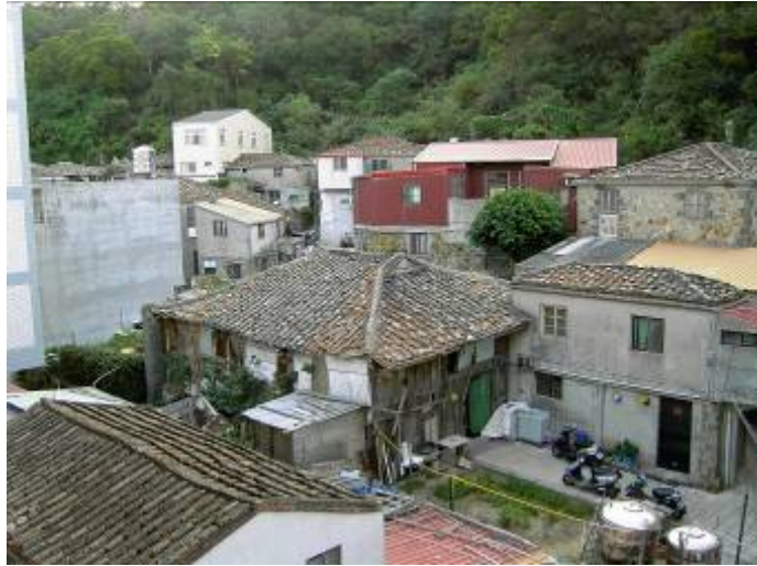
房屋緊鄰且無防火巷觀念（南竿鄉介壽村）
