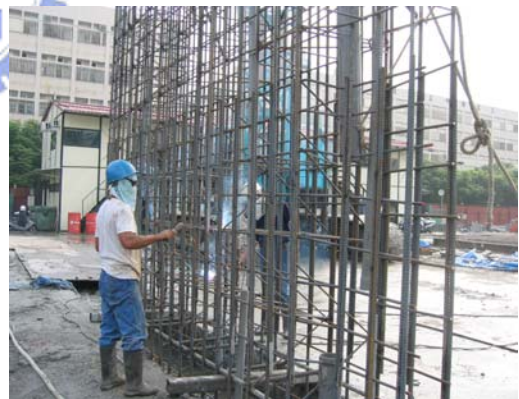
3. 鋼筋籠搭接作業
