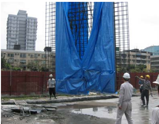
2. 鋼筋籠吊放作業
