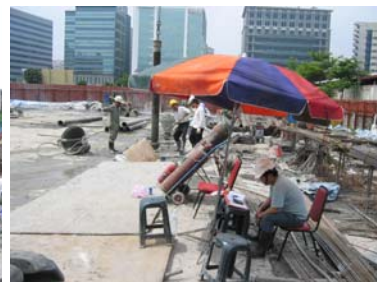
15.SCC 澆築記錄作業
