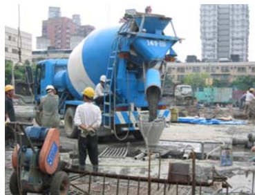
14.SCC 澆築作業
