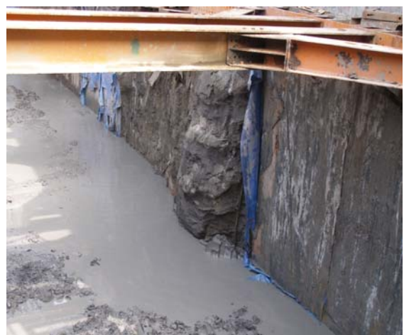
照片 4-6 坍孔造成牆面不平整
