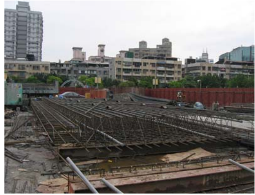
1. 鋼筋籠加工組立
