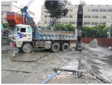
1.連續壁挖掘作業
