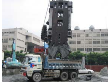
2.連續壁挖掘作業
