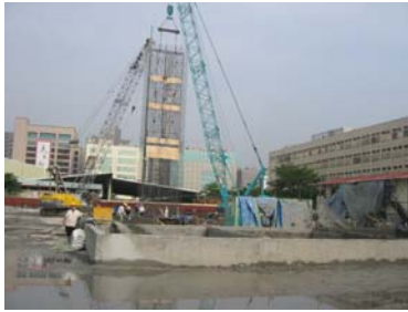
4.公單元鋼筋籠吊放
