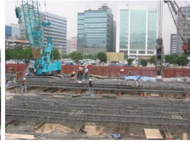
3.鋼筋籠加工組立
