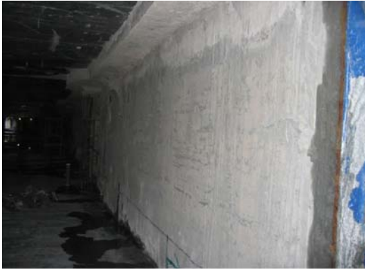
照片 5-3 參考甲案工程 SCC 壁體表面
