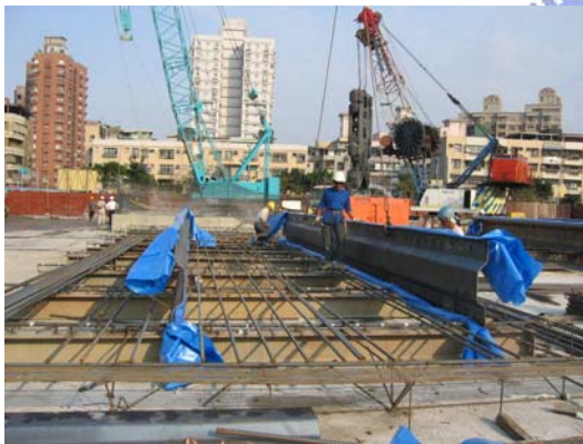
照片 4-2 端版凹型鋼板
