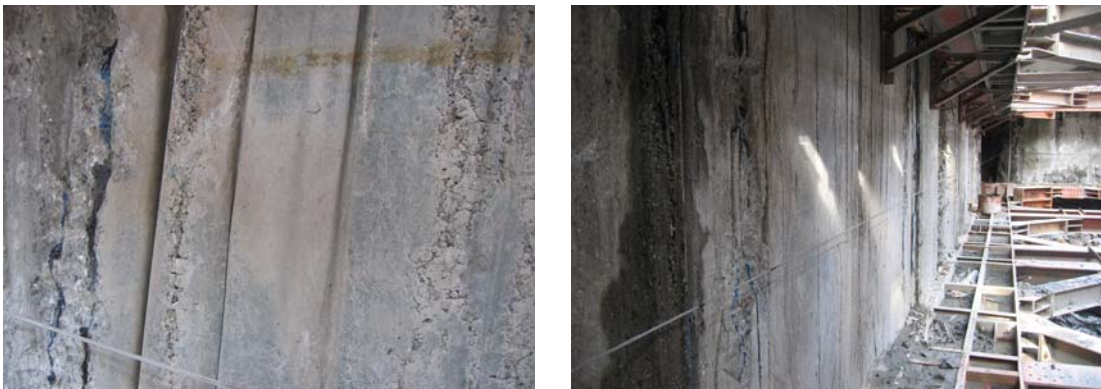
照片 5-2 案例工程塑膠帆布當壁面時則呈現非常光滑平整之表面
