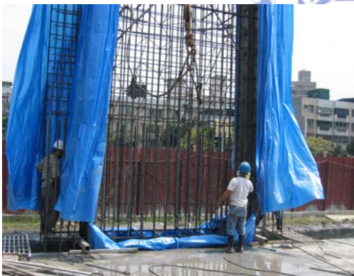
3. 鋼筋籠搭接作業
