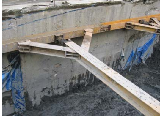
照片 5-3 參考甲案工程 SCC 壁體表面
