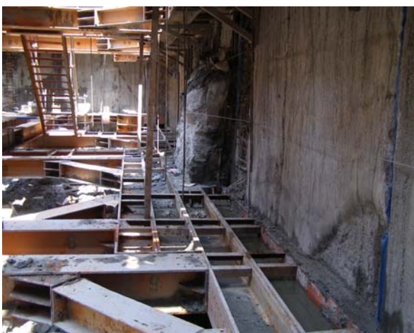
照片 4-6 坍孔造成牆面不平整
