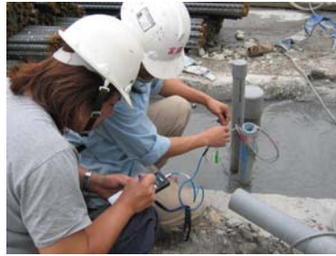
5.監測儀器安裝測試
