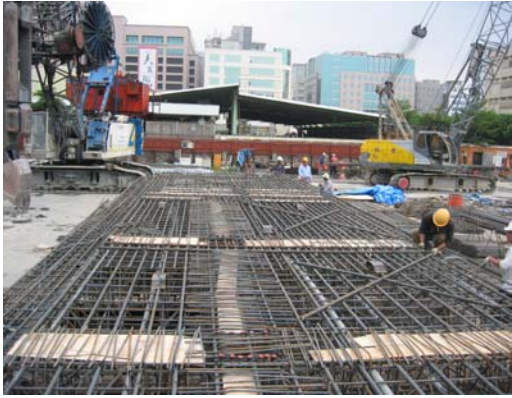
1. 鋼筋籠加工組立
