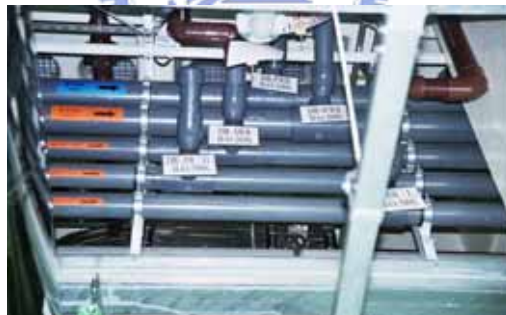
圖4.2 機台下方排水管路採樣點示意圖
