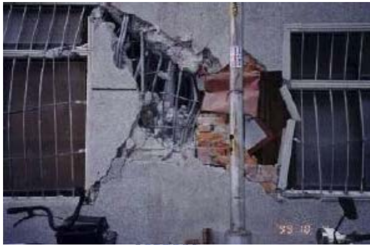
圖 3.1(b) 短柱效應造成短柱的剪力破壞 (圖片來源：國家地震中心)
