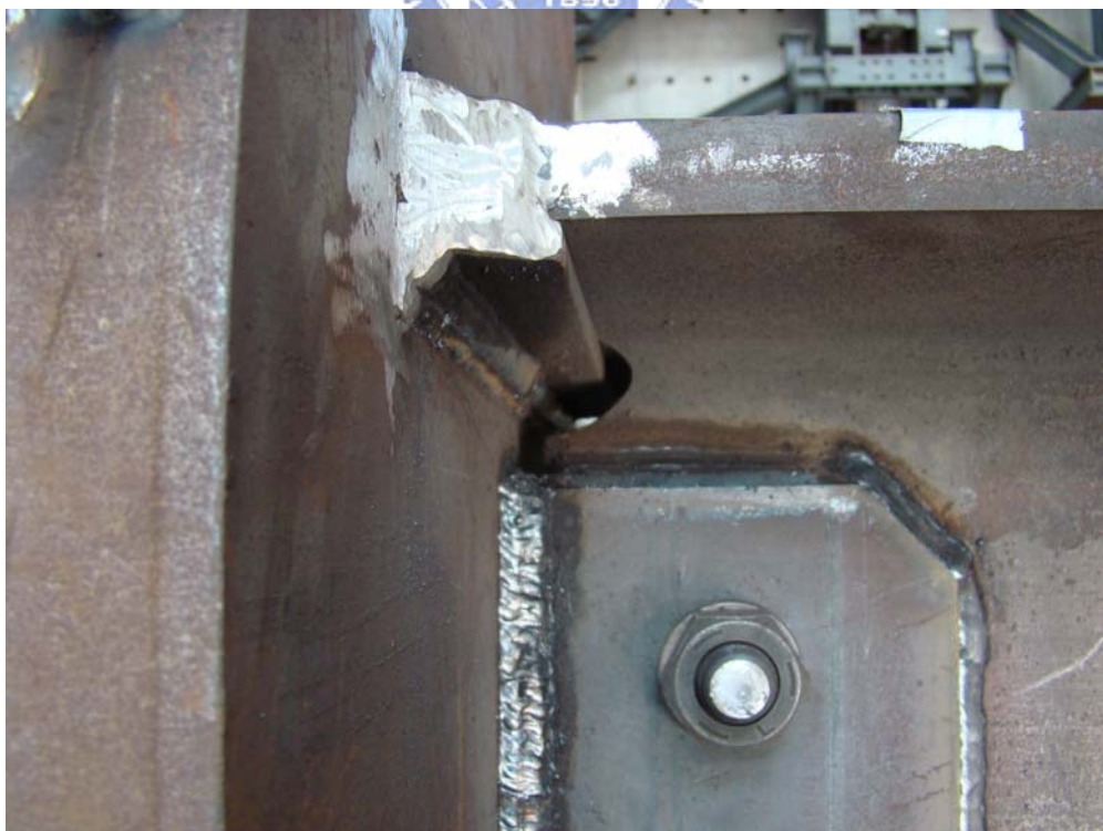
照片 3.12 上下翼板背墊板未移除，並在背墊板下方再增加填角鉚
