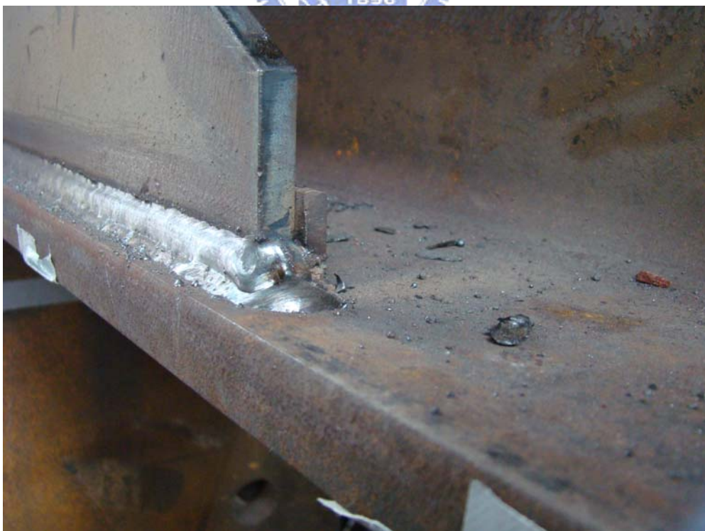
照片 3.10 梁翼內側且在兩翼最外側往內縮 15 mm 處加設兩塊加勁板
