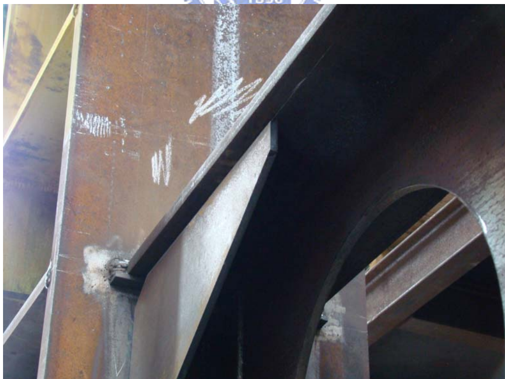
照片 3.8 梁翼內側且兩翼最外側往內縮 15 mm 處加設兩塊加勁板(續)
