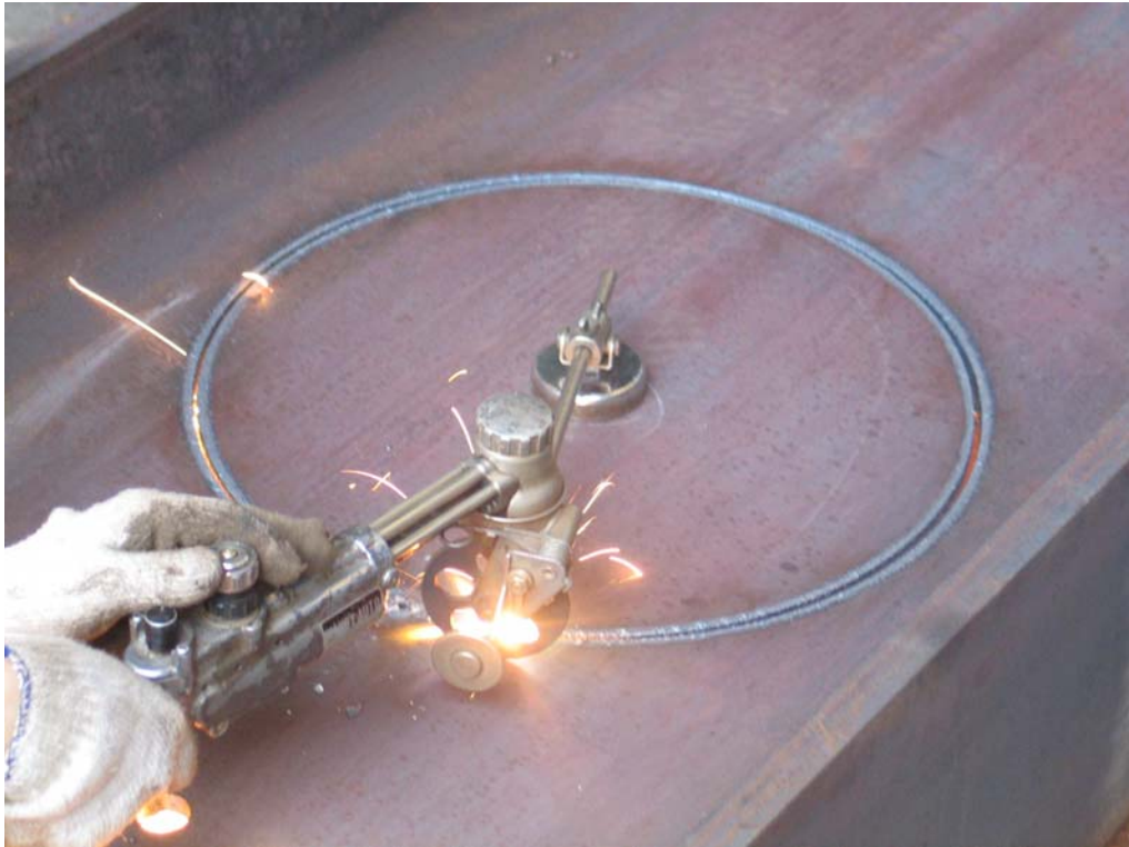
照片 3.1 梁腹板開一個直徑為 0.65 倍梁深的圓孔
