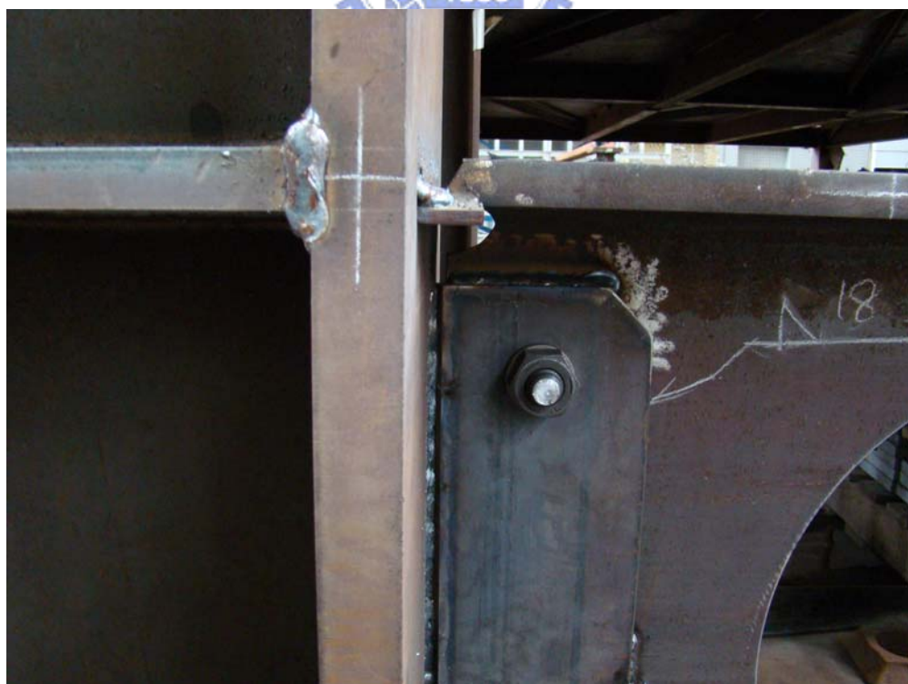
照片 3.6 梁腹板與柱翼板採用 30 度全滲透開槽鉚結合
